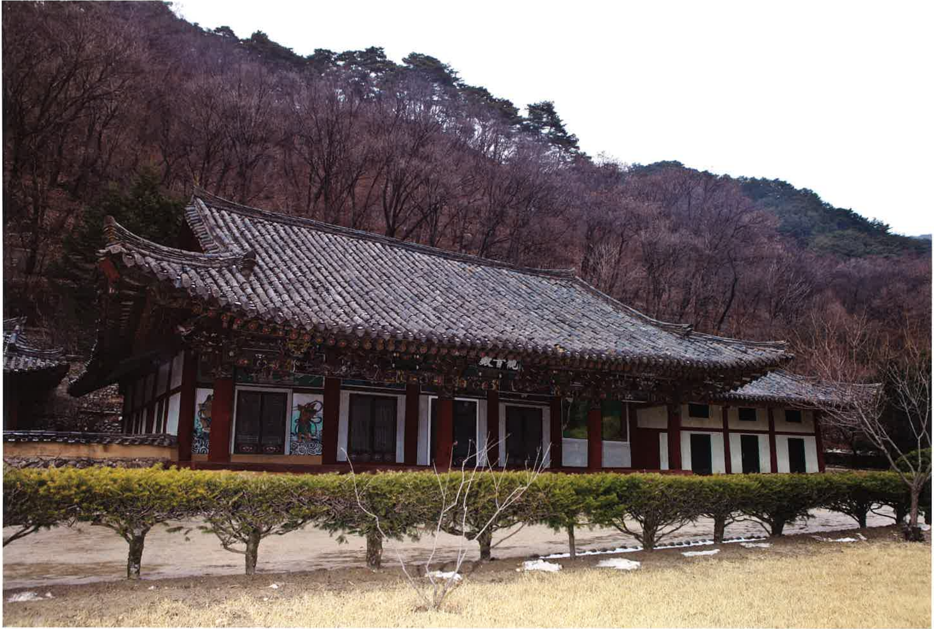
관음전 전경 / 觀音殿 全景 / whole view, Kwanŭmjŏn hall
