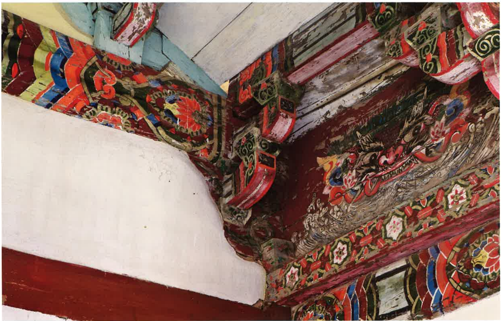
조계문 내부 귀포 / 曹溪門 內部 耳包 / corner brackets, Chogyemun gate
