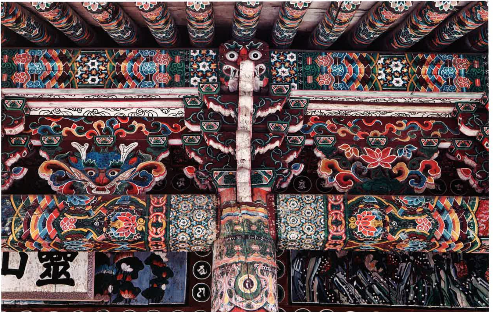
영산전 앞면 액방과 도리, 장혀 / 靈山殿 前面 額枋·道里·長舌 / front lintel and girder, strip of wood supporting a beam, Yongsanjön hall
