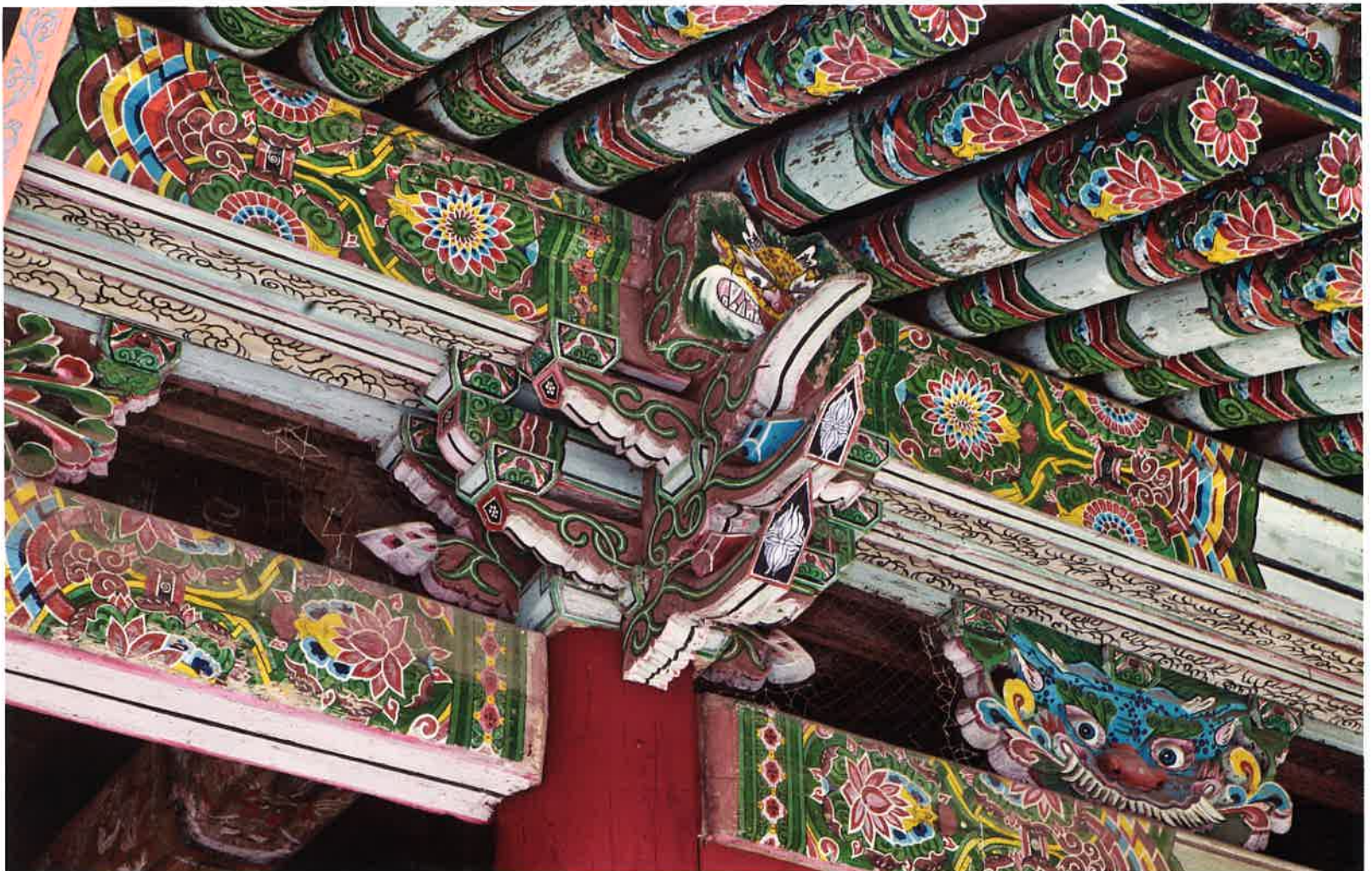
천왕문 앞면 주상포 / 天王門 前面 柱上包 / brackets above front columns, Ch'önwangmun gate
