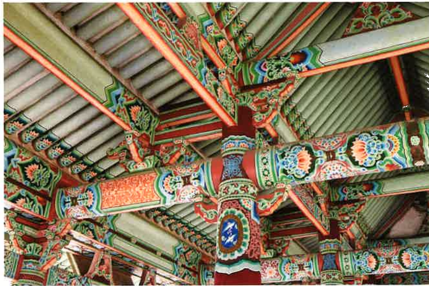
만세루 내부 고주와 대들보 / 萬歲樓 內部 高柱·大樑 highly pole supporter and main beam, Manseru
