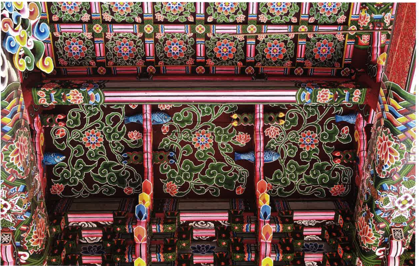
대웅전 내부 빗반자 / 大雄殿 内部 斜天障 / inclined ceiling, Taeungjŏn hall
