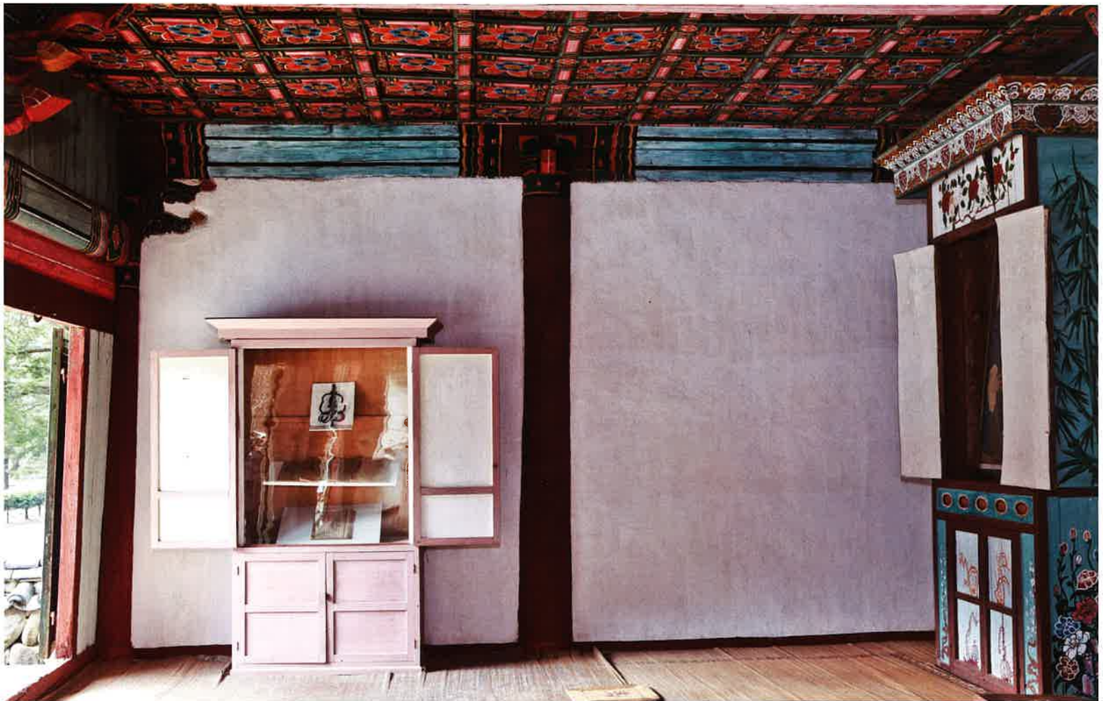
수충사 본전 서쪽 측면 벽체 / 酬忠祠 本殿 西側 壁體 / western wall, Such'ungsa
