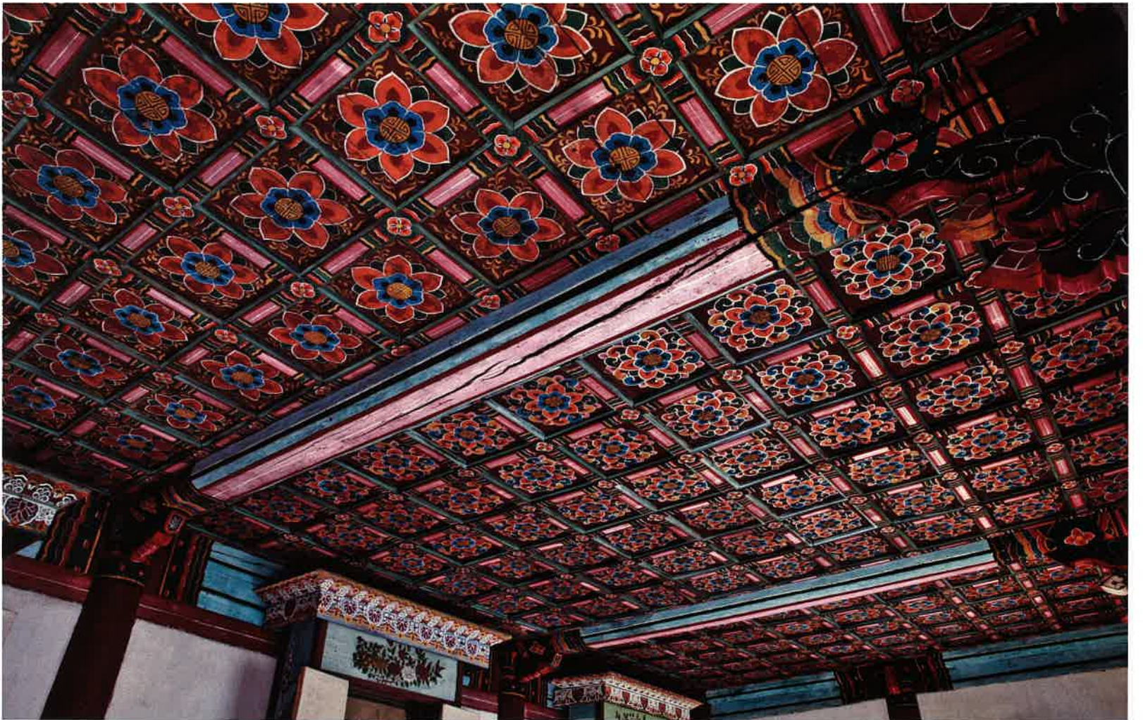
수충사 본전 내부 소란반자 / 酬忠祠 本殿 內部 格子天障 / latticed ceiling, Such'ungsa
