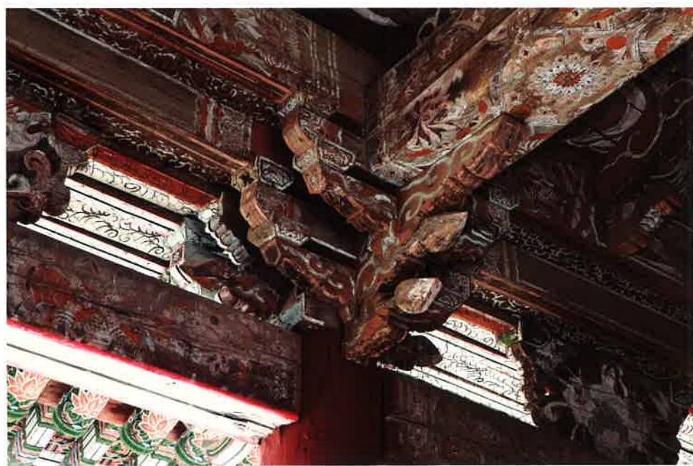
천왕문 내부 주상포 / 天王門 內部 柱上包 / brackets above columns, Ch'ŏnwangmun gate
