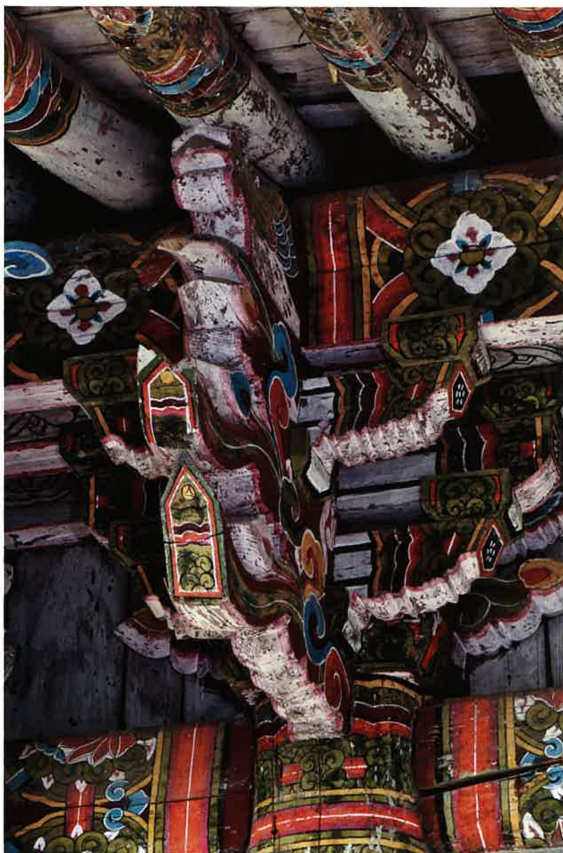
수충사 본전 앞면 주상포 / 酬忠祠 本殿 前面 柱上包 brackets above front columns, Such'ungsa
