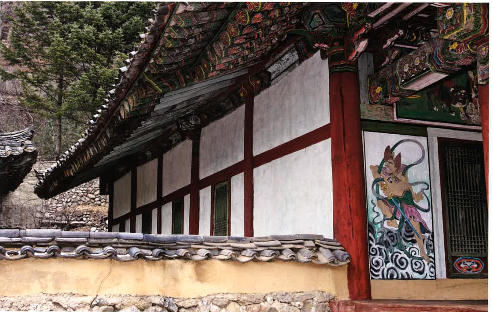
관음전 서쪽 측면 벽체 / 觀音殿 西側 壁體 / western wall, Kwanŭmjŏn hall
