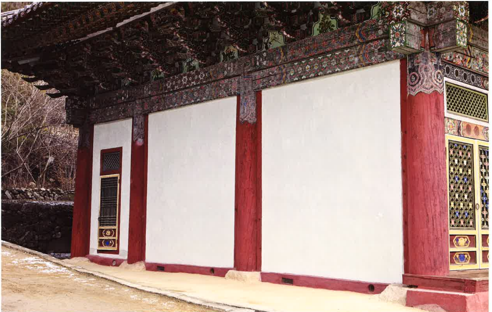
대웅전 서쪽 측면 벽체 / 大雄殿 西側 壁體 / western wall, Taegungjon hall
