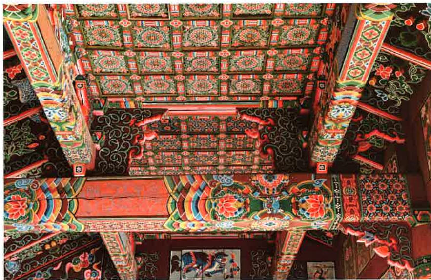
영산전 내부 화반대공 / 靈山殿 內部 花盤臺工 / pillar to hold purlins, Yongsanjön hall
