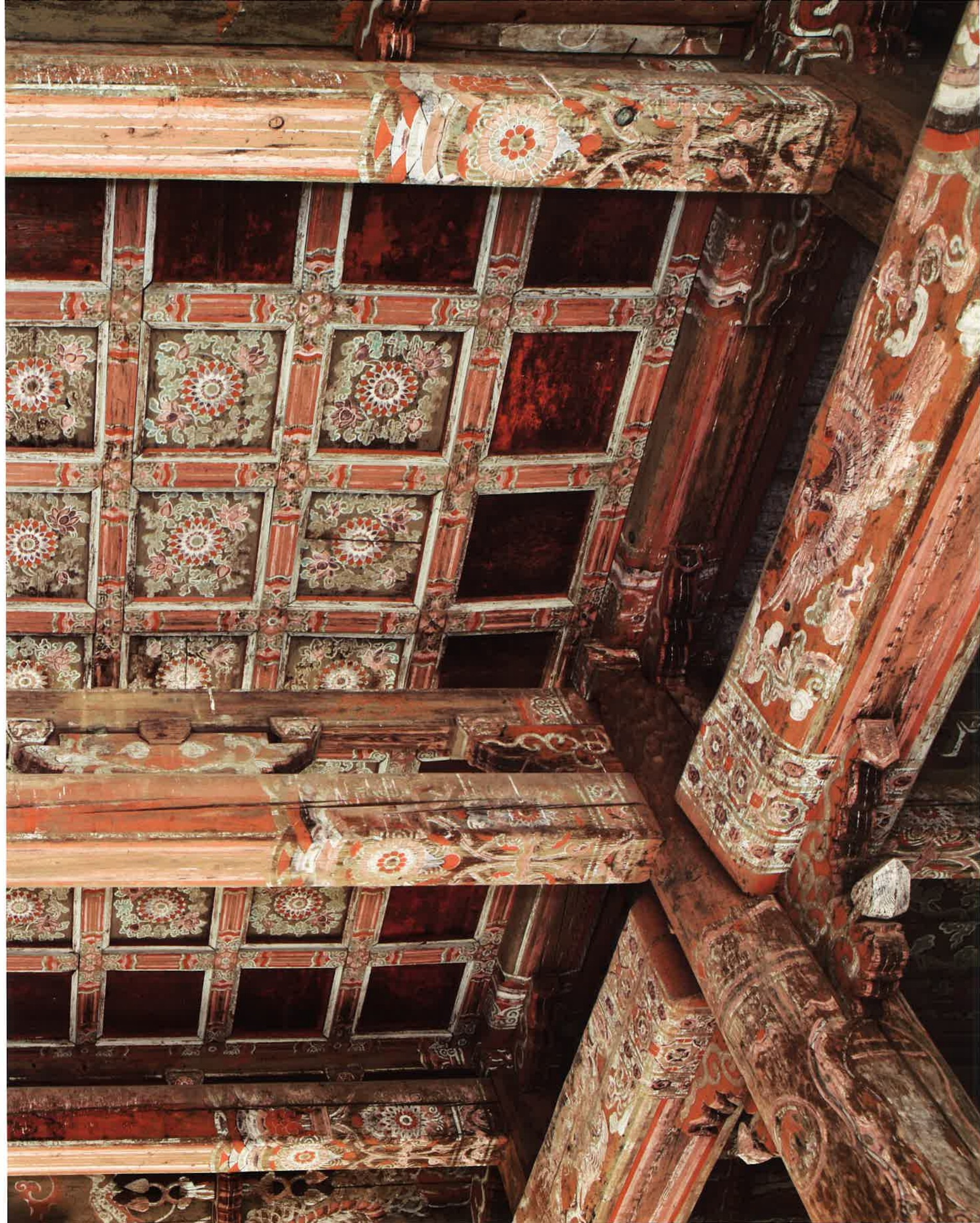
천왕문 내부 우물천장 / 天王門 內部 格子天障 / latticed ceiling, Ch'ônwangmun gate
