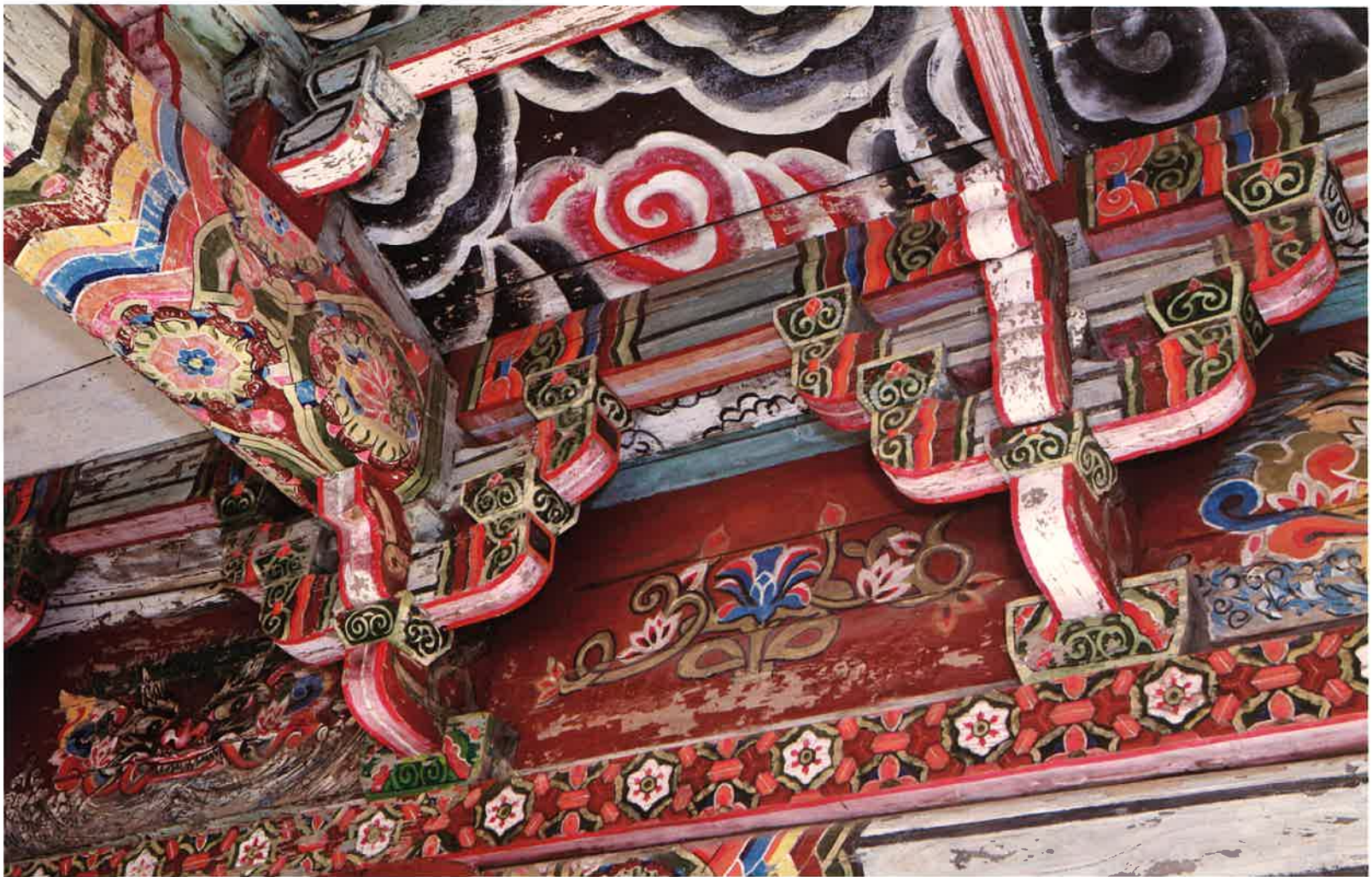
조계문 내부 주간포 / 曹溪門 內部 柱間包 / brackets between columns, Chogyemun gate
