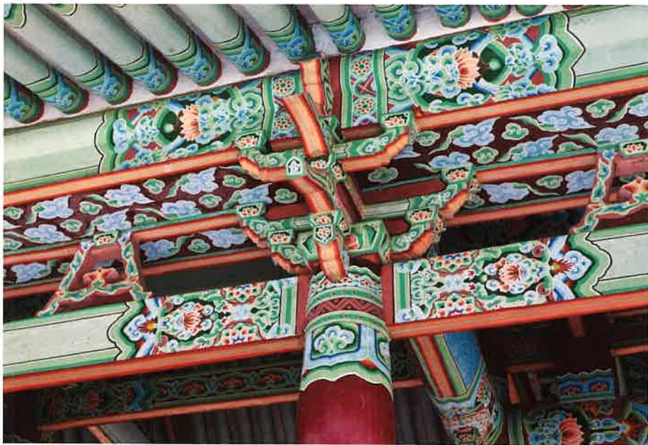
만세루 주상포 / 萬歲樓 柱上包 / brackets above columns, Manseru
