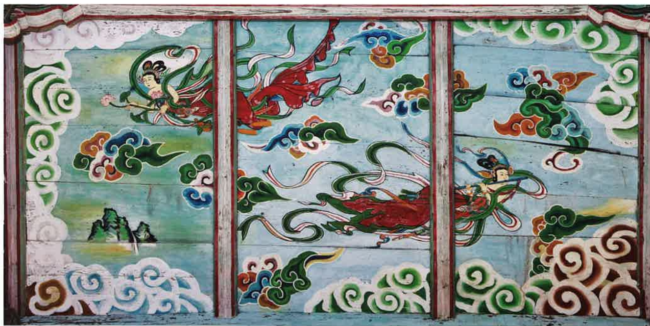
해탈문 내부 반자 별화 / 解脱門 内部 天障 別畫 / attached paintings on ceiling, Hat'almun gate
