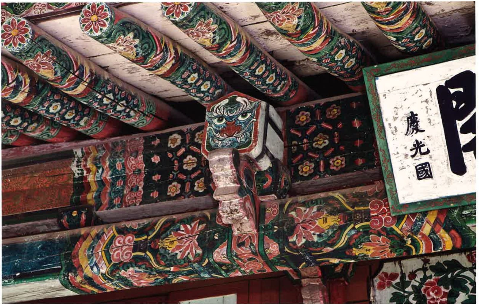
만수각 앞면 주상포 / 萬壽閣 前面 柱上包 / brackets above front columns, Mansugak
