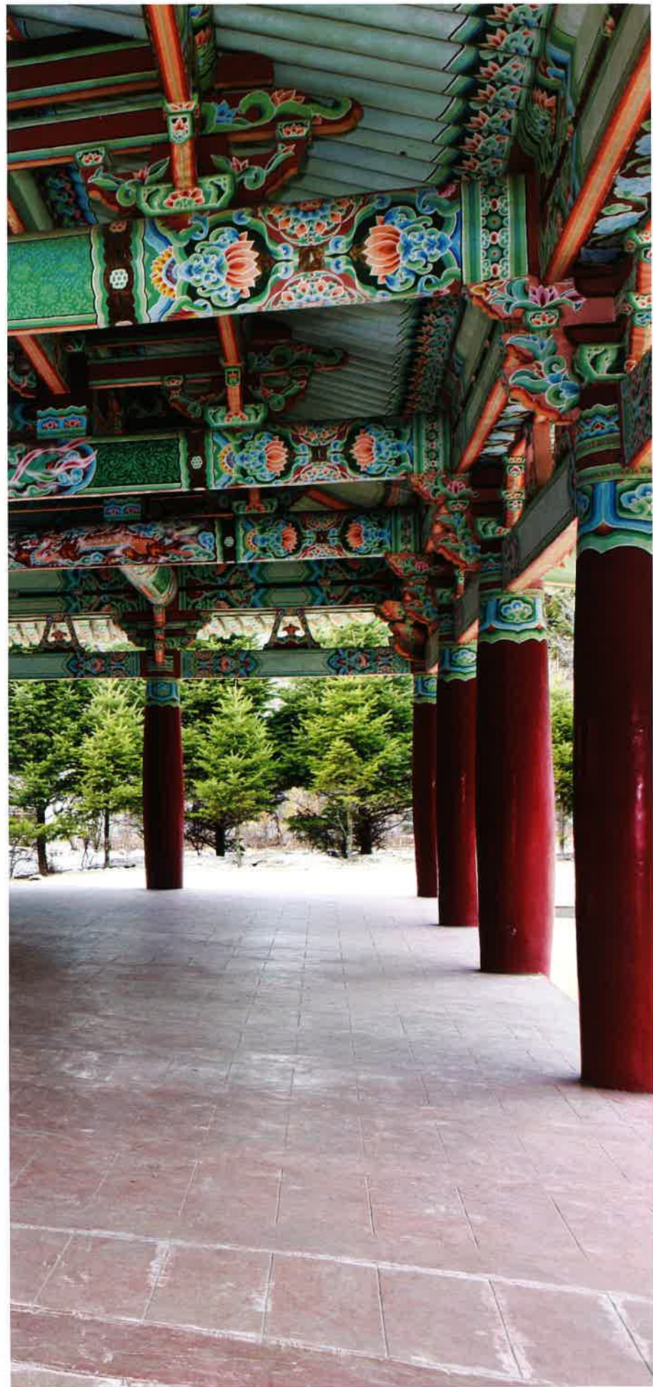
만세루 내부 전경 / 萬歲樓 內部 全景 / inside whole view, Manseru
