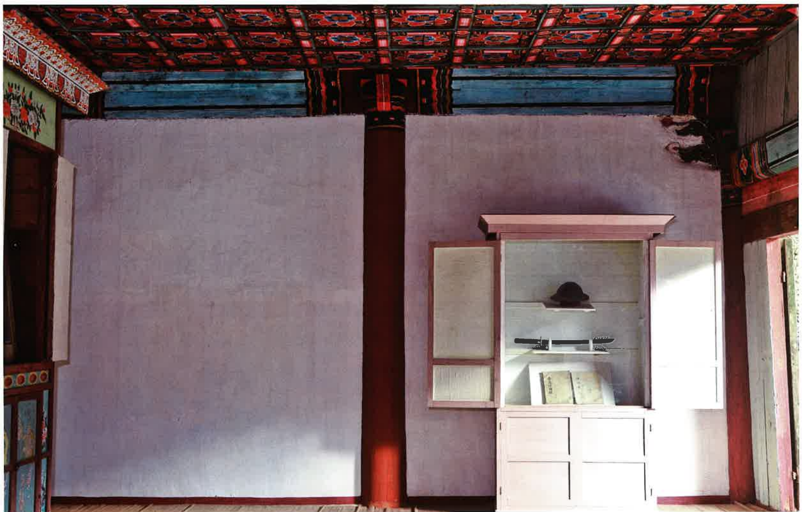
수충사 본전 동쪽 측면 벽체 / 酬忠祠 本殿 東側 壁體 / eastern wall, Such'ungsa
