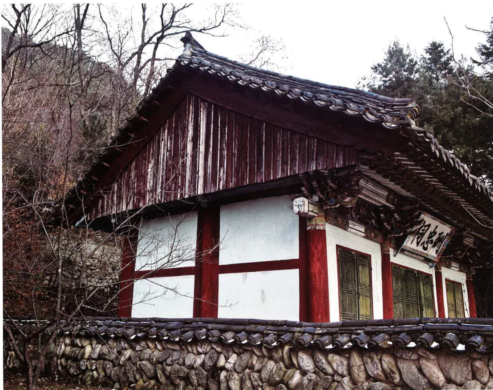
수충사 본전 서쪽 측면 / 酬忠祠 本殿 西側面 / front western side, Such'ungsa
