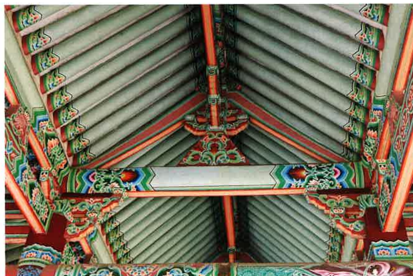
만세루 내부 중보 / 萬歲樓 內部 宗樑 / collarbeam, Manseru
