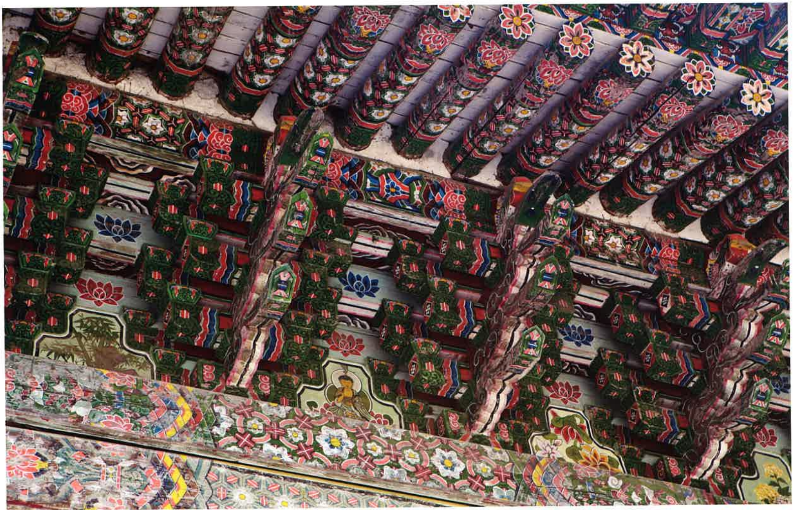
대웅전 앞면 공포 / 大雄殿 前面 拱包 / front brackets, Taegungjeon hall
