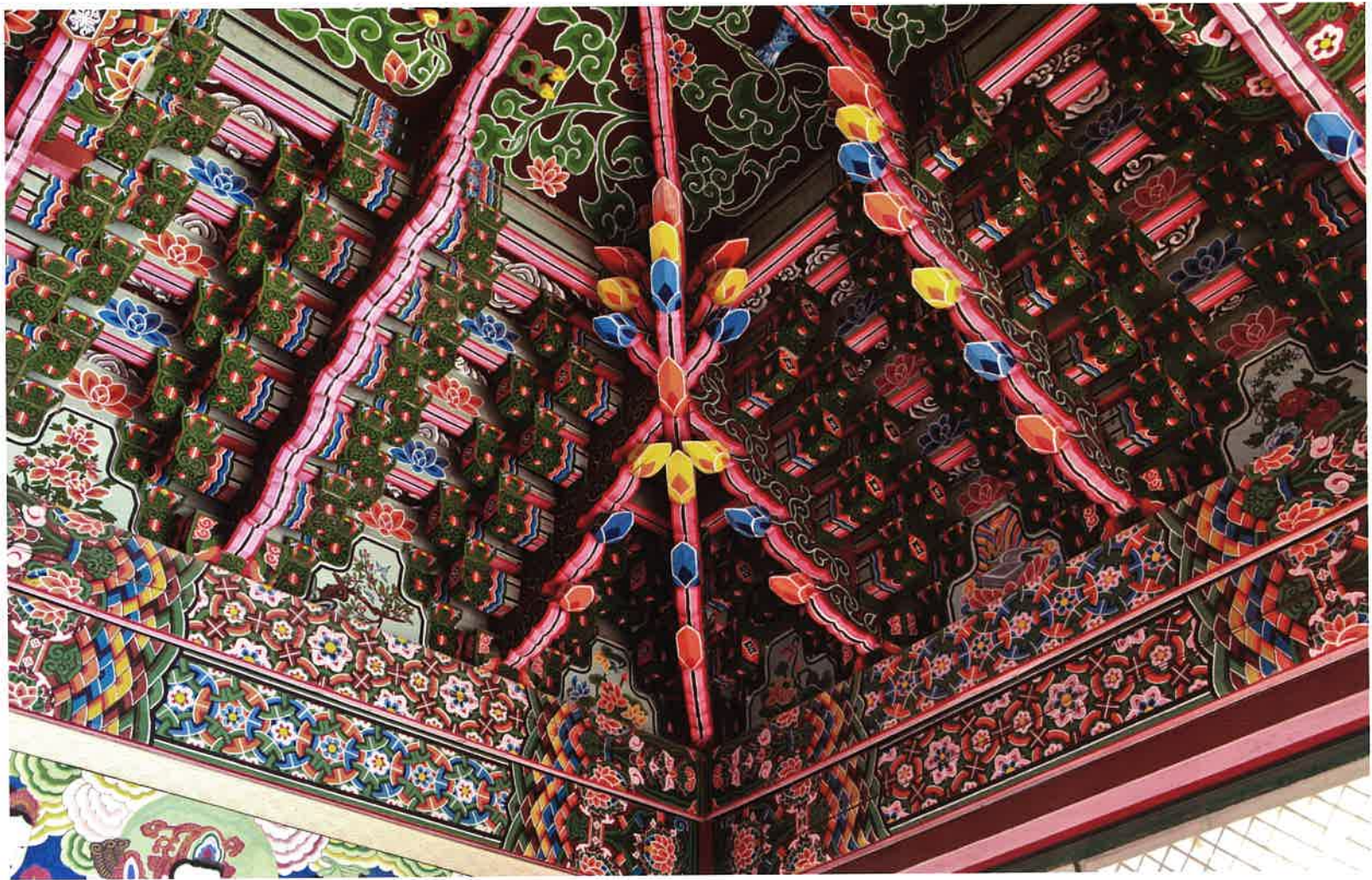
대웅전 내부 앞면 귀포 / 大雄殿 内部 前面 耳包 / front corner brackets, Taegungjon hall
