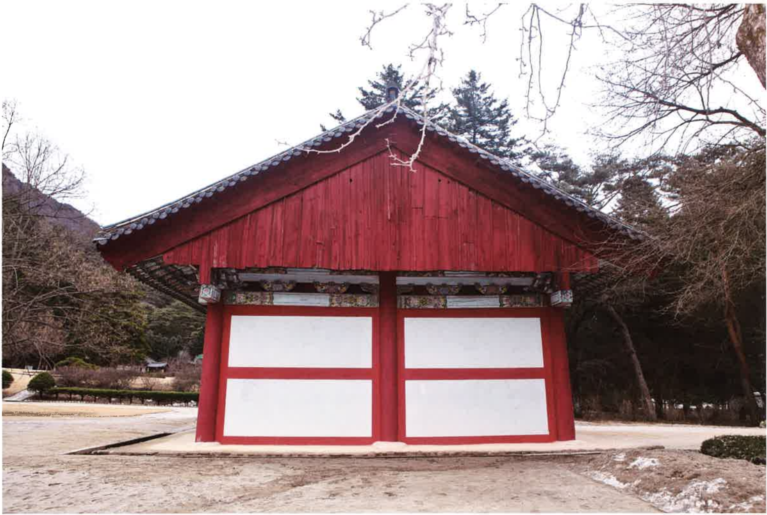
천왕문 동쪽 측면 / 天王門 東側面 / eastern side, Ch'önwangmun gate
