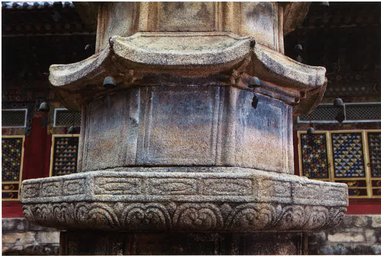
보현사 8각13층탑 기단 / 普賢寺 八角十三層塔 基壇 / stylobate of 8-angled and 13-storied pagoda, Pohyōnsa
