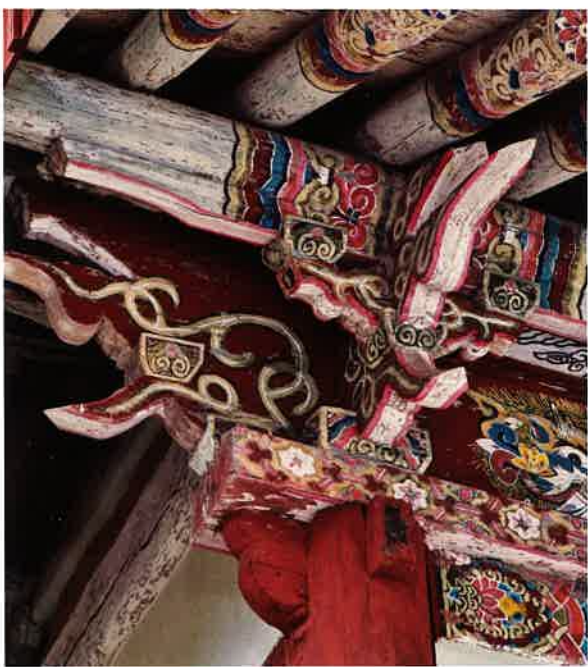
조계문 서쪽 귀포 / 曹溪門 西側 耳包 western corner brackets, Chogyemun gate
