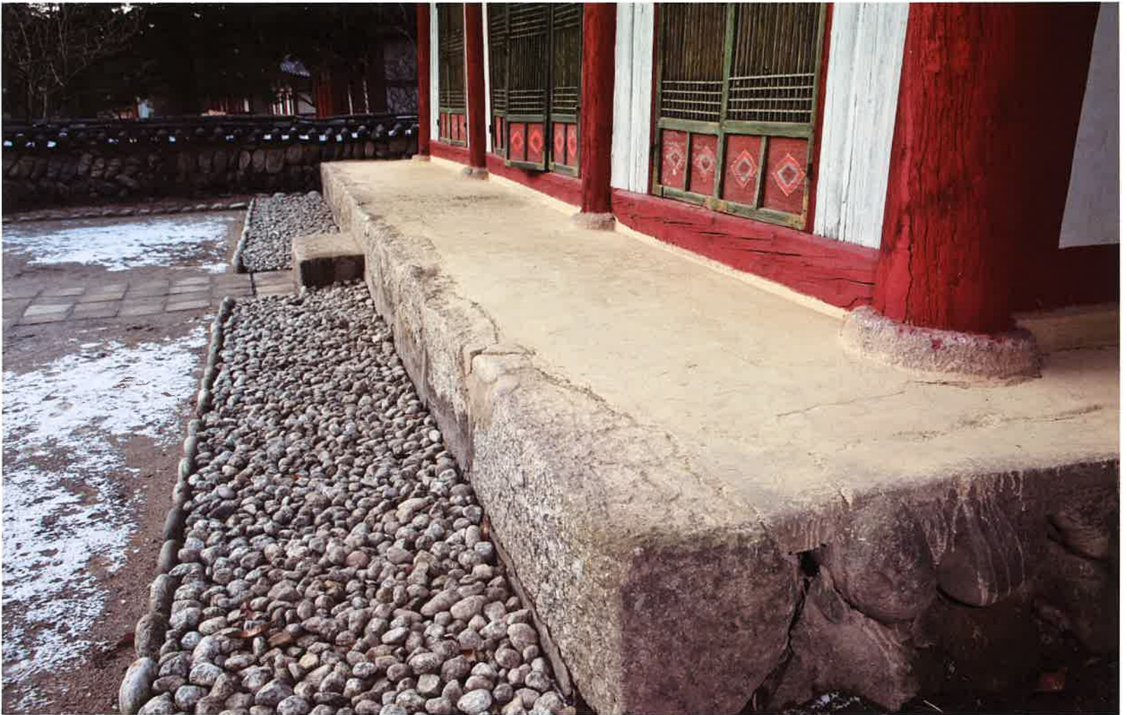
수충사 본전 앞면 기단 / 酬忠祠 本殿 前面 基壇 / front stylobate, Such'ungsa
