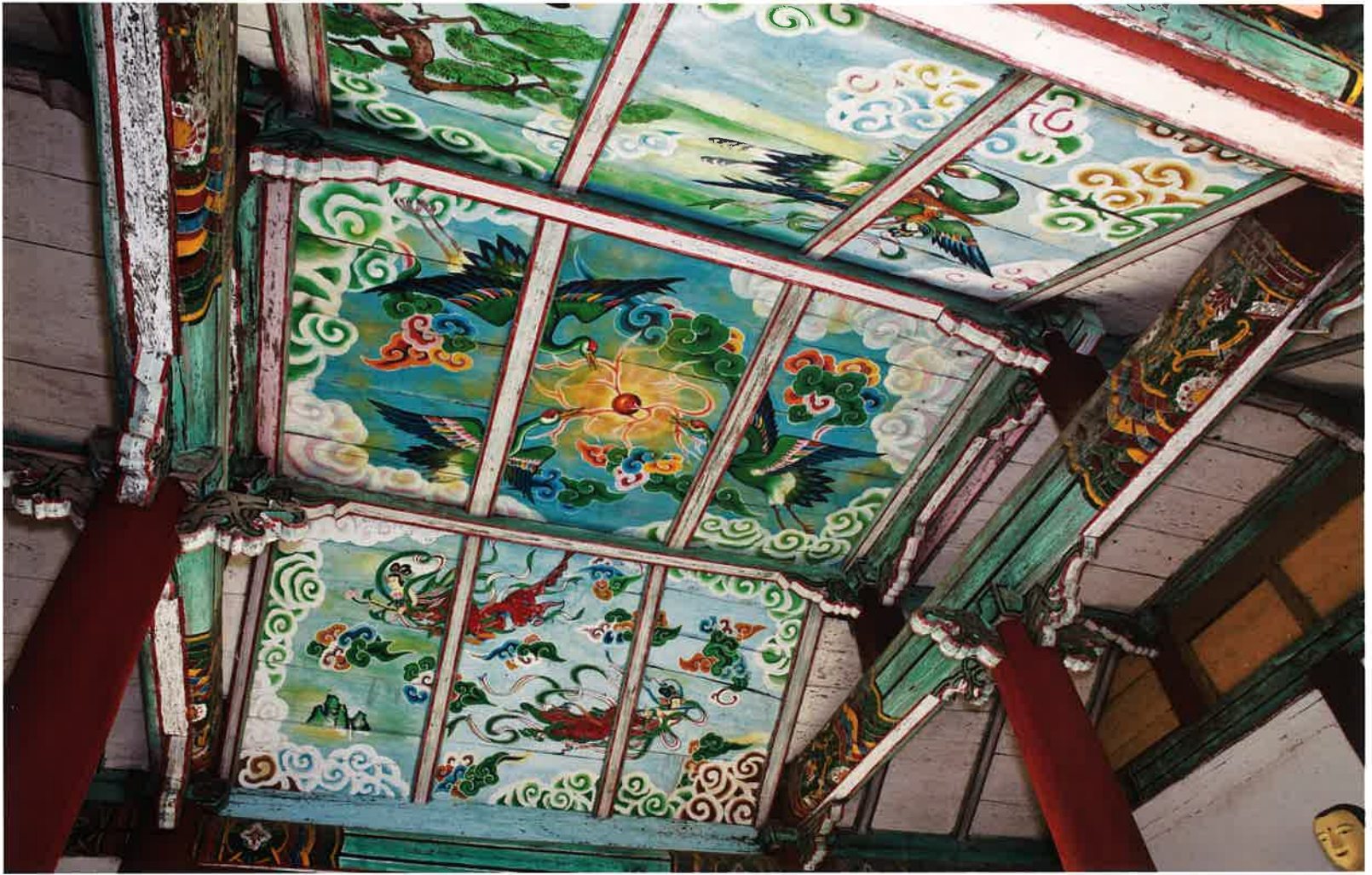
해탈문 내부 빗반자 / 解脫門 內部 斜天障 / inclined ceiling, Ha'almun gate
