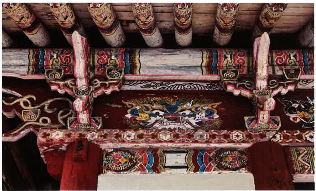
조계문 앞면 공포 / 曹溪門 前面 棋包 / front brackets, Chogyemun gate
