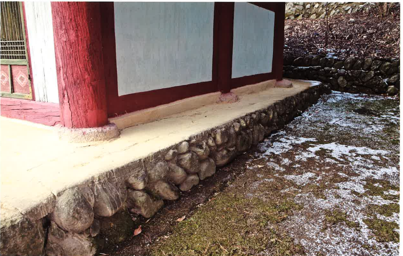
수충사 본전 동쪽 기단 / 酬忠祠 本殿 東側 基壇 / eastern stylobate, Such'ungsa
