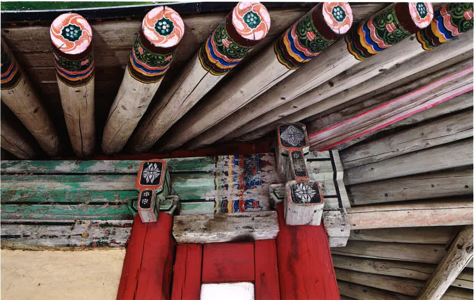
능인암 동쪽 측면 뒷면 공포 / 能仁庵 東側 後面 棋包 / backward brackets of eastern side, Nunginam
