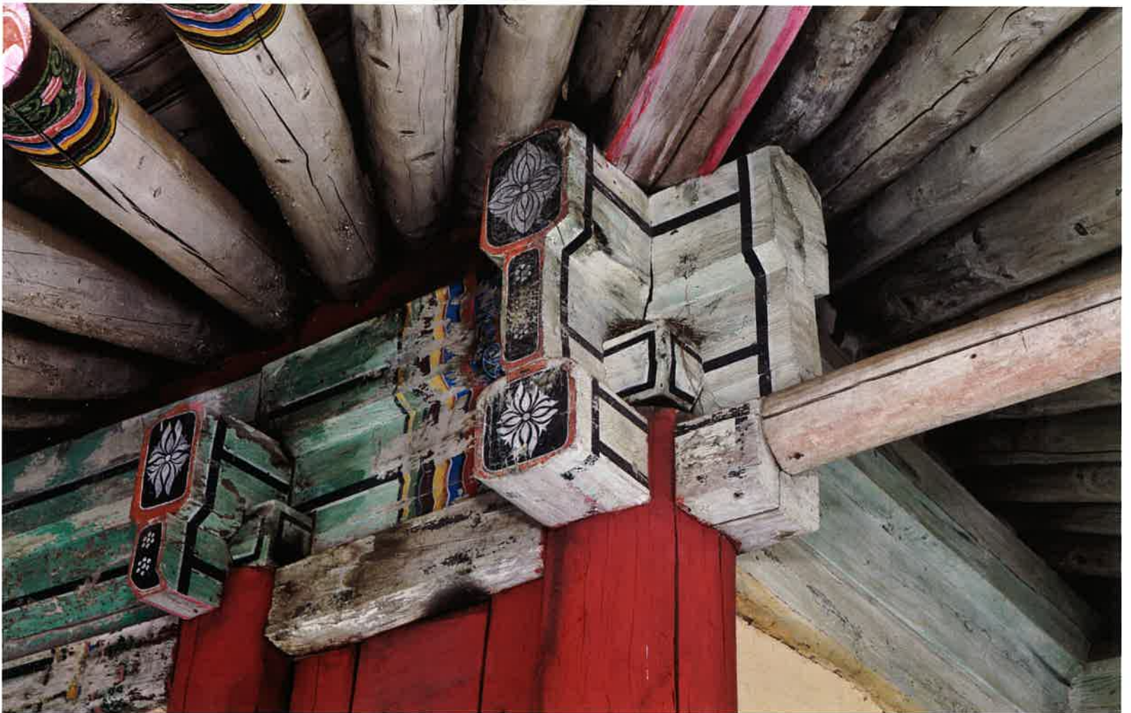
능인암 뒷면 귀포 / 能仁庵 後面 耳包 / backward corner brackets, Nünginam
