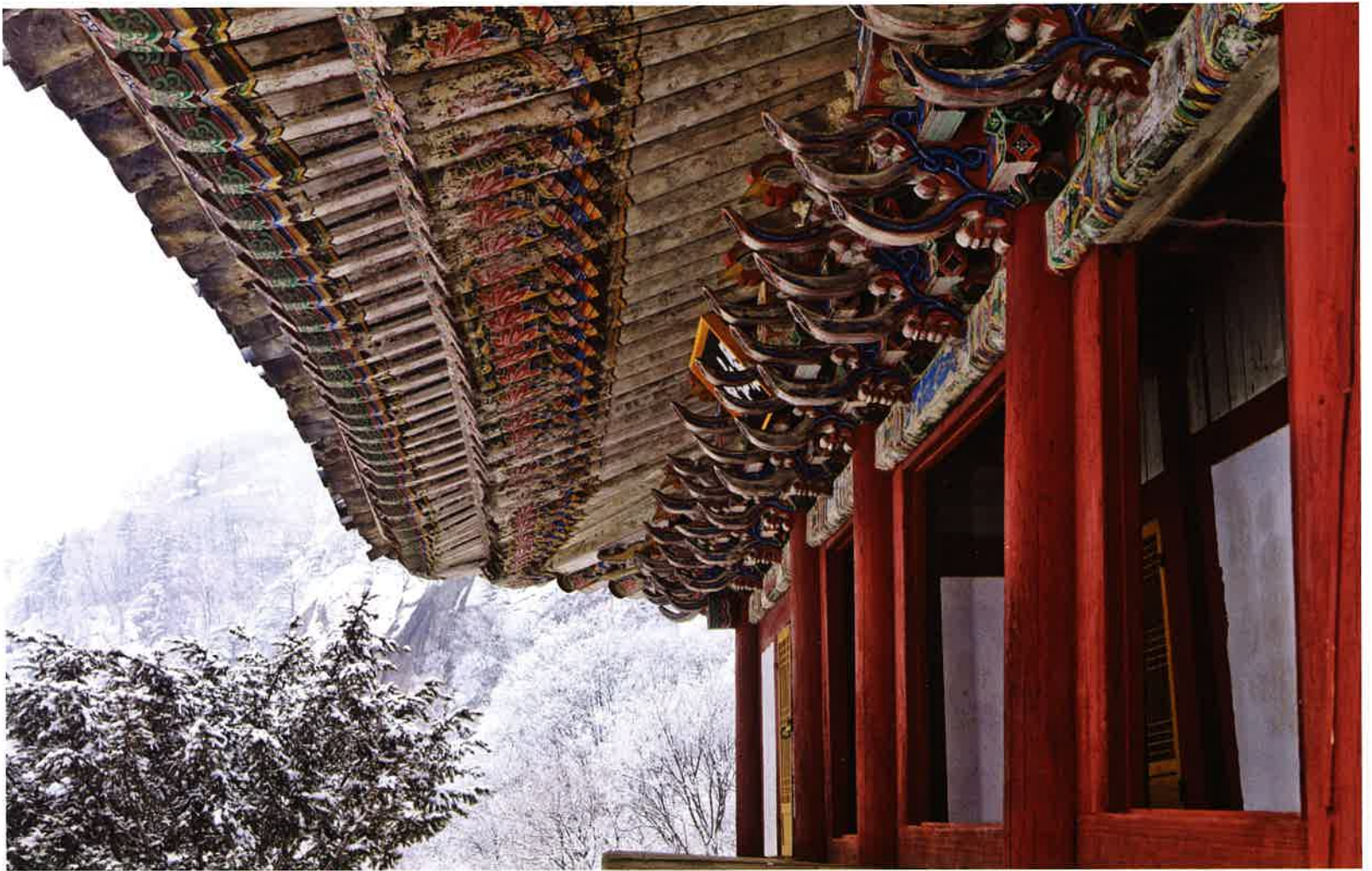
능인암 처마와 기둥 / 能仁庵 軒·平柱 / eaves and columns, Nunginam
