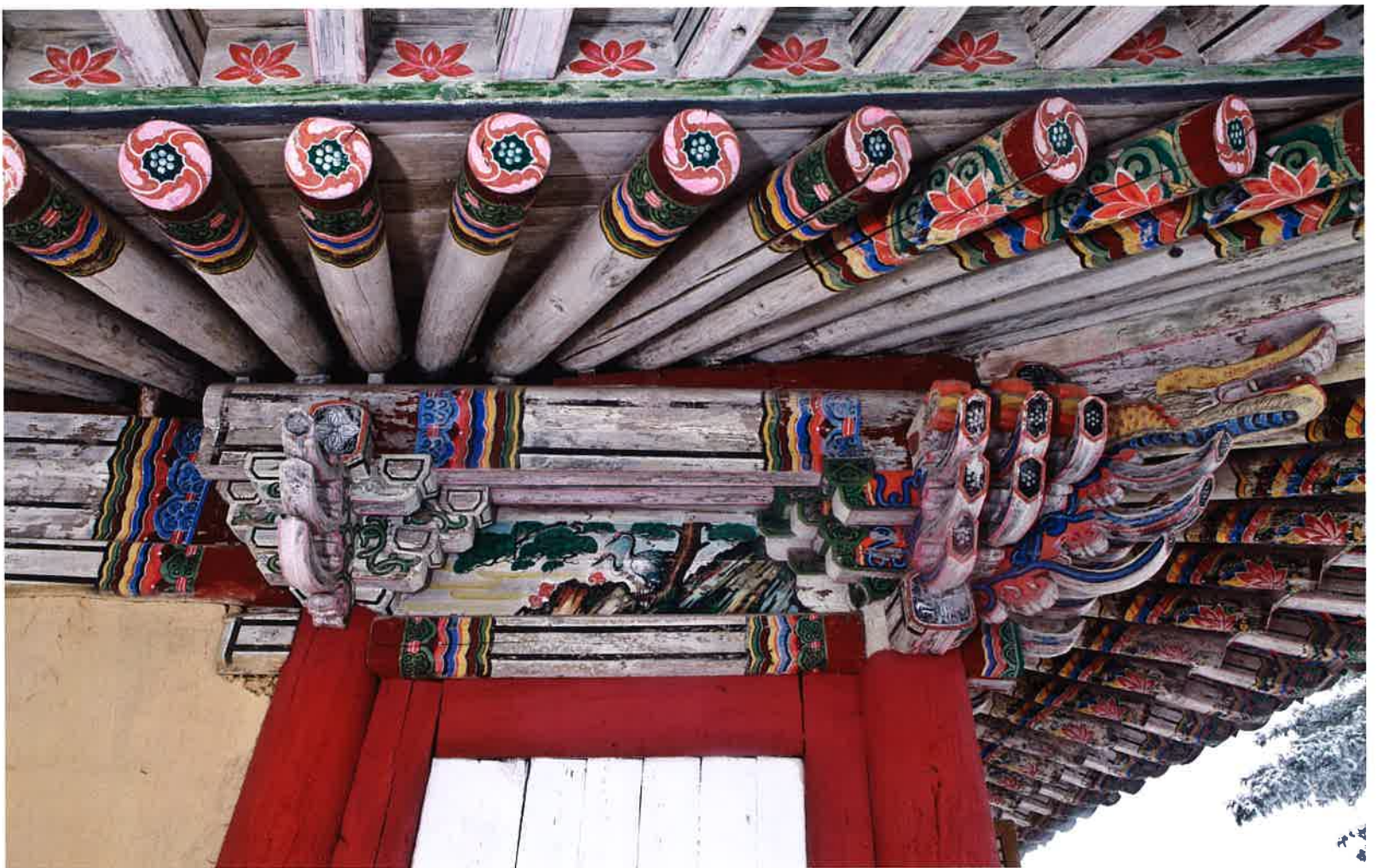
능인암 서쪽 측면 공포 / 能仁庵 西側 拱包 / western brackets, Nünginam
