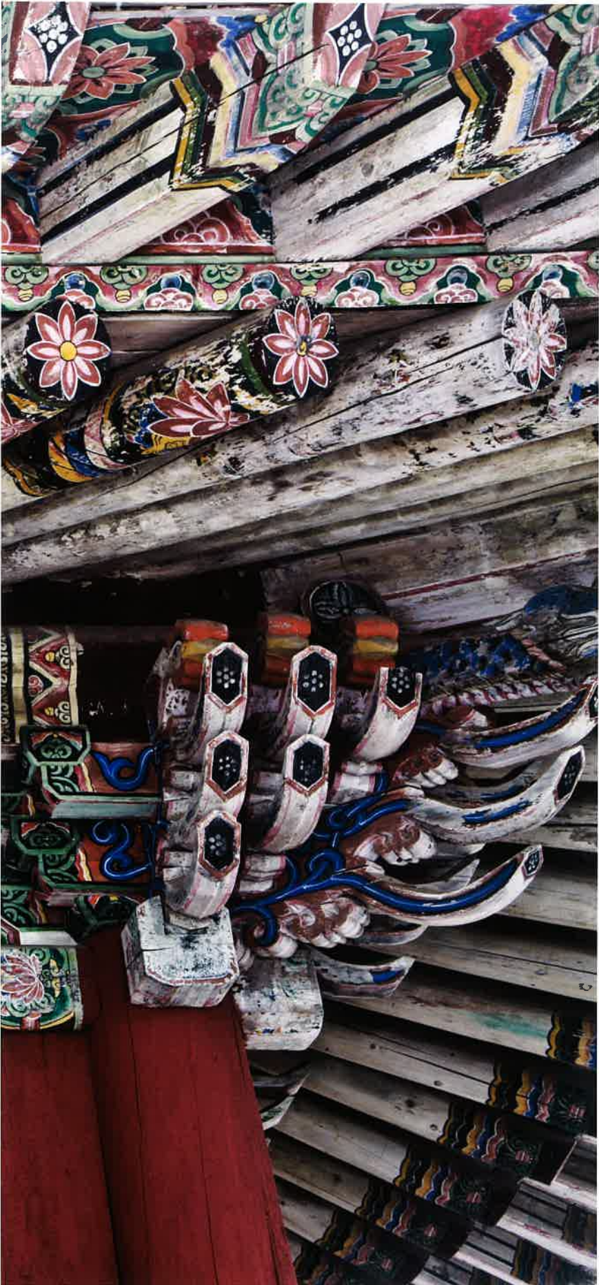
능인암 앞면 동쪽 공포 / 能仁庵 前面 東側 拱包 front eastern brackets, Nügingnam
