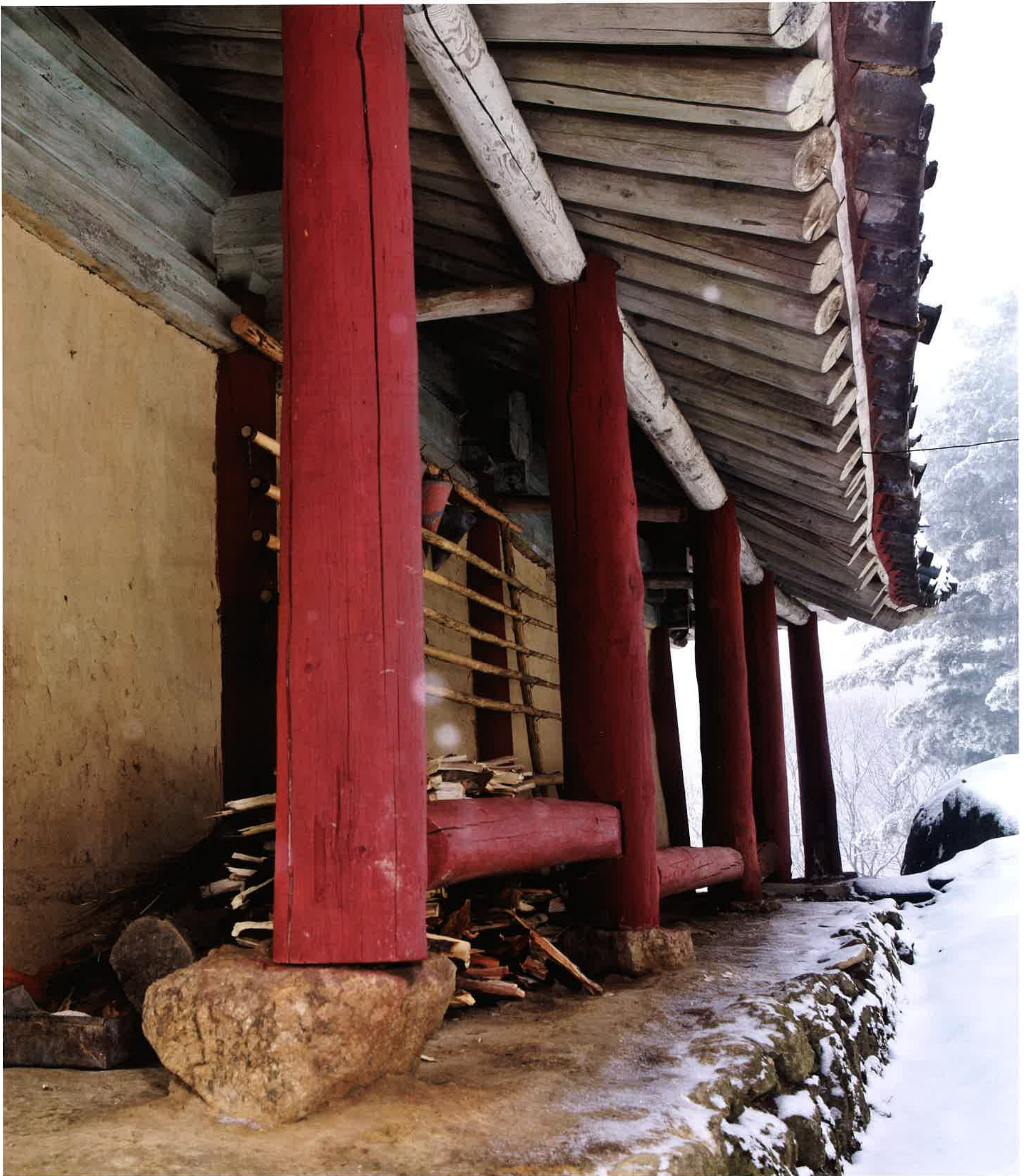
능인암 뒷면 처마와 기둥 / 能仁庵 後面 軒·平柱 / backward eaves and columns, Nünginam
