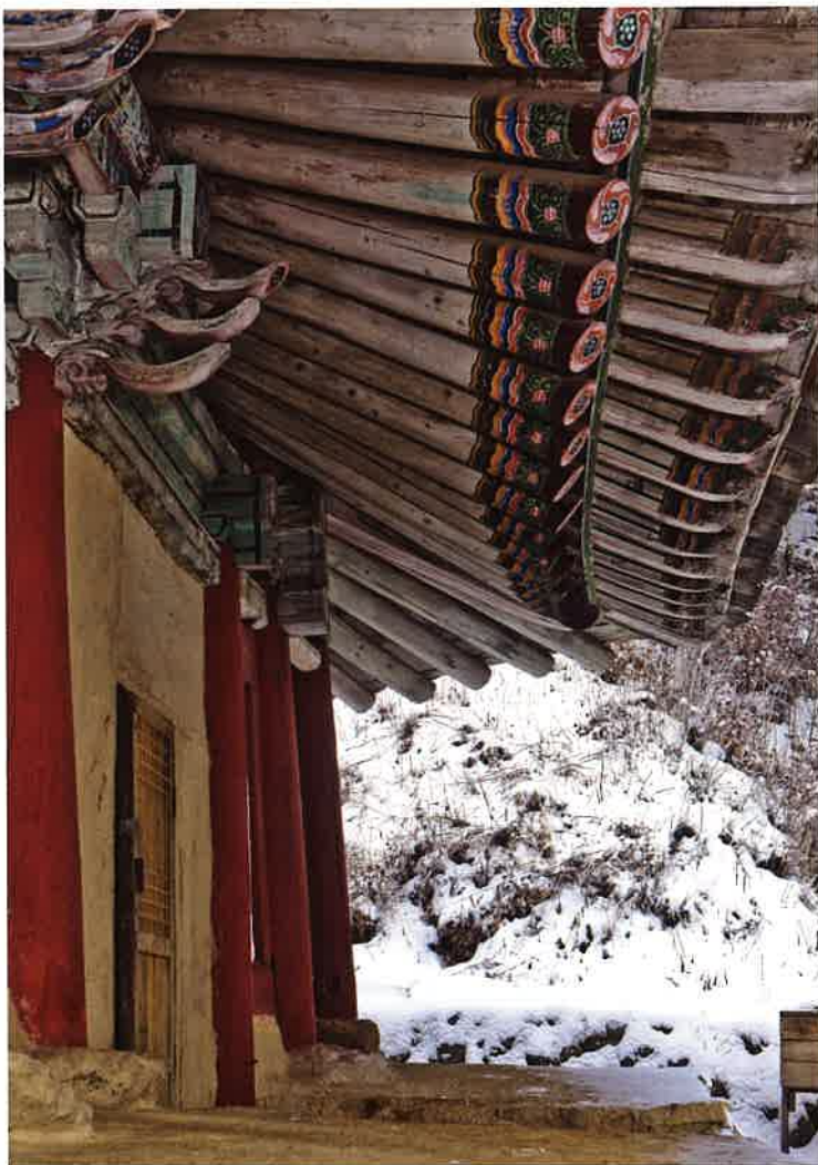
능인암 동쪽 측면 처마와 기둥 / 能仁庵 東側 軒·平柱 eastern eaves and columns, Nunginam
