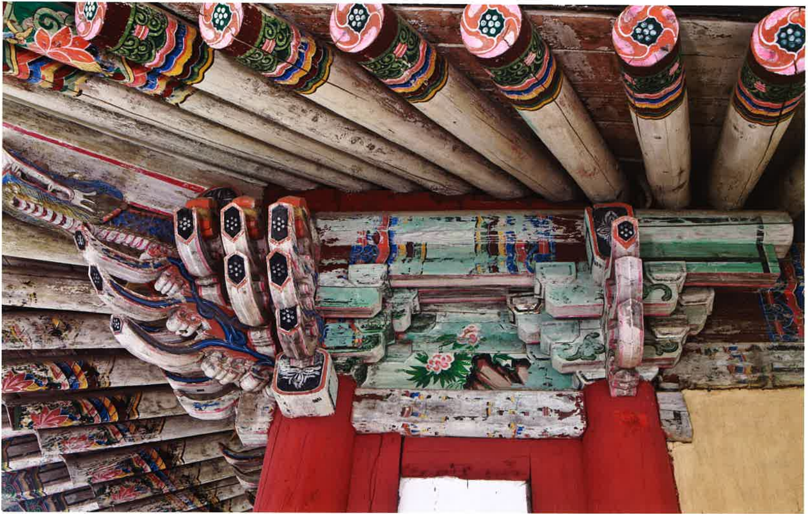
능인암 동쪽 측면 앞면 공포 / 能仁庵 東側 前面 棋包 / front brackets of eastern side, Nunginam
