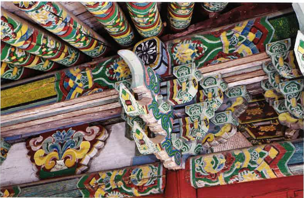
불영암 서쪽 측면 주상포 2 / 佛影庵 西側 柱上包 2 / brackets 2 above western columns, Puryongam
