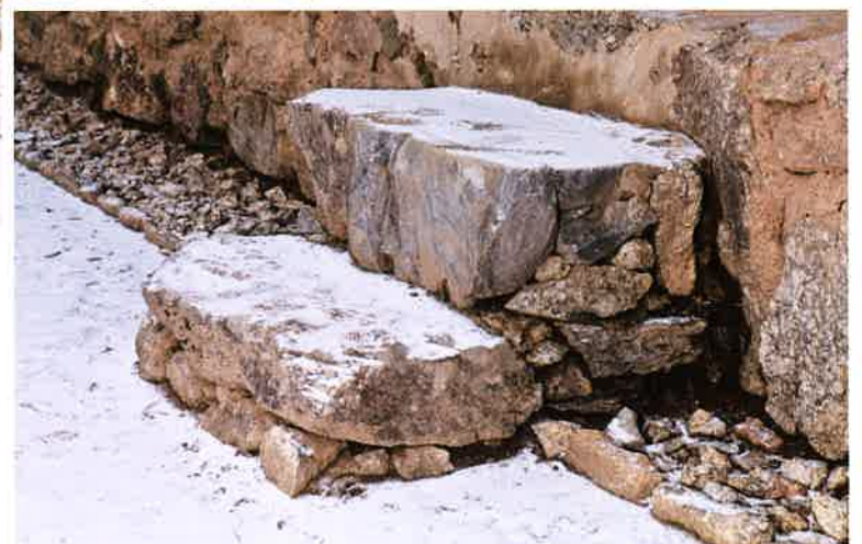
불영암 앞 계단 / 佛影庵 前面 階段 / front stairs, Puryongam
