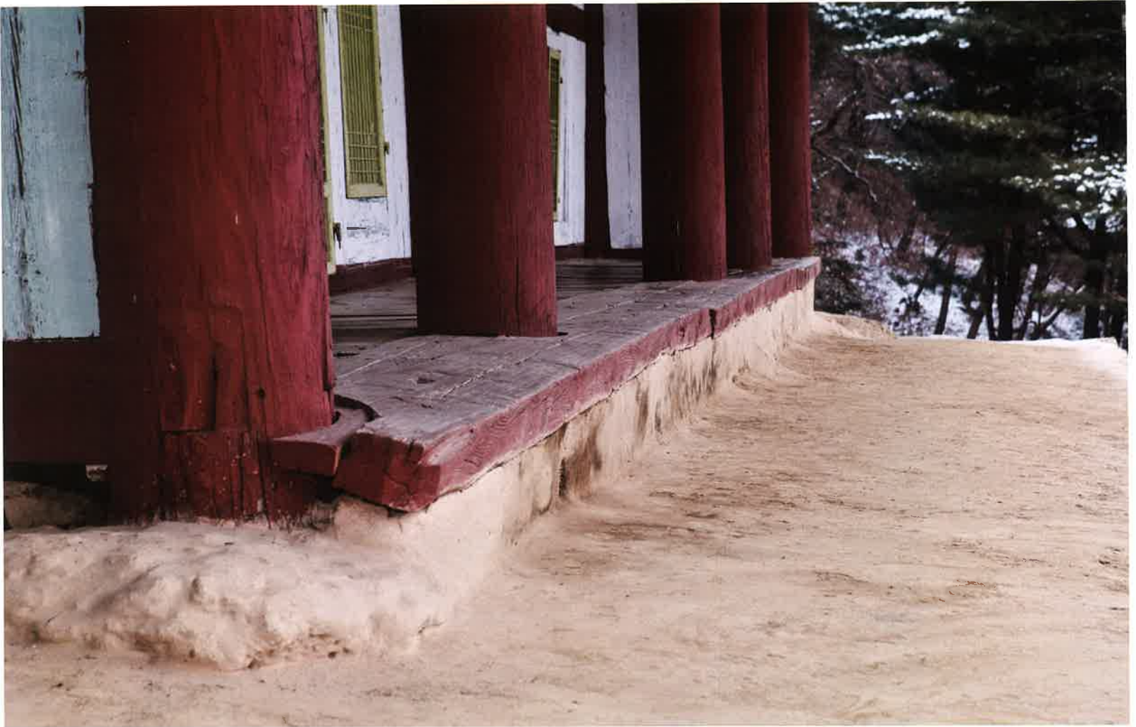
불영암 앞 마루 / 佛影庵 前面 抹樓 / front floor, Puryongam
