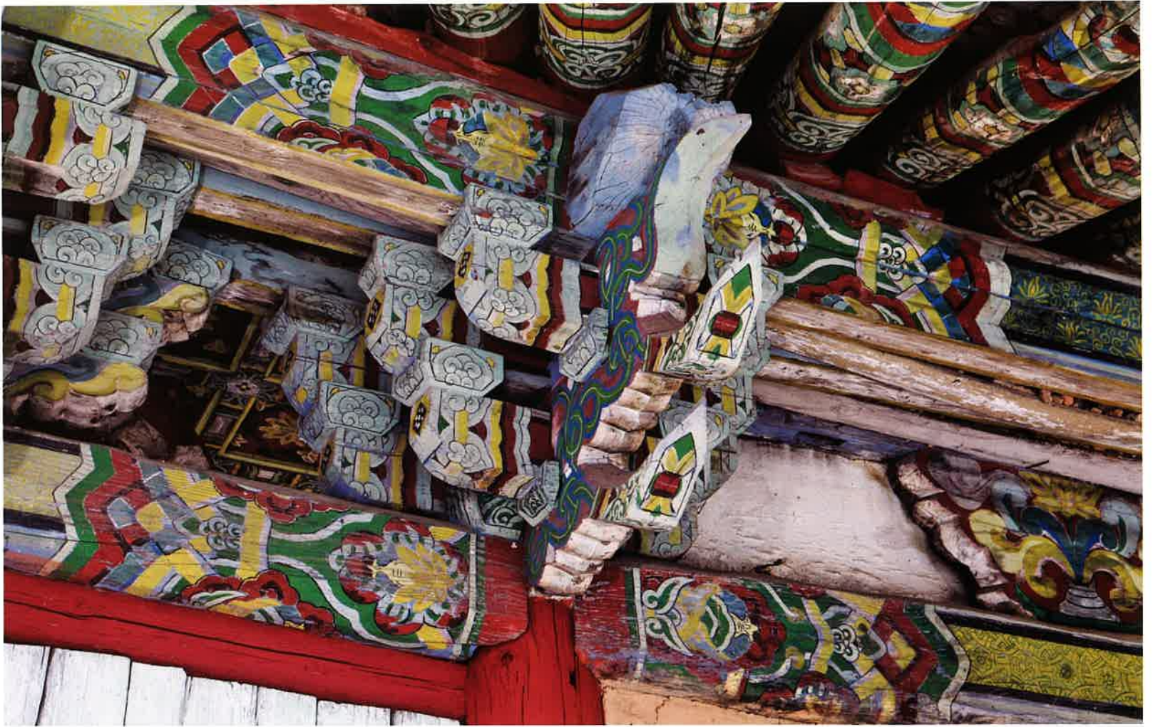
불영암 동쪽 측면 앞면 공포 / 佛影庵 東側 前面 拱包 / eastern front brackets, Puryongam
