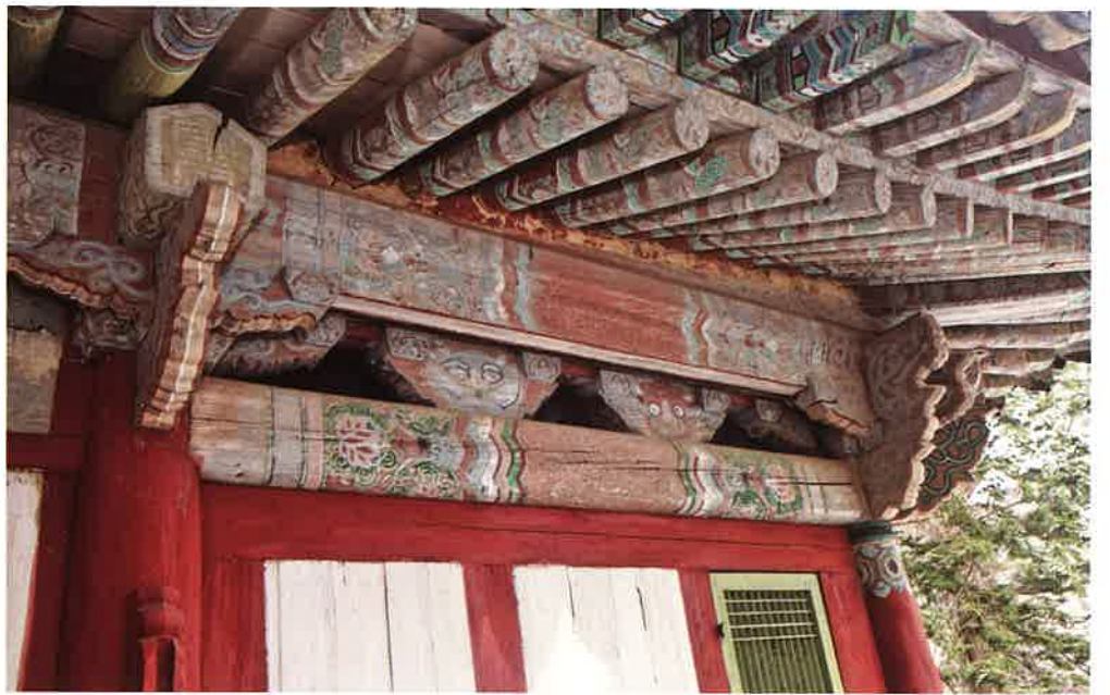
축성전 서쪽 날개채 남쪽 측면 액방과 도리, 장혀 / 祝聖殿 西側 翼舍 南側面 額枋·道里·長舌 southern lintel and girder, strip of wood of western wing building, Ch'uksongjŏn hall
