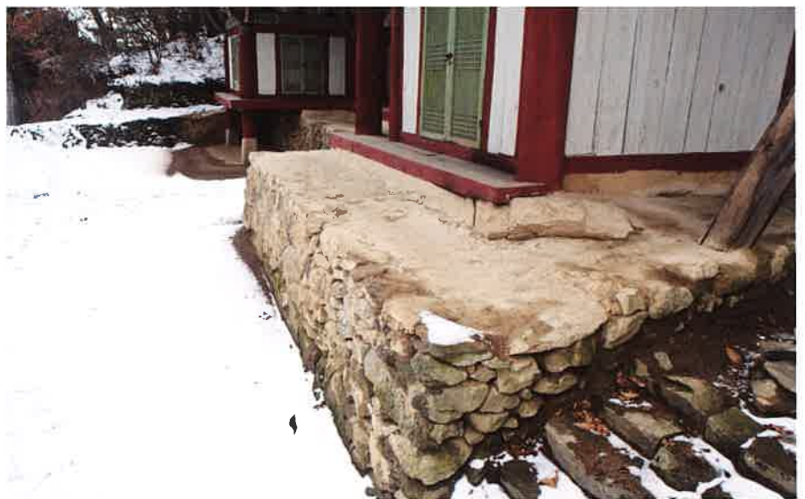
축성전 동쪽 날개채 남쪽 측면 기단 / 祝聖殿 東側 翼舍 南側 基壇 southern stylobate of eastern wing building, Ch'uksongjŏn hall
