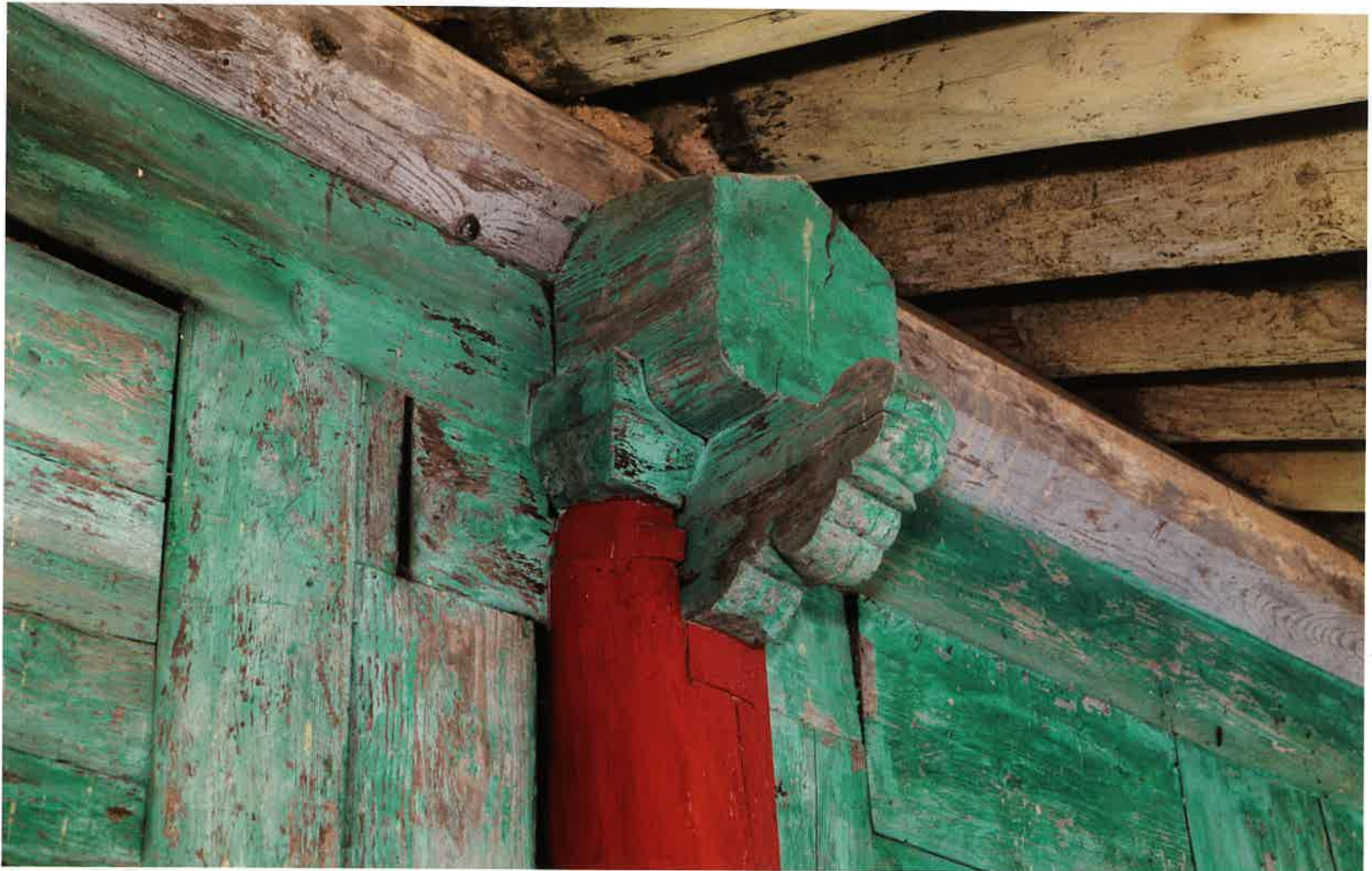
축성전 뒷면 주상포 / 祝聖殿 後面 柱上包 / brackets above backward columns, Ch'uksongjŏn hall
