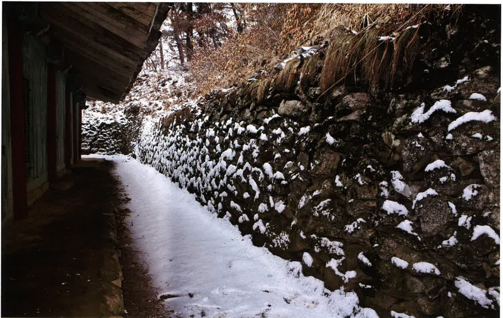
축성전 뒷면 기단과 축대 / 祝聖殿 後面 基壇·築臺 / backward stylobate and embankment, Ch'uksongjŏn hall
