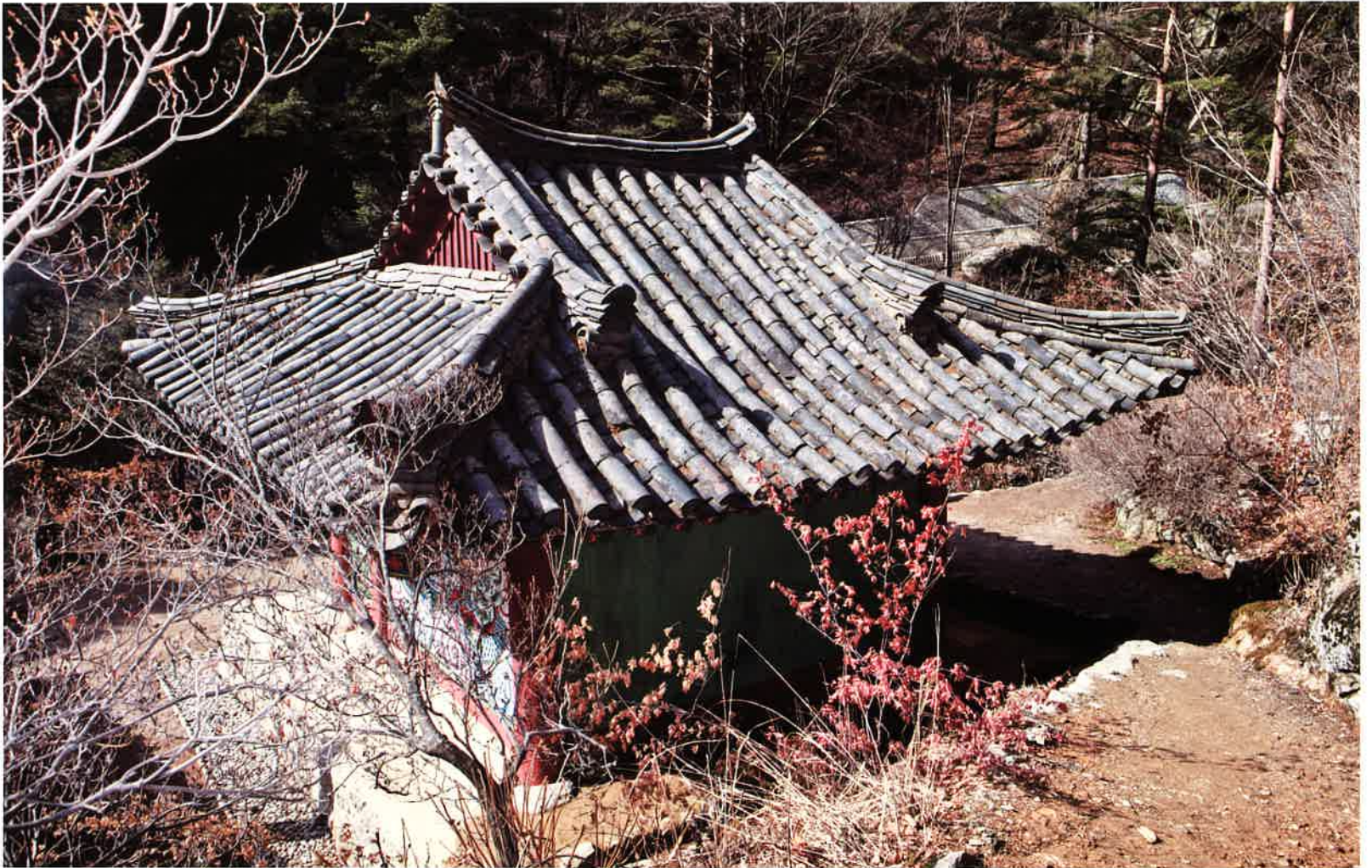
보련대 뒷면 지붕 / 寶蓮臺 後面 屋蓋 / backward roof, Poryondae
