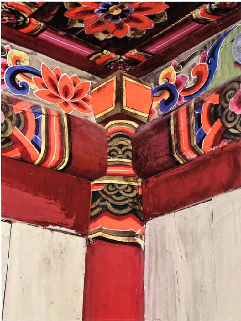
보련대 내부 동쪽 측면 귀포 1 / 寶蓮臺 內部 東側 耳包 1 corner brackets 1 of eastern side, Poryondae
