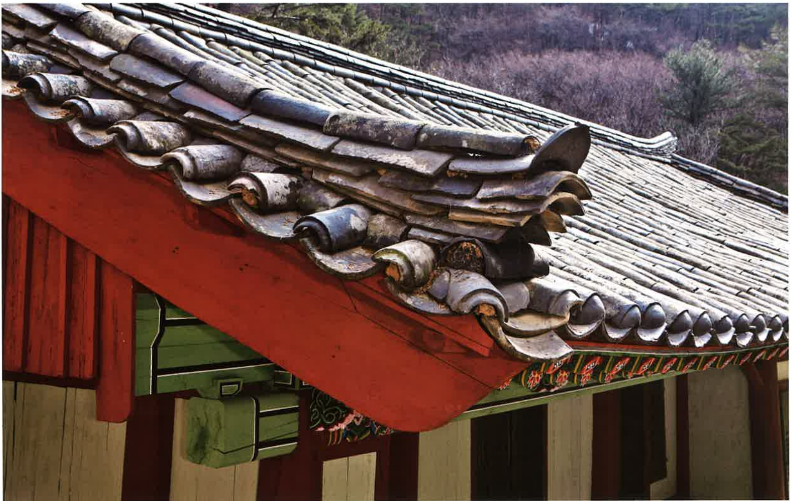
하비로암 본전 서쪽 지붕 / 下毘盧庵 本殿 西側 屋蓋 / western roof of main hall, Habiroam
