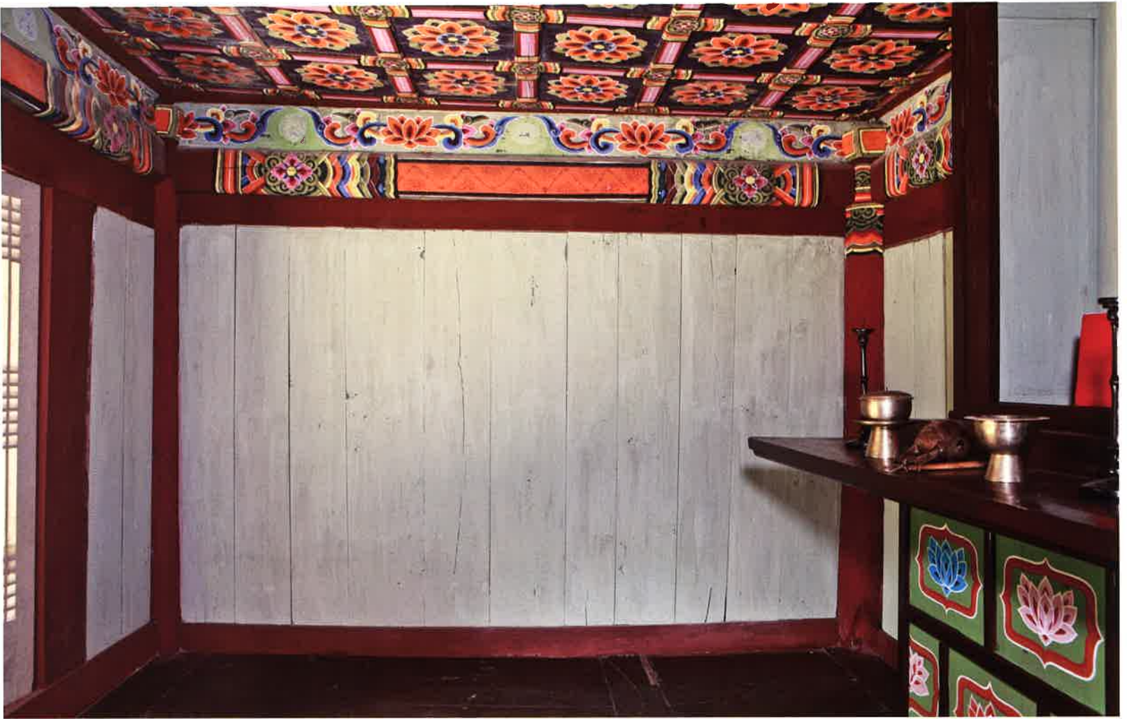
보려대 내부 서쪽 벽체 / 寶蓮臺 內部 西側 壁體 / western wall, Poryŏndae
