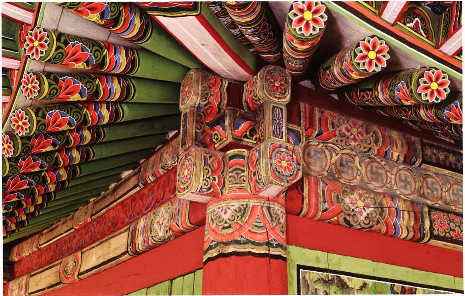
보련대 뒷면 서쪽 귀포 / 寶蓮臺 後面 西側 耳包 / corner brackets of backward side, Poryondae
