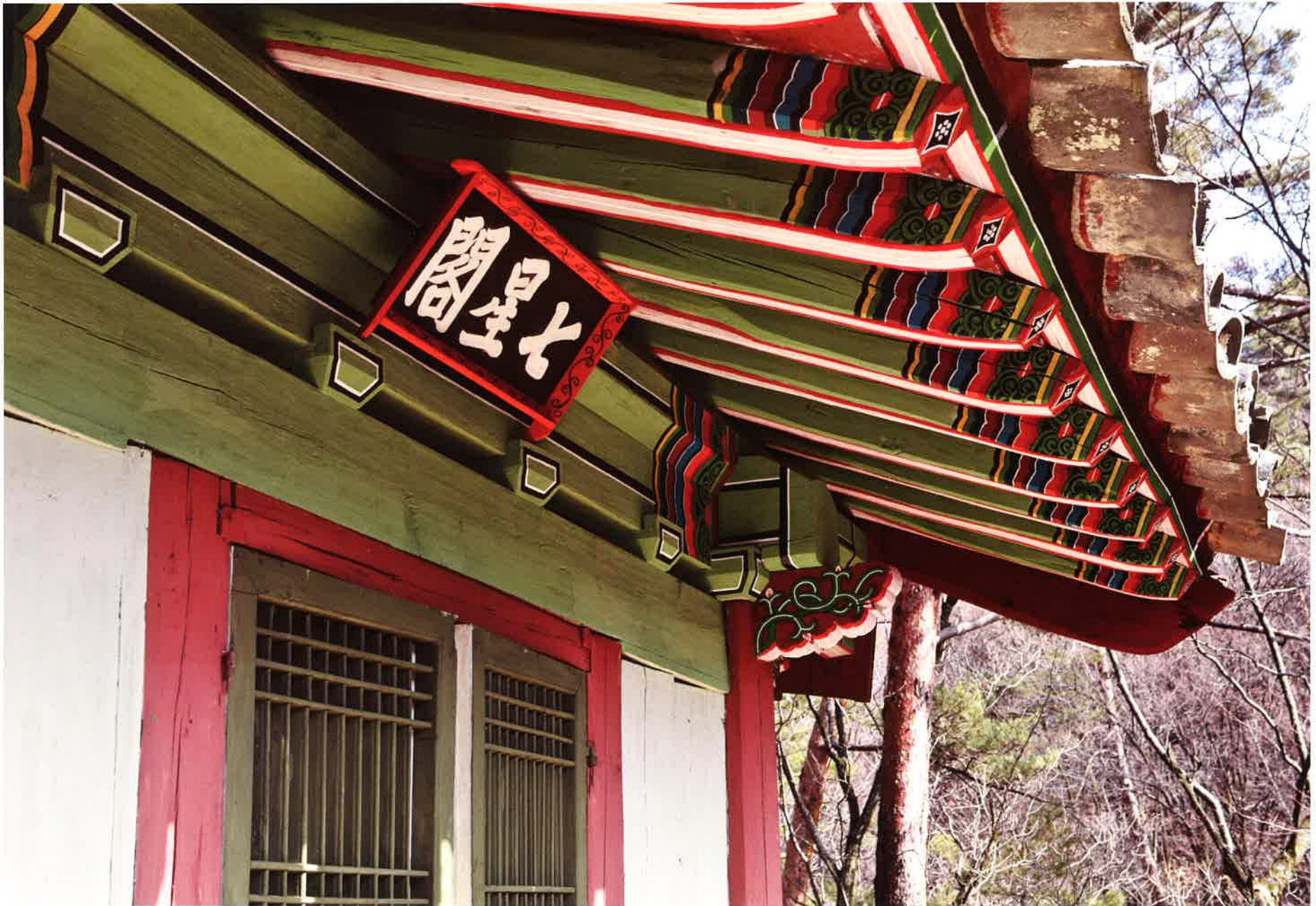
칠성각 처마 / 七星閣 軒 / eaves, Ch'ilsyöngak shrine
