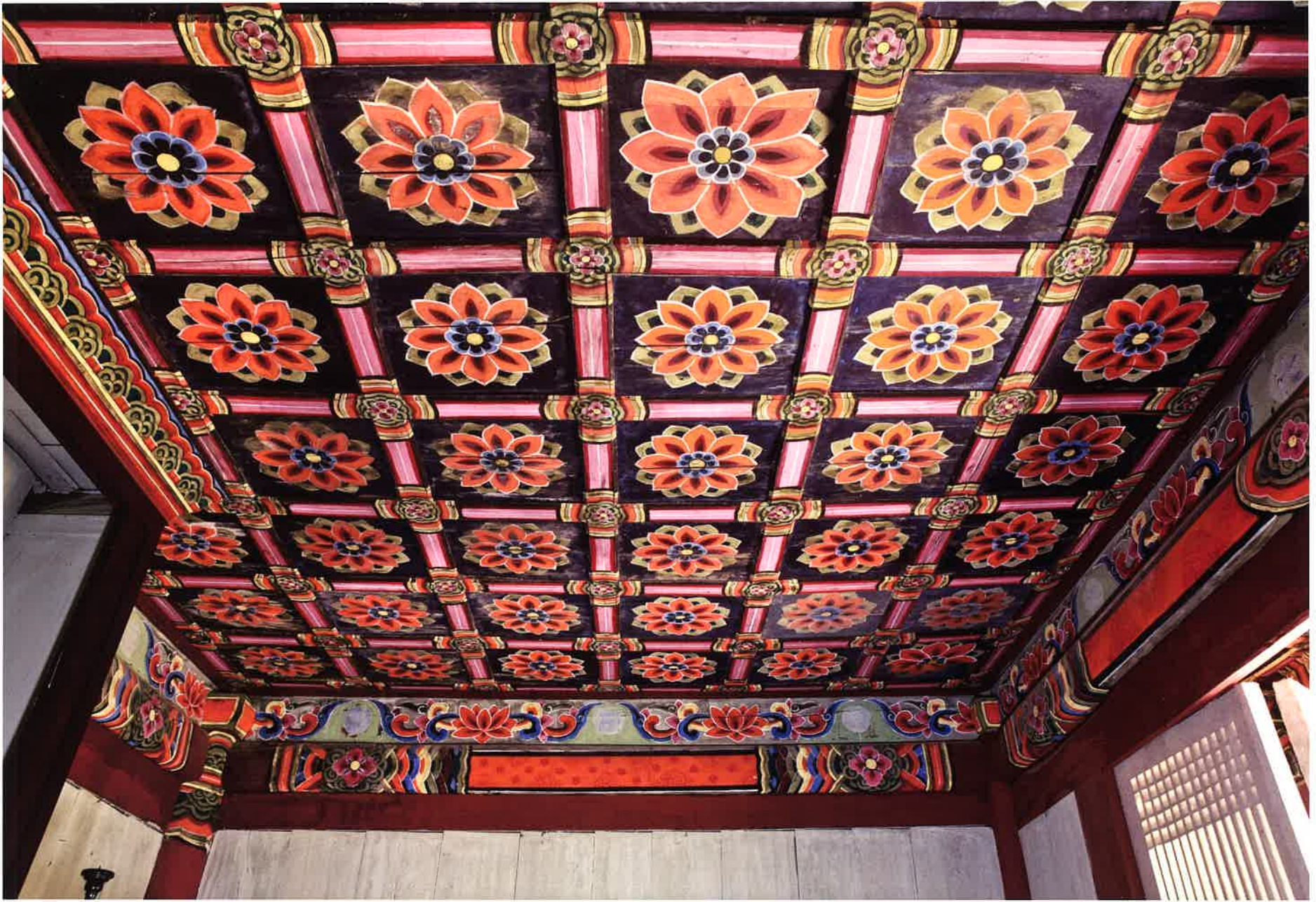
보려대 내부 반자 / 寶蓮臺 內部 天障 / ceiling, Poryöndaec
