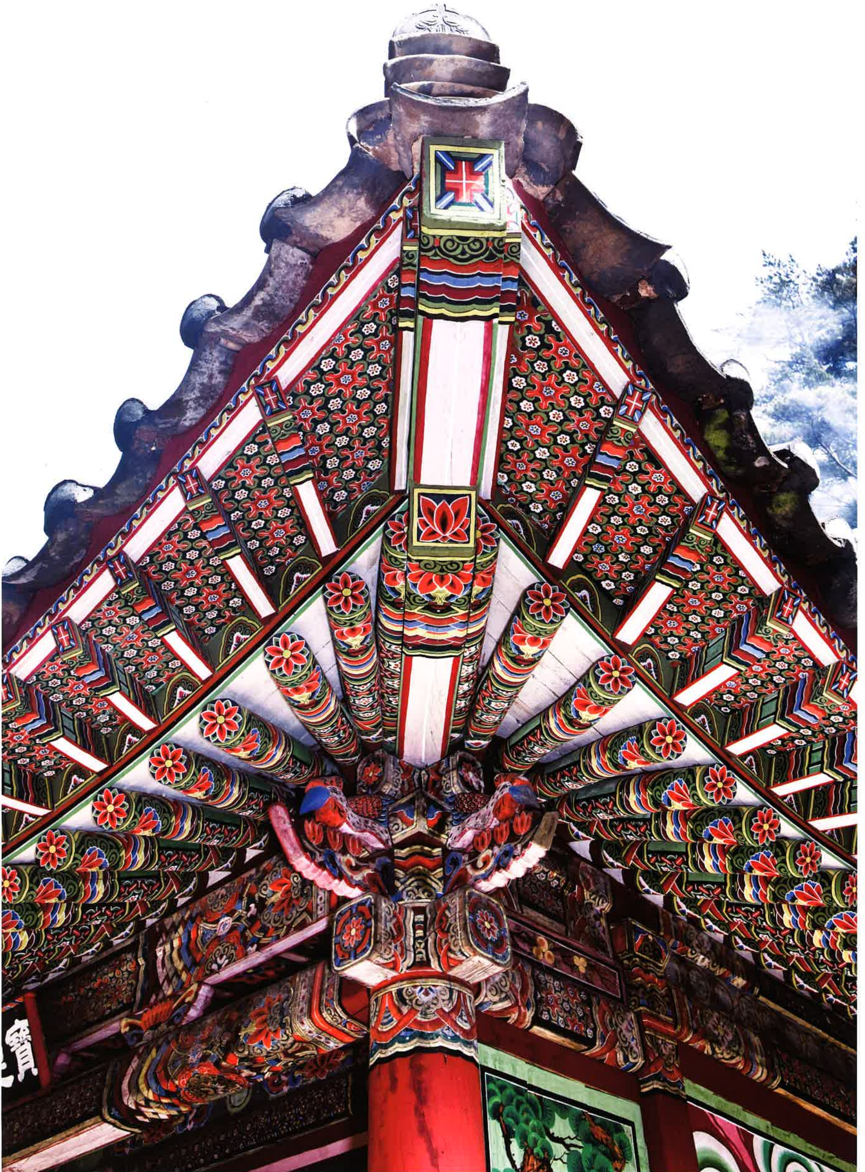
보련대 추녀 / 寶蓮臺 春舌 / protruding corners of eaves, Poryöndaec
