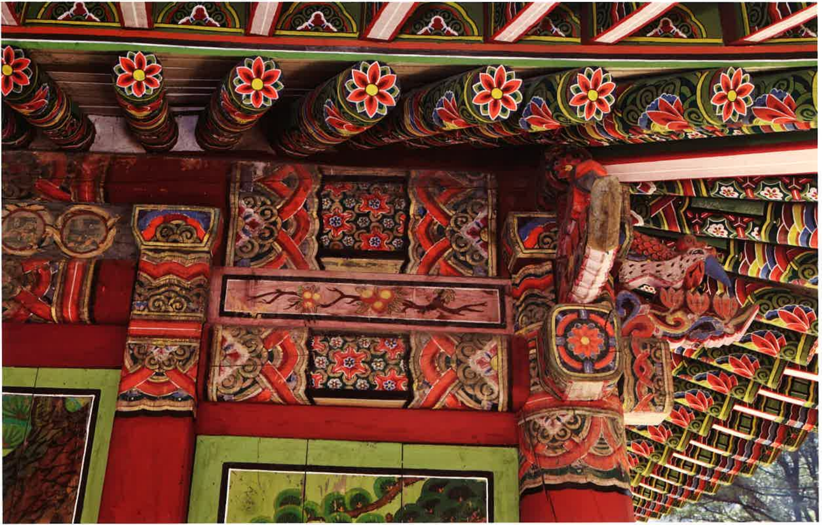
보련대 서쪽 앞면 귀포 / 寶蓮臺 西側 前面 耳包 / corner brackets of western side, Poryondae
