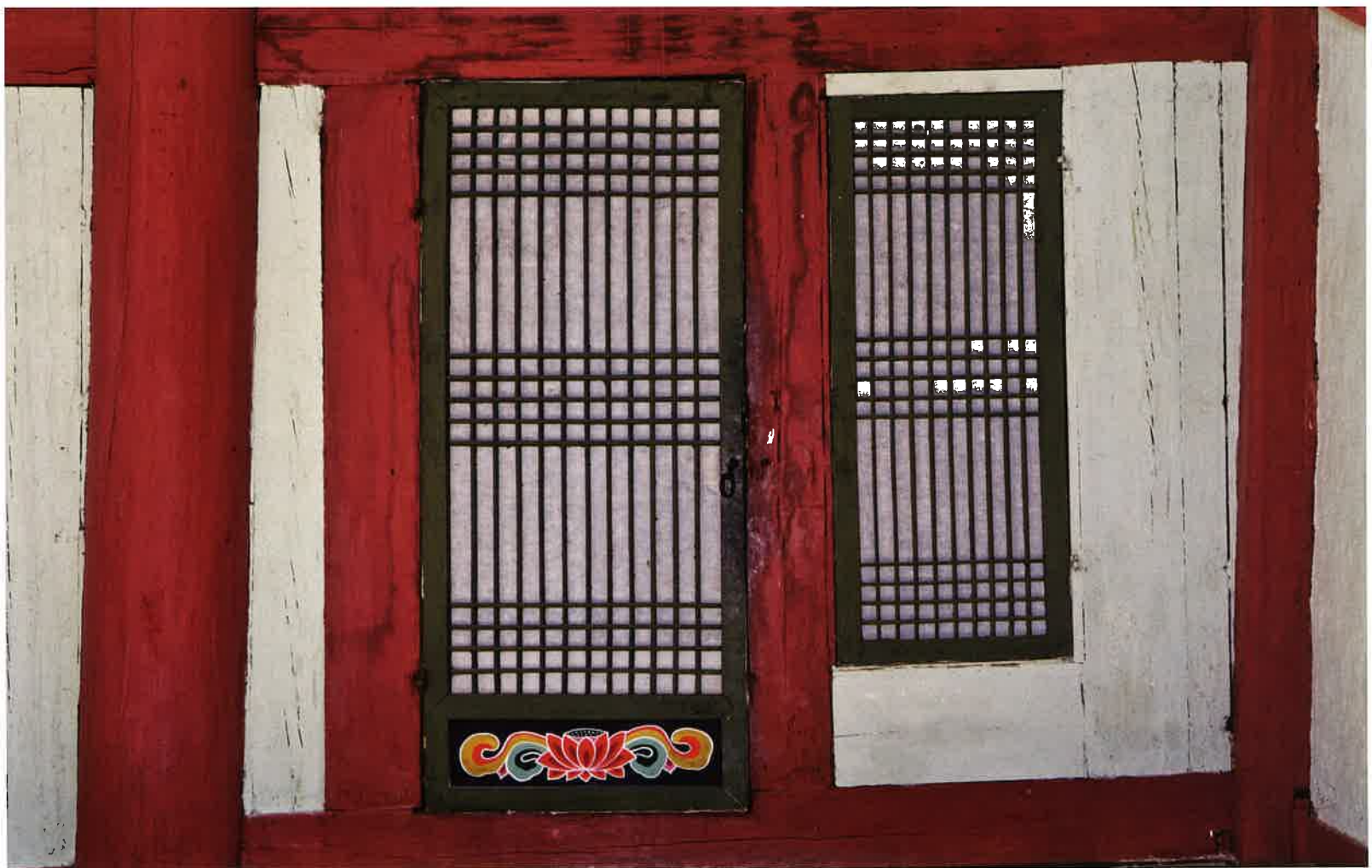
하비로암 본전 앞면 동쪽 협간 창호 / 下毘盧庵 本殿 前面 東側 夾間 窓戶 / eastern window and door of main hall, Habiroam
