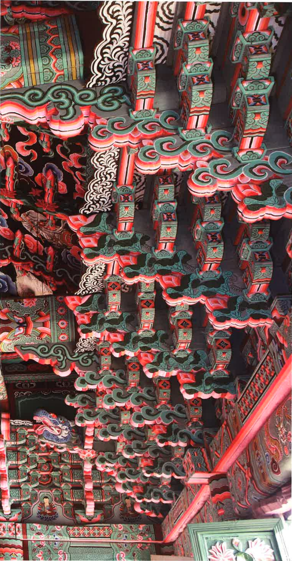
극락전 담집과 반자 / 極樂殿 唐家·天障 / canopy and ceiling, Kungnakchön hall
