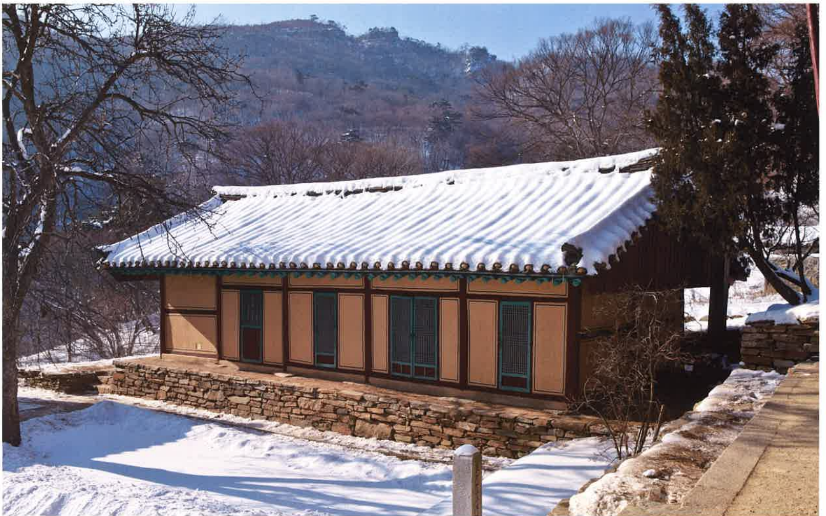
심검당 전경 / 尋劍堂 全景 / whole view, Simgömdang hall
