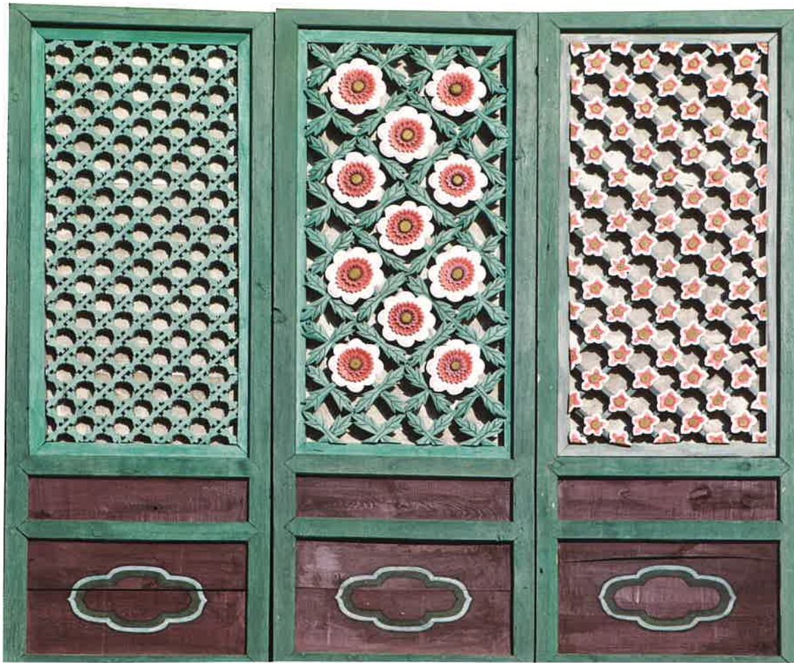
극락전 앞면 서쪽 협간 창호 / 極樂殿 前面 西側 夾間 窓戶 / front western doors, Kūngnakchŏn hall
