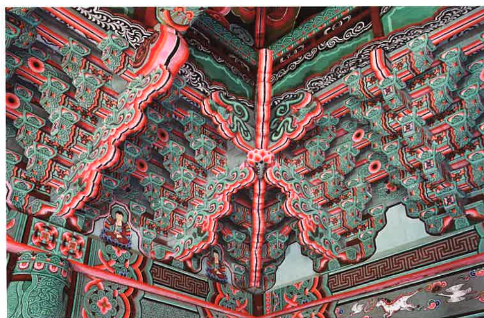
극락전 내부 서쪽 귀포 / 極樂殿 內部 西側 耳包 western corner brackets, Kungnakchön hall
