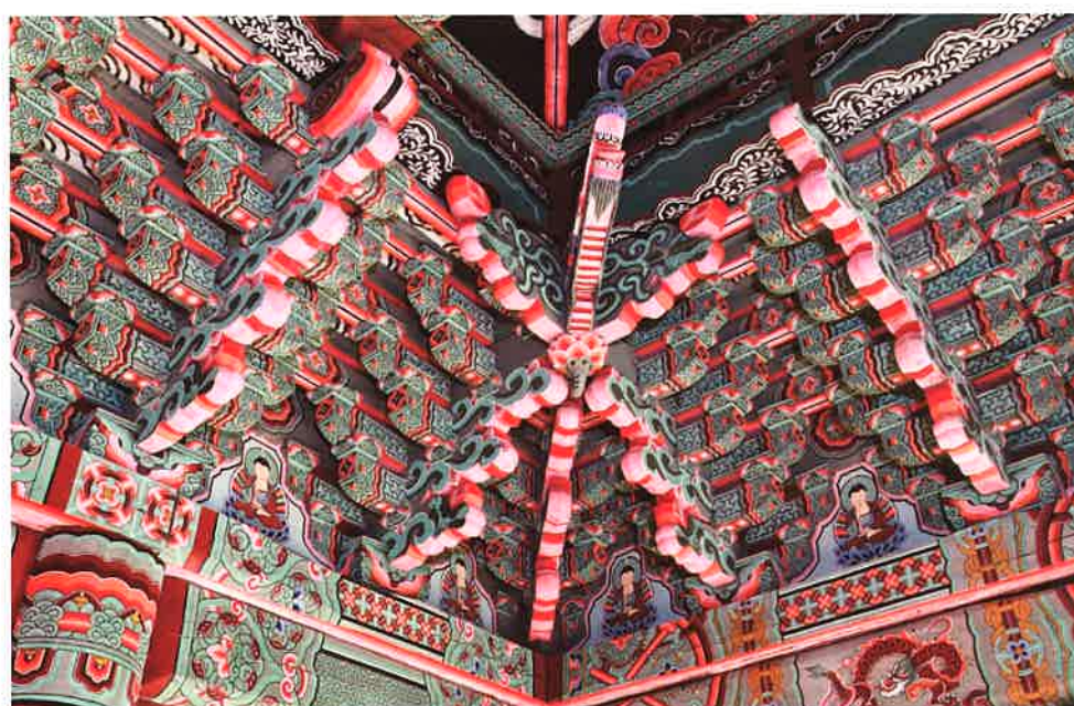
극락전 내부 앞면 서쪽 귀포 / 極樂殿 內部 前面 西側 耳包 front western corner brackets, Kungnakchön hall
