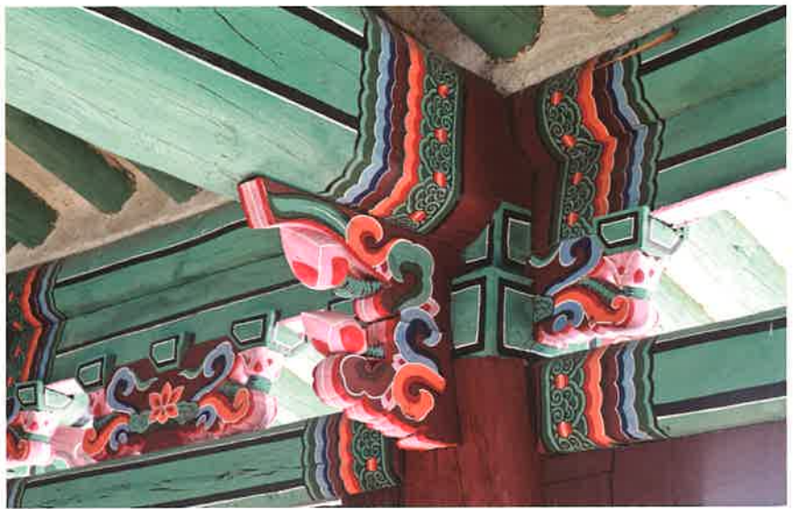
주악루 내부 공포 / 奏樂樓 內部 栱包 / brackets, Chuangnu
