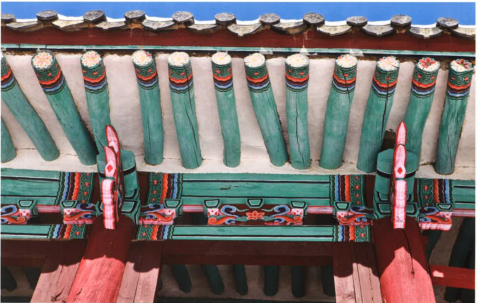
주악루 앞면 서까래 / 奏樂樓 前面 屋椽 / front rafters, Chuangnu
