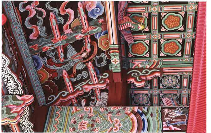
극락전 내부 빗반자 / 極樂殿 內部 斜天障 / inclined ceiling, Kungnakchön hall
