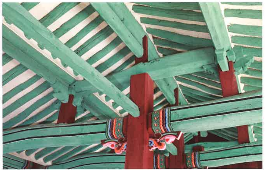
주악루 내부 대들보 / 奏樂樓 內部 大樑 / main beam, Chuangnu
