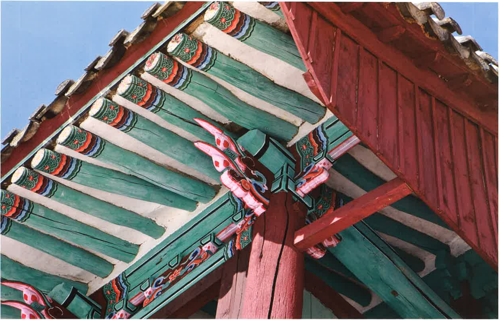
주악루 앞면 서쪽 측면 귀포 / 奏樂樓 前面 西側 耳包 / front western corner brackets, Chuangnu
