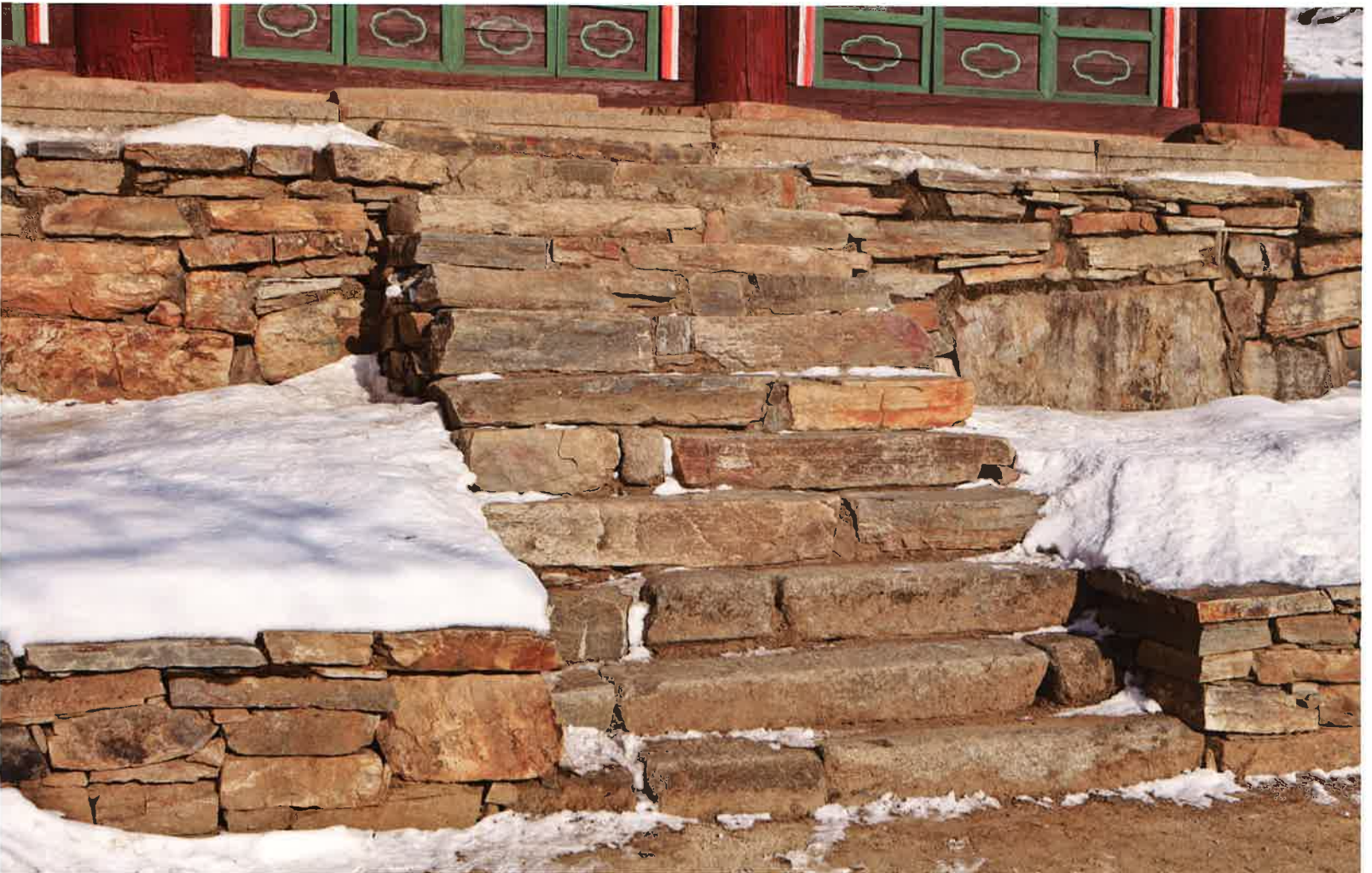
극락전 앞 계단 / 極樂殿 前面 階梯 / front stairs, Kungnakchön hall
