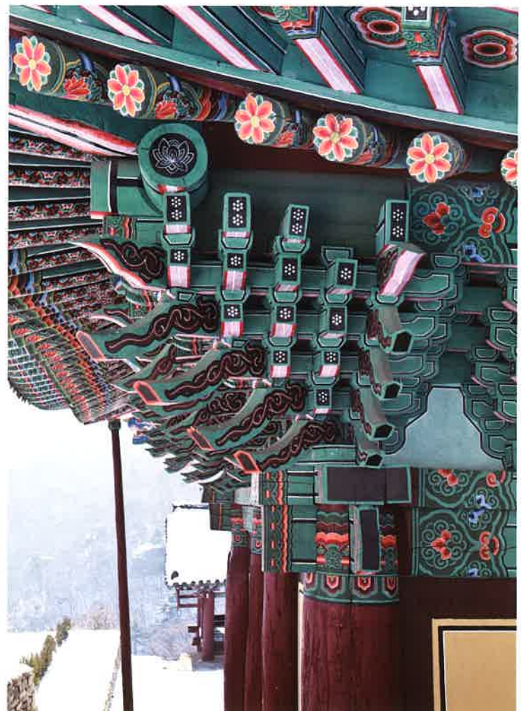
극락전 뒷면 동쪽 귀포 2 / 極樂殿 後面 東側 耳包 2 backward eastern corner brackets 2, Kūngnakchön hall
