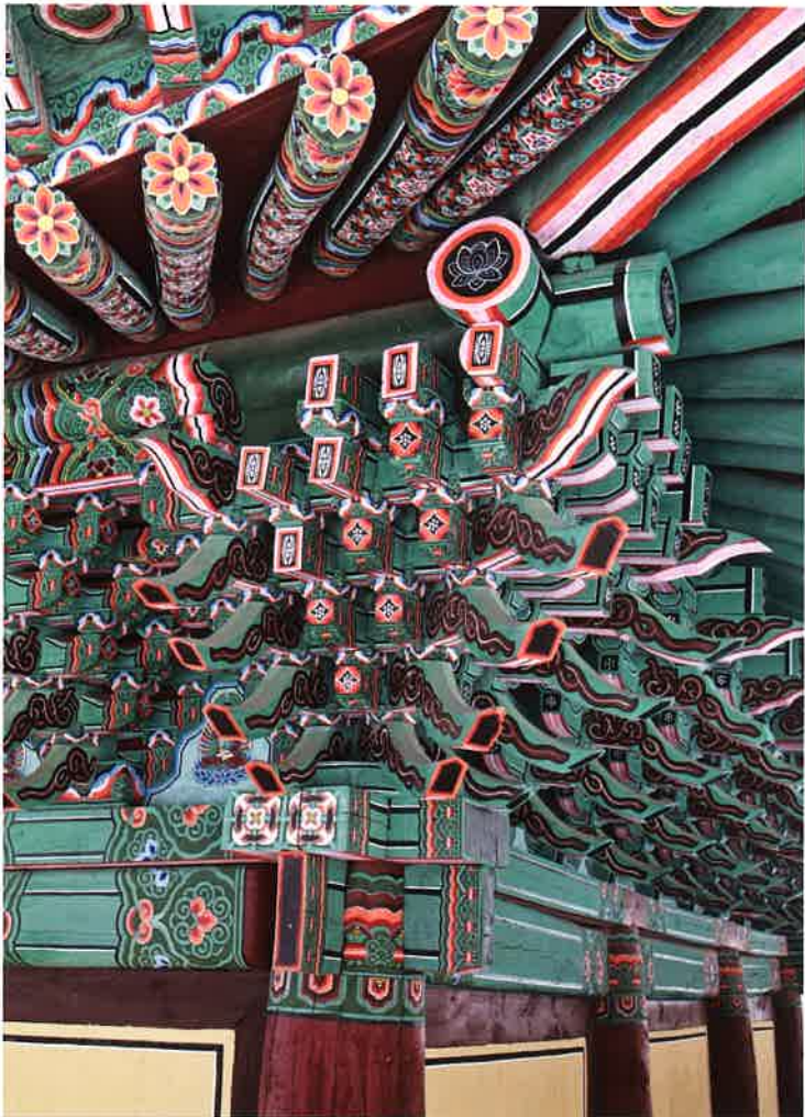
극락전 뒷면 동쪽 귀포 1 / 極樂殿 後面 東側 耳包 1 backward eastern corner brackets 1, Kūngnakchön hall
