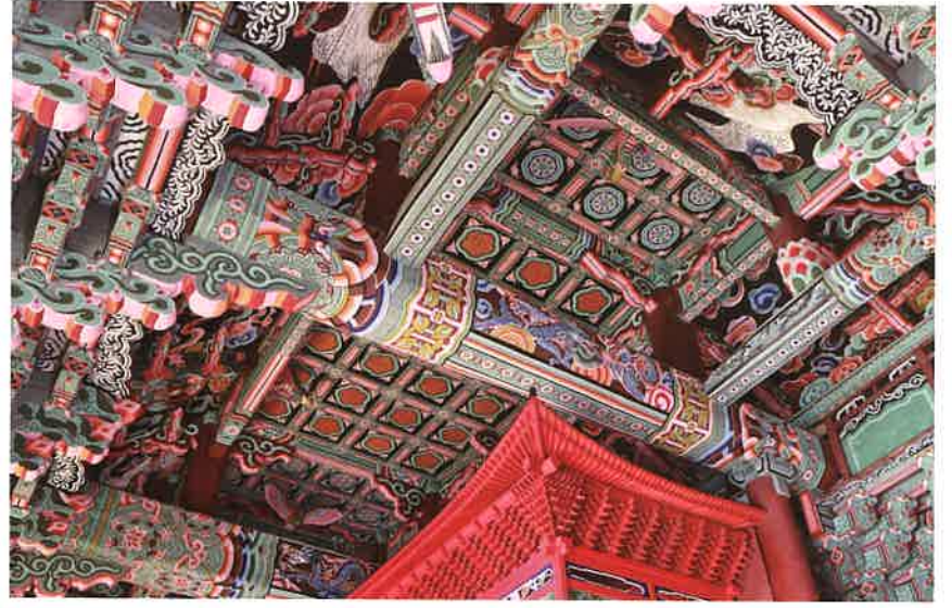
극락전 내부 반자 / 極樂殿 內部 天障 / ceiling, Kungnakchön hall
