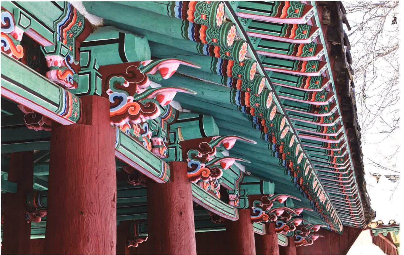
주악루 앞면 공포 / 奏樂樓 前面 棋包 / front brackets, Chuangnu
