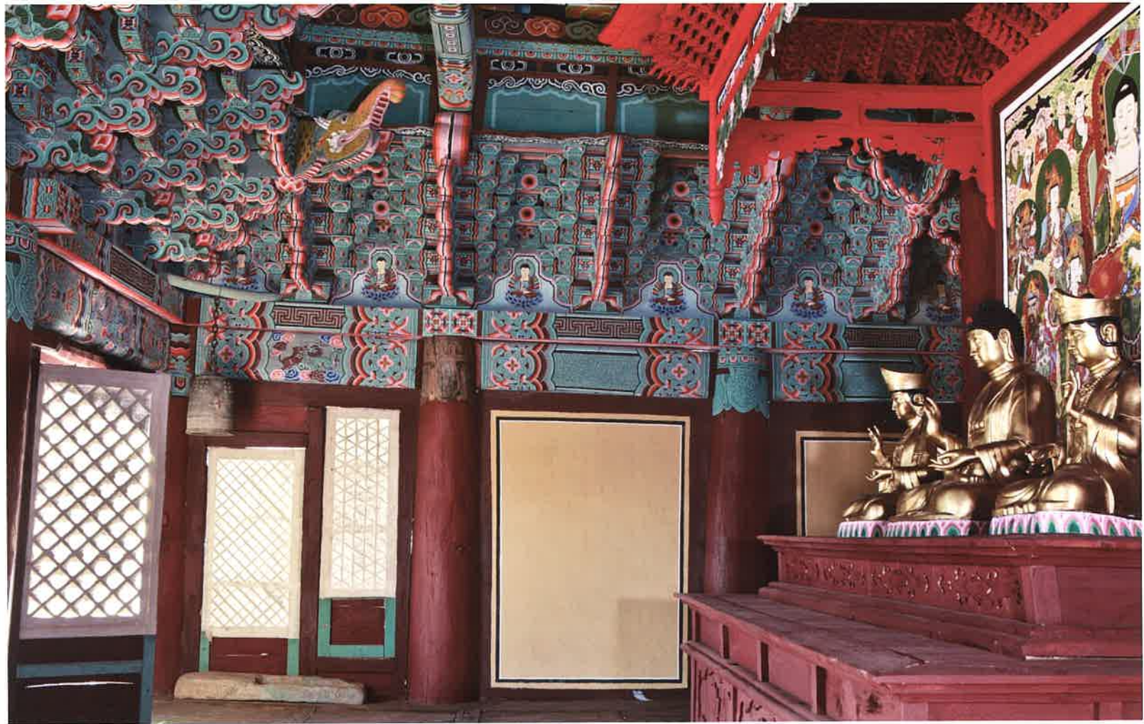
극락전 내부 서쪽 벽체 / 極樂殿 內部 西側 壁體 / western wall, Kungnakchön hall
