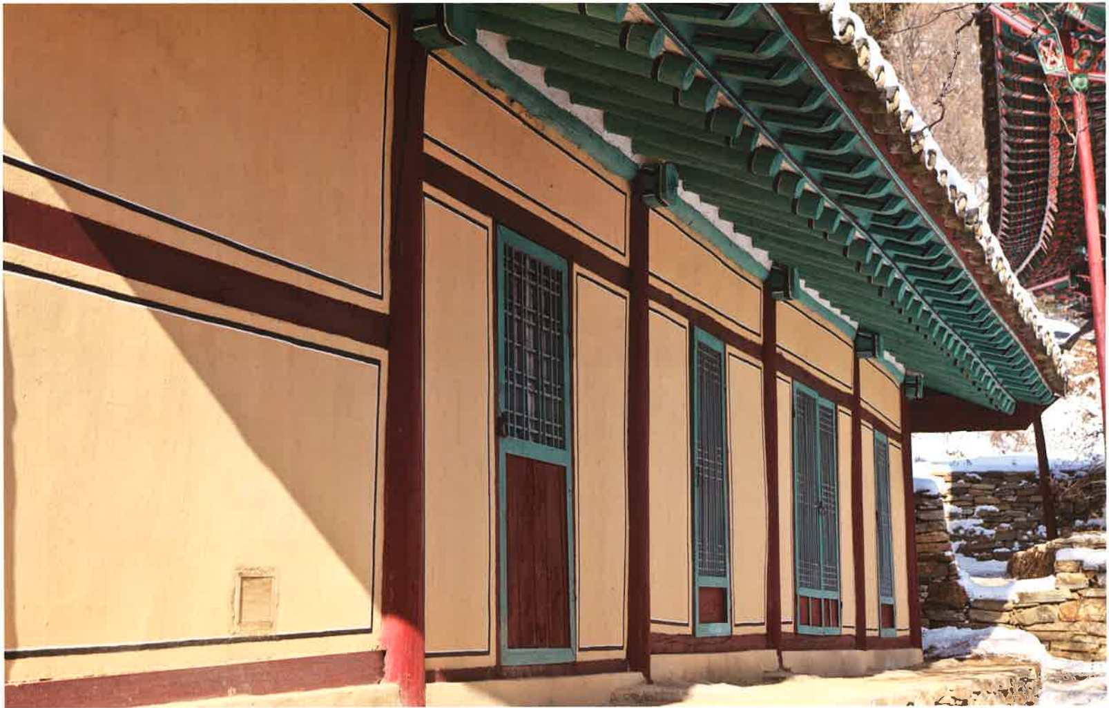
심검당 앞면 처마와 창호 / 尋劍堂 前面 軒·窓戶 / front eaves and doors, Simgondang hall
