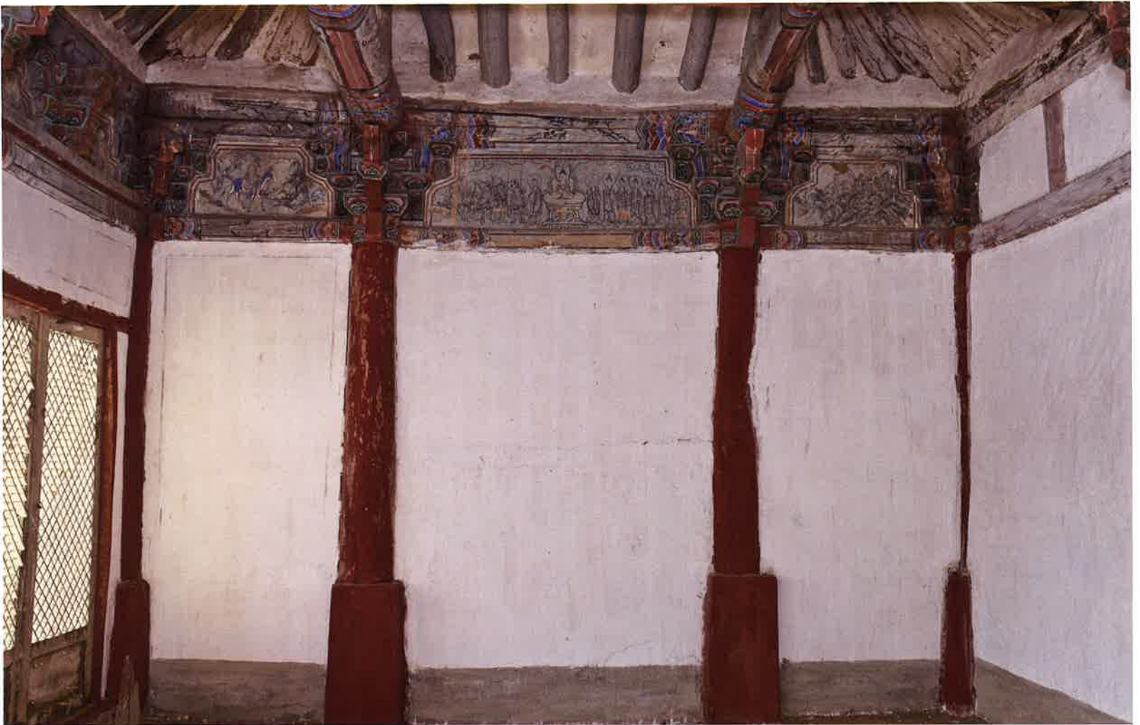
약사전 내부 서쪽 측면 벽체 / 藥師殿 內部 西側 壁體 / western wall, Yaksajön hall
