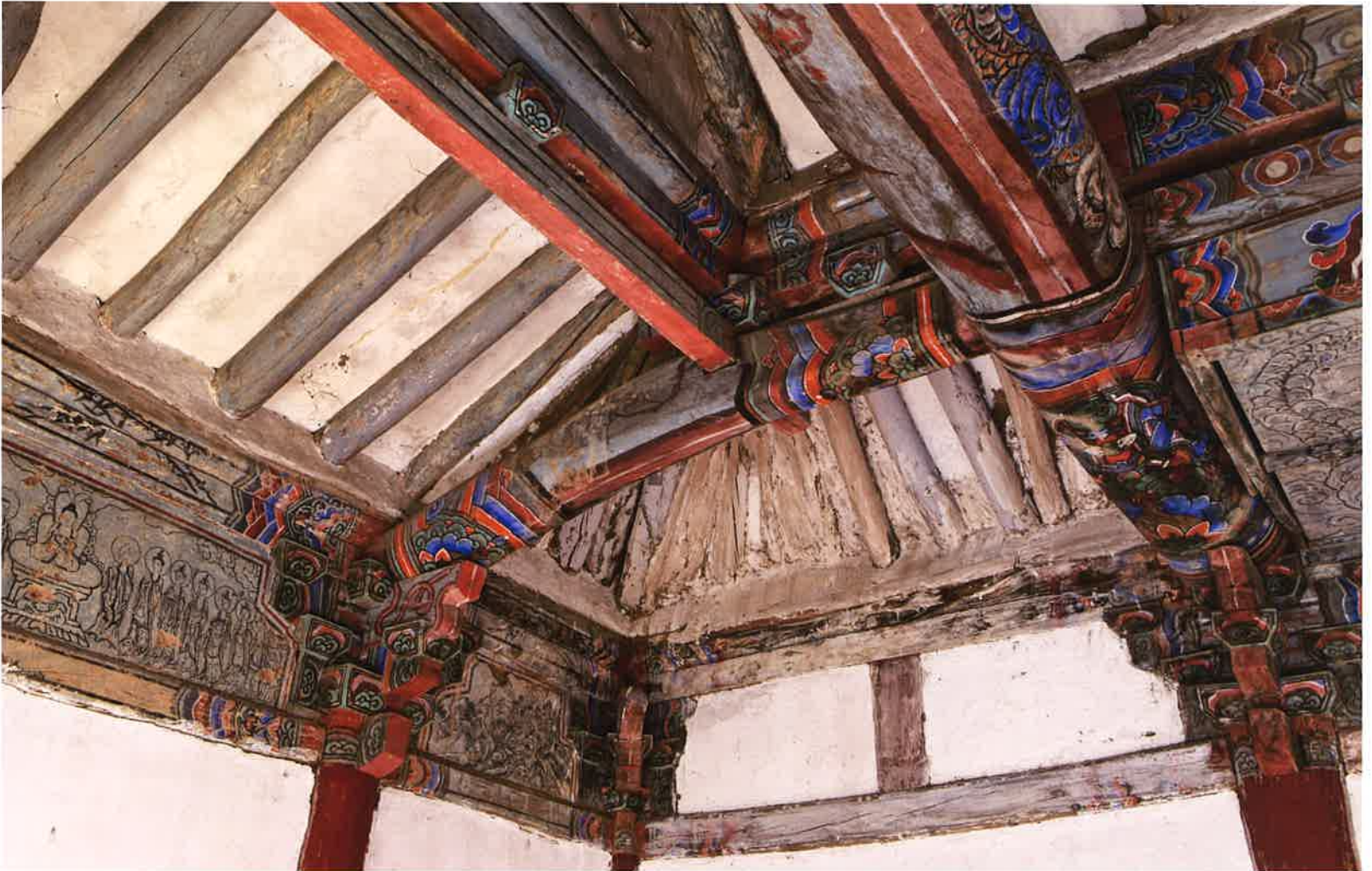
약사전 내부 서쪽 대들보와 총량 / 藥師殿 內部 西側 大樑·衡樑 / western main beam and measuring beam, Yaksajön hall
