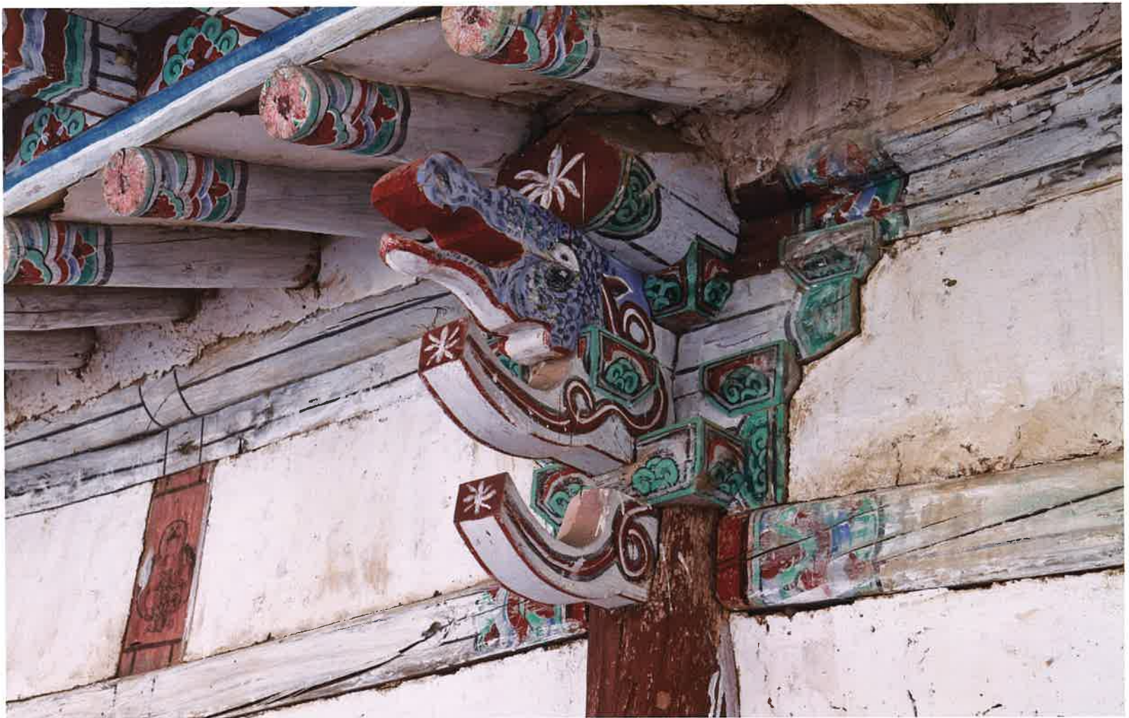
약사전 뒷면 주상포 / 藥師殿 後面 柱上包 / brackets above backward columns, Yaksajön hall
