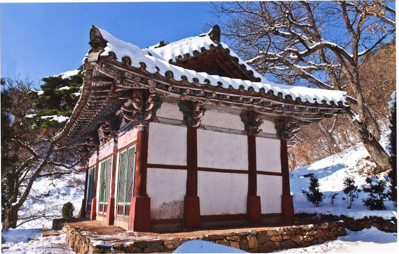
약사전 동쪽 측면 / 藥師殿 東側面 / eastern side, Yaksajön hall
