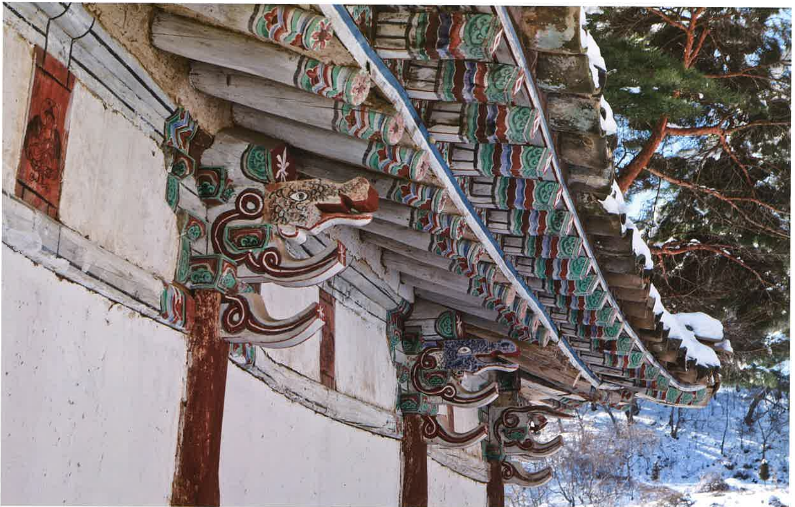
약사전 뒷면 공포 / 藥師殿 後面 栱包 / backward brackets, Yaksajon hall
