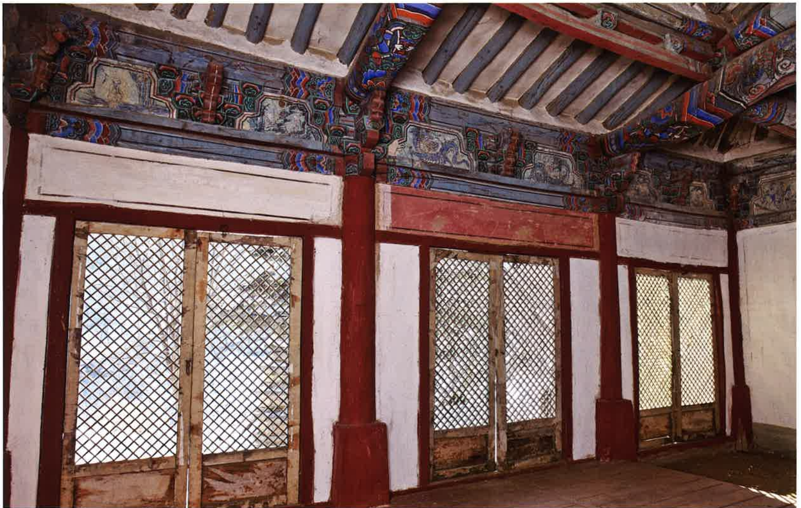
약사전 내부 앞면 / 藥師殿 內部 前面 / inside front, Yaksajön hall
