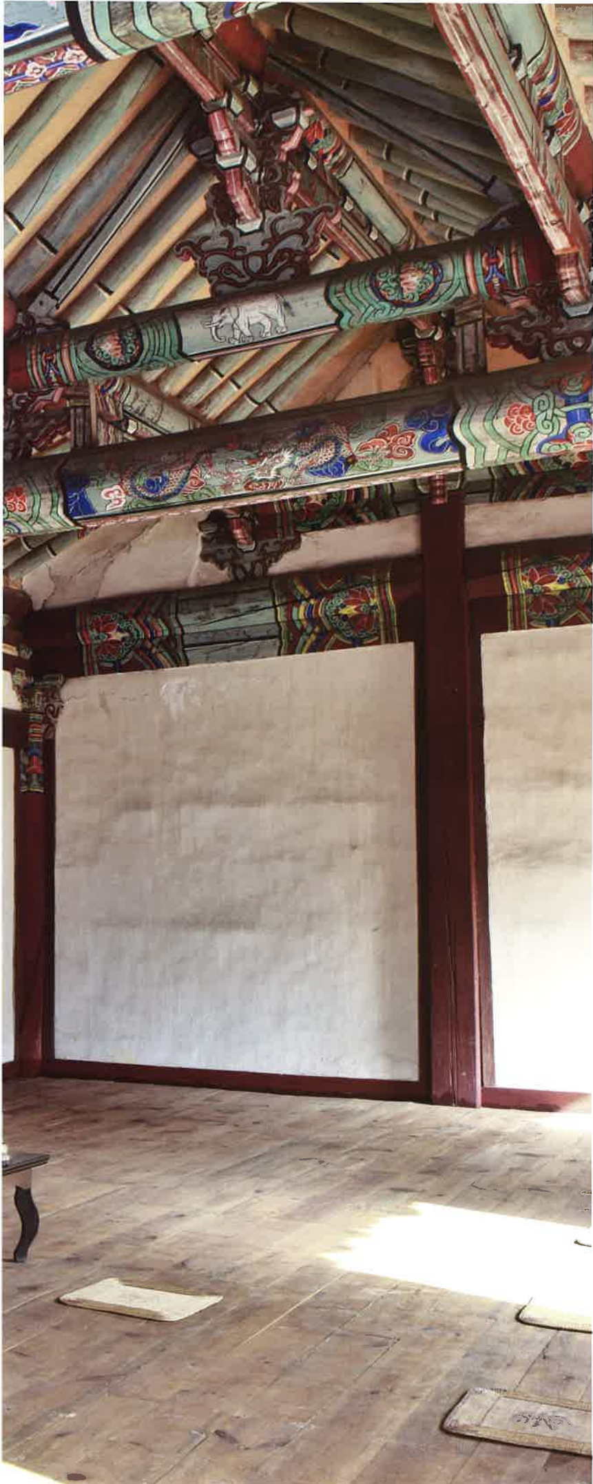
극락전 내부 전경 / 極樂殿 內部 全景 / inside whole view, Kungnakchón hall
