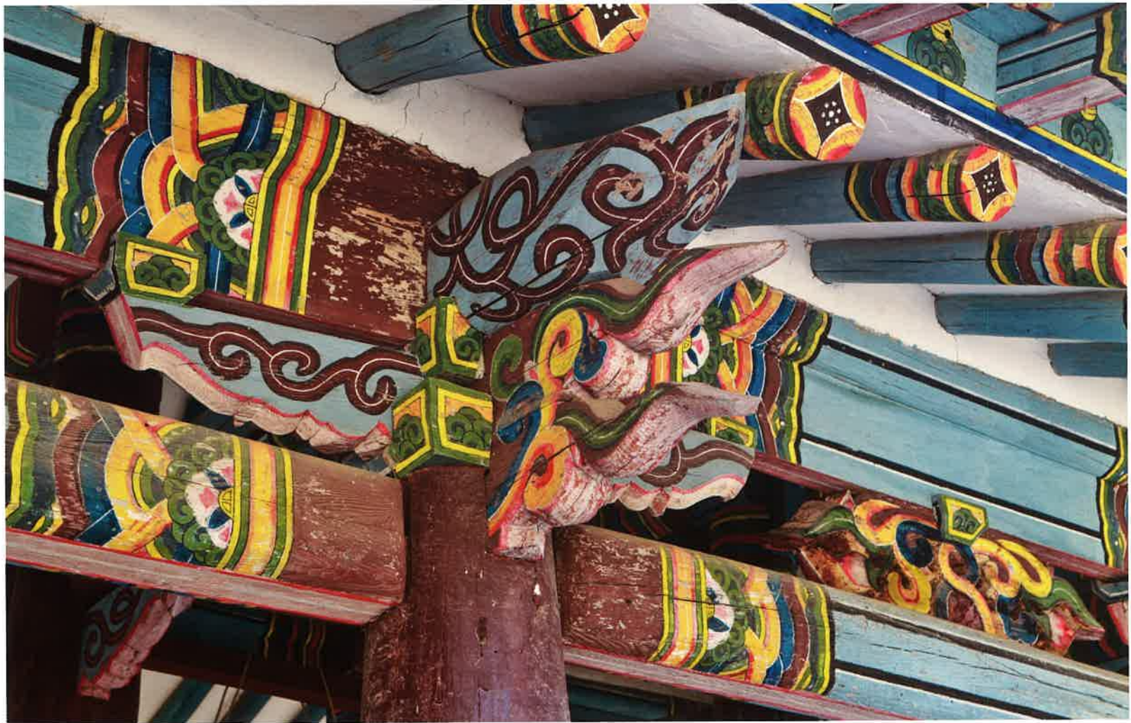
청풍루 뒷면 주상포 / 淸風樓 後面 柱上包 / brackets above backward columns, Ch'ongp'ungnu
