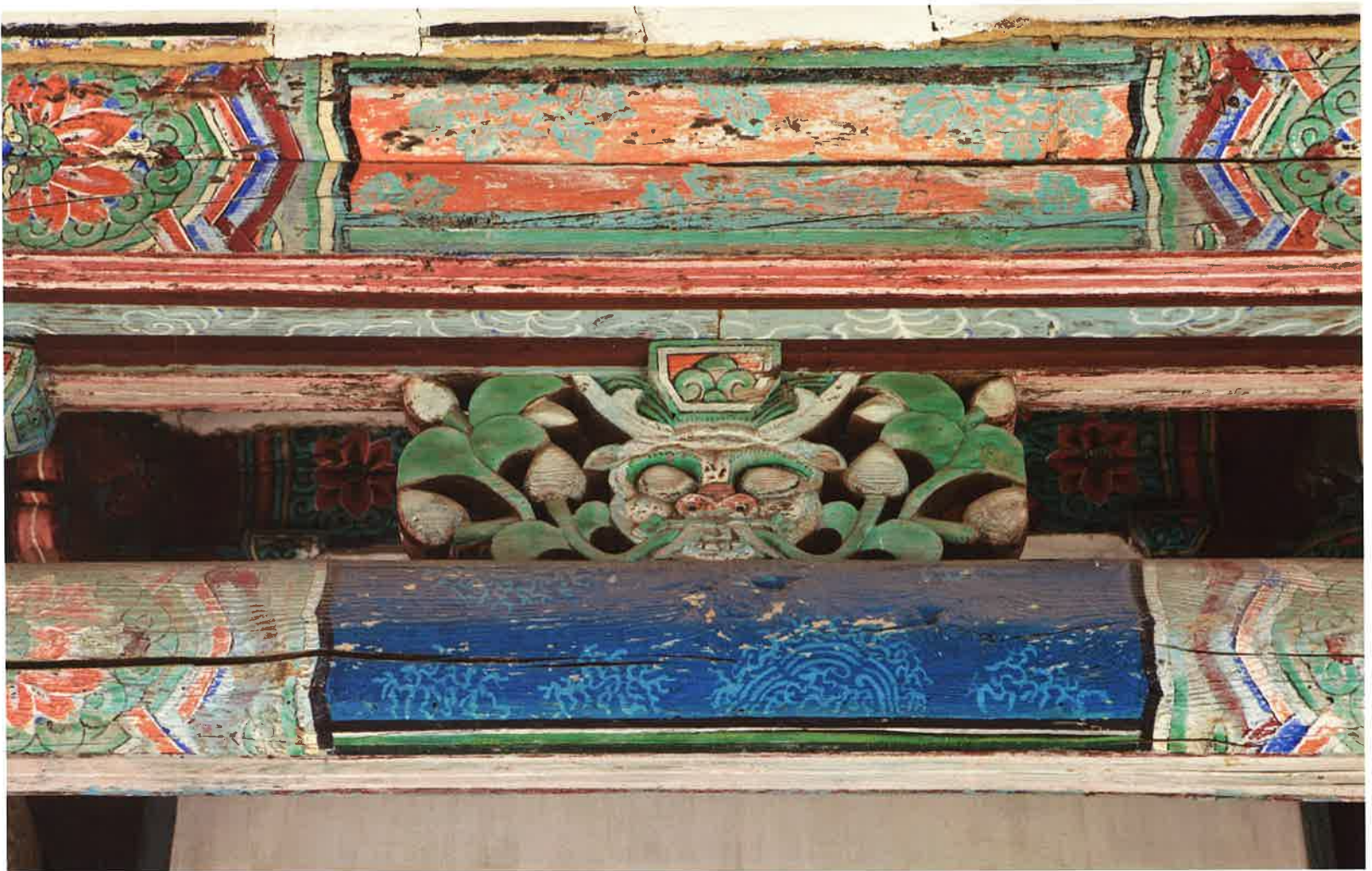
명부전 앞면 화반 / 冥府殿 前面 花盤 / front Hwabau, Myongbujon hall
