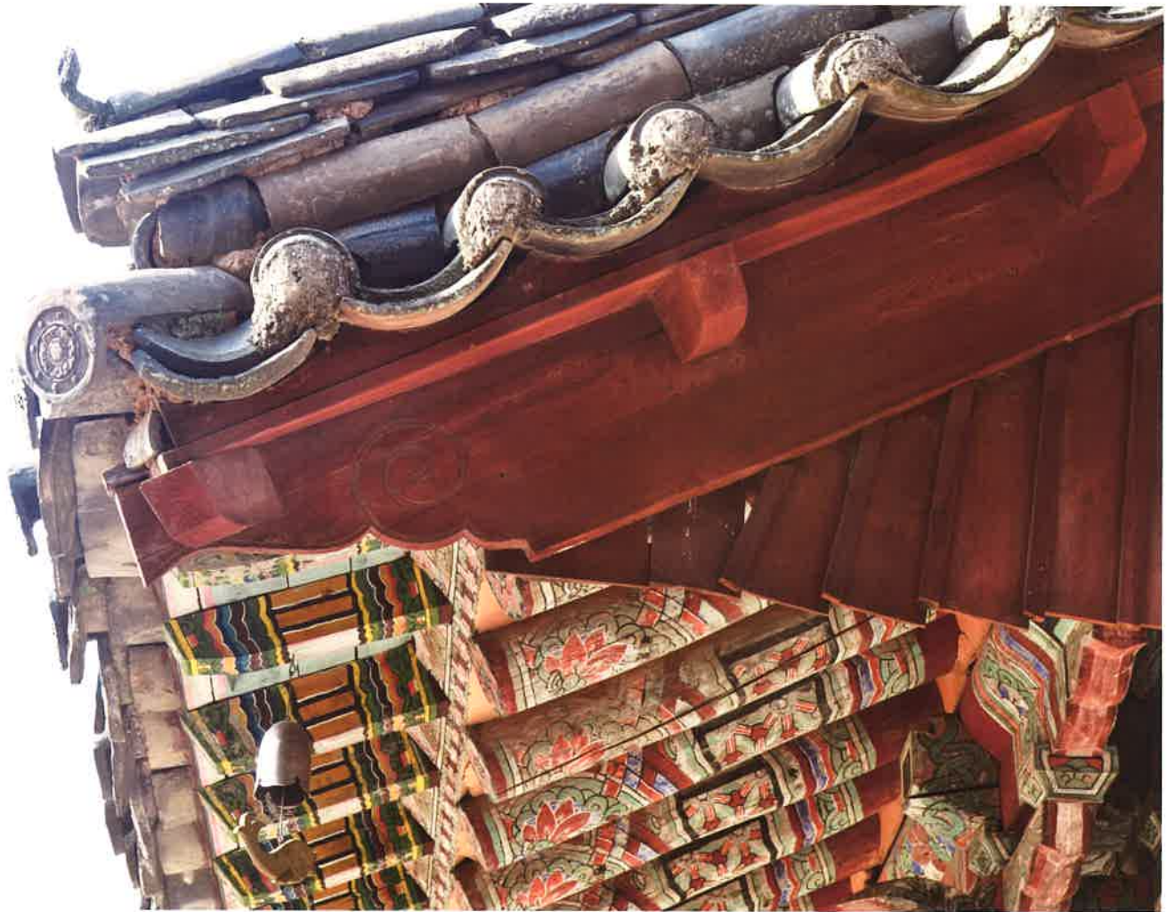
극락전 지붕 내림마루 / 極樂殿 屋蓋 / frontage floor of roof, Küngnakchön hall
