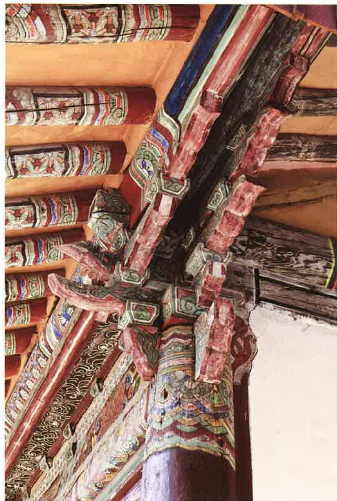
극락전 앞면 동쪽 귀포 / 極樂殿 前面 東側 耳包 front eastern corner brackets, Küngnakchön hall
