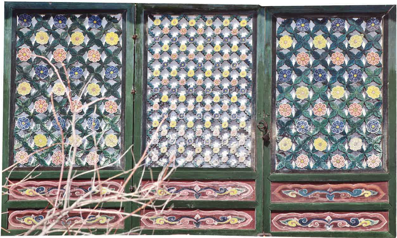
극락전 앞면 서쪽 헐간 창호 / 極樂殿 前面 西側 夾間 窓戶 / front western doors, Küngnakchón hall
