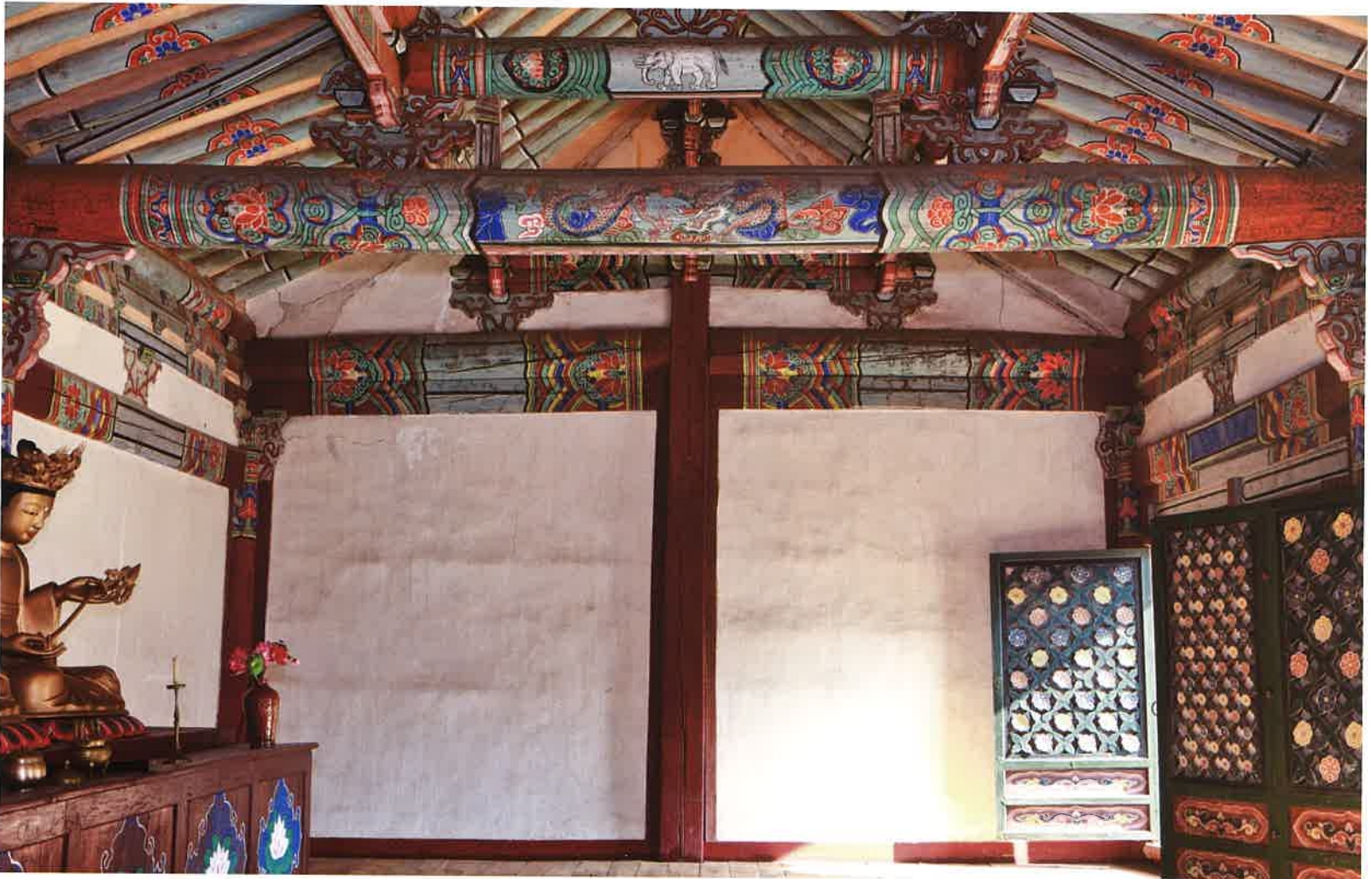
극락전 내부 동쪽 벽체 / 極樂殿 內部 東側 壁體 / eastern wall, Kungnakchön hall
