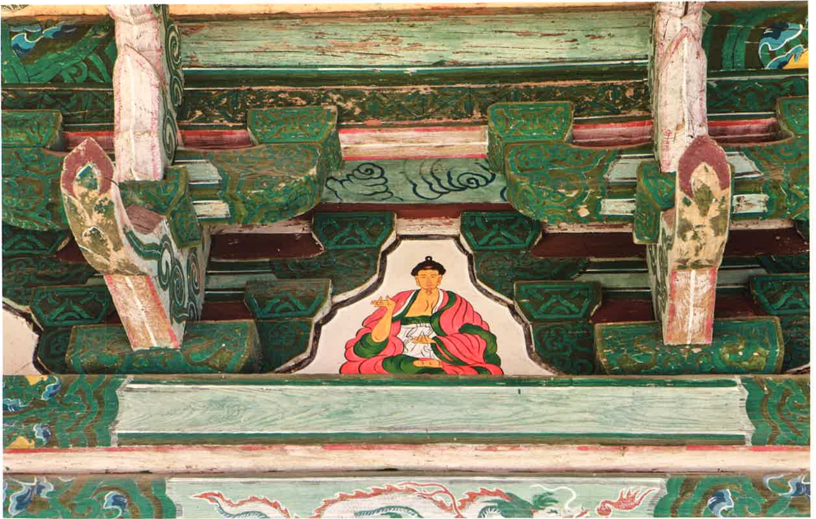
응진전 앞면 화반 / 應眞殿 前面 花盤 / front Hwaban, Üngjinjön hall
