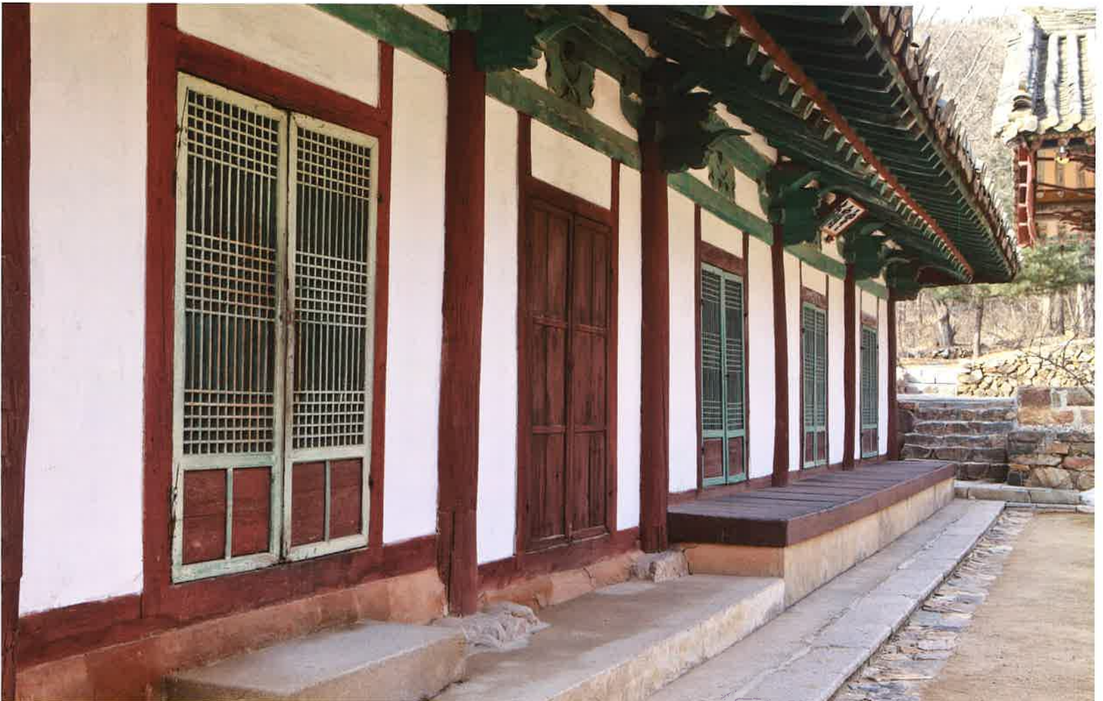
운하당 앞면 처마와 공포 / 雲霞堂 前面 軒·拱包 / front eaves and brackets, Unhadang hall
