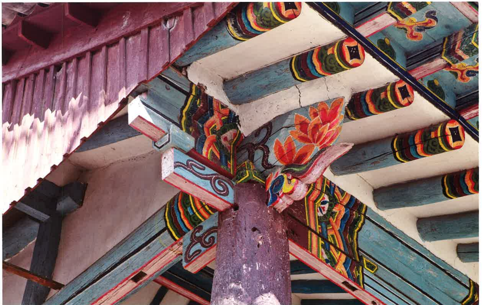
청풍루 앞면 귀포 / 淸風樓 前面 耳包 / front corner brackets, Ch'ongp'ungnu
