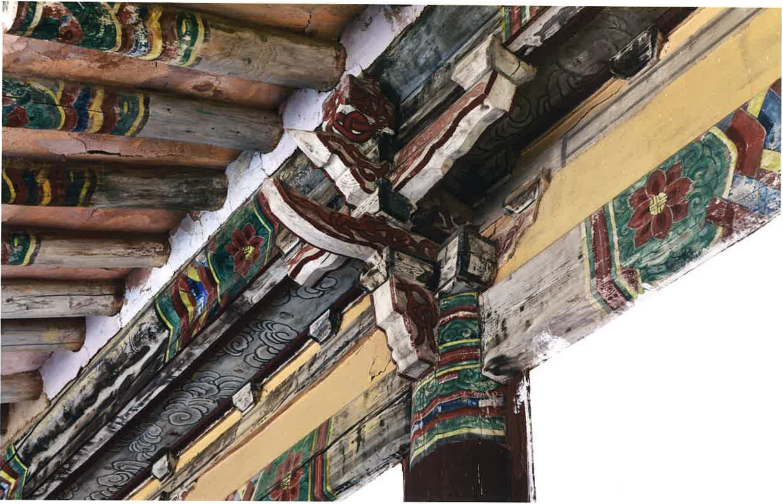
극락전 뒷면 주상포 / 極樂殿 後面 柱上包 / brackets above backward columns, Kūngnakhōn hall
