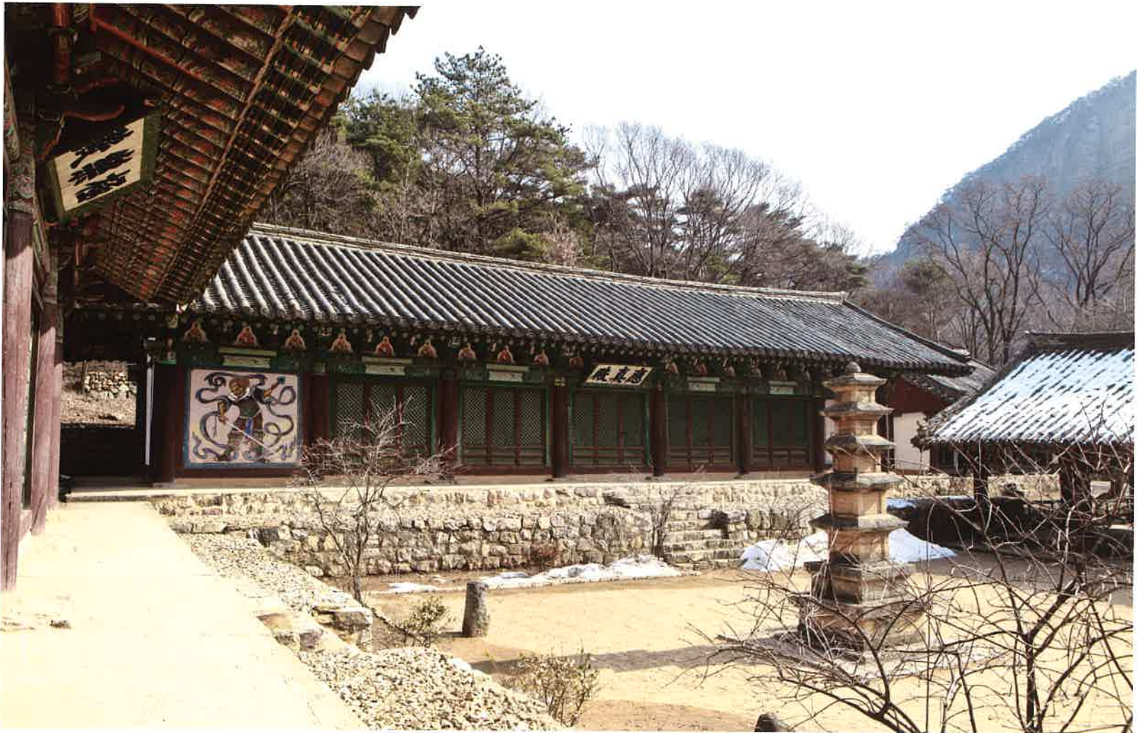
응진전 전경 / 應眞殿 全景 / whole view, Üngjinjön hall
