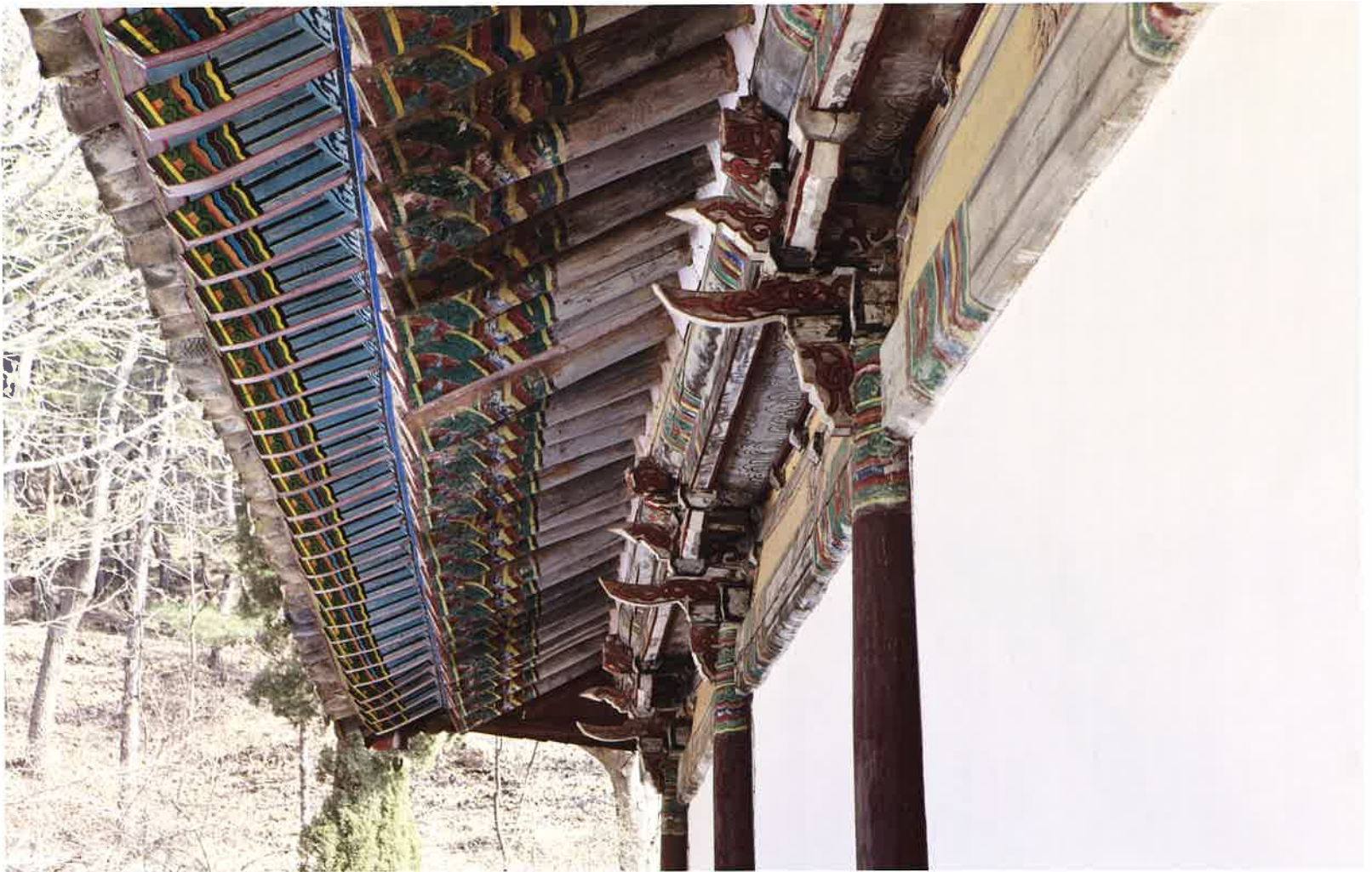
극락전 뒷면 처마와 공포 / 極樂殿 後面 軒·拱包 / backward eaves and brackets, Kungnakchön hall
