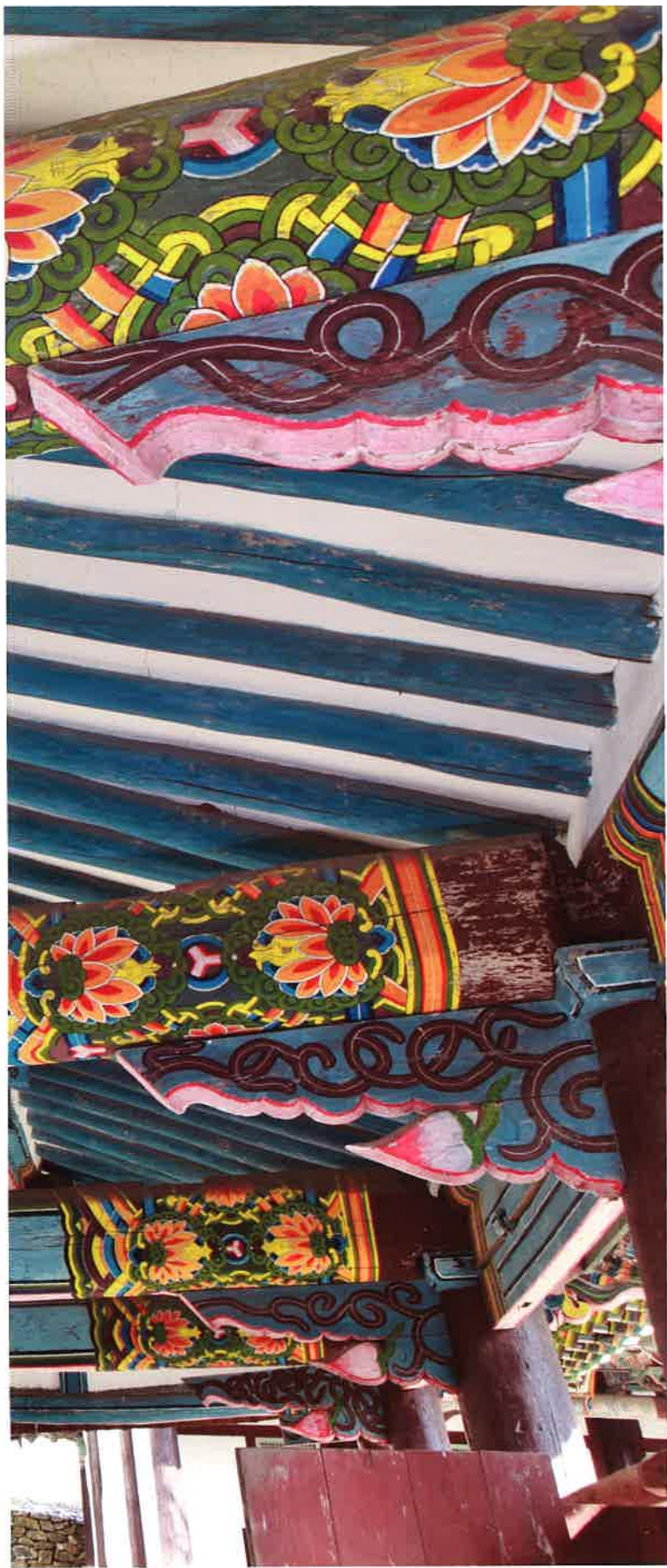
청풍루 내부 반자 / 淸風樓 內部 天障 / ceiling, Ch'ongp'ungnu
