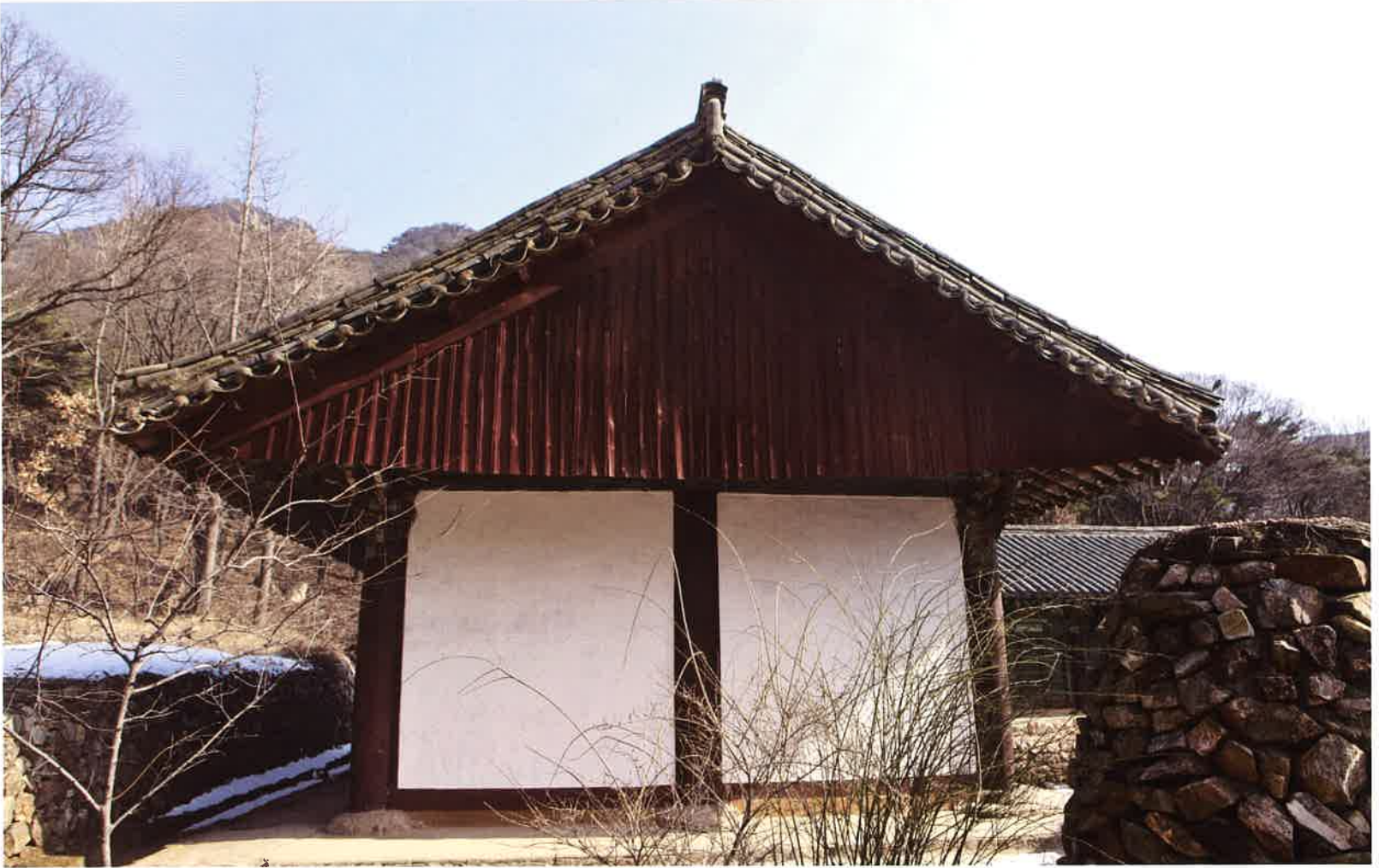
극락전 서쪽 측면 / 極樂殿 西側面 / western side, Kūngnakchön hall
