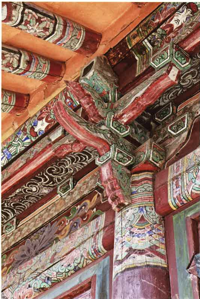
극락전 앞면 주상포 / 極樂殿 前面 柱上包 brackets above front columns, Küngnakchön hall
