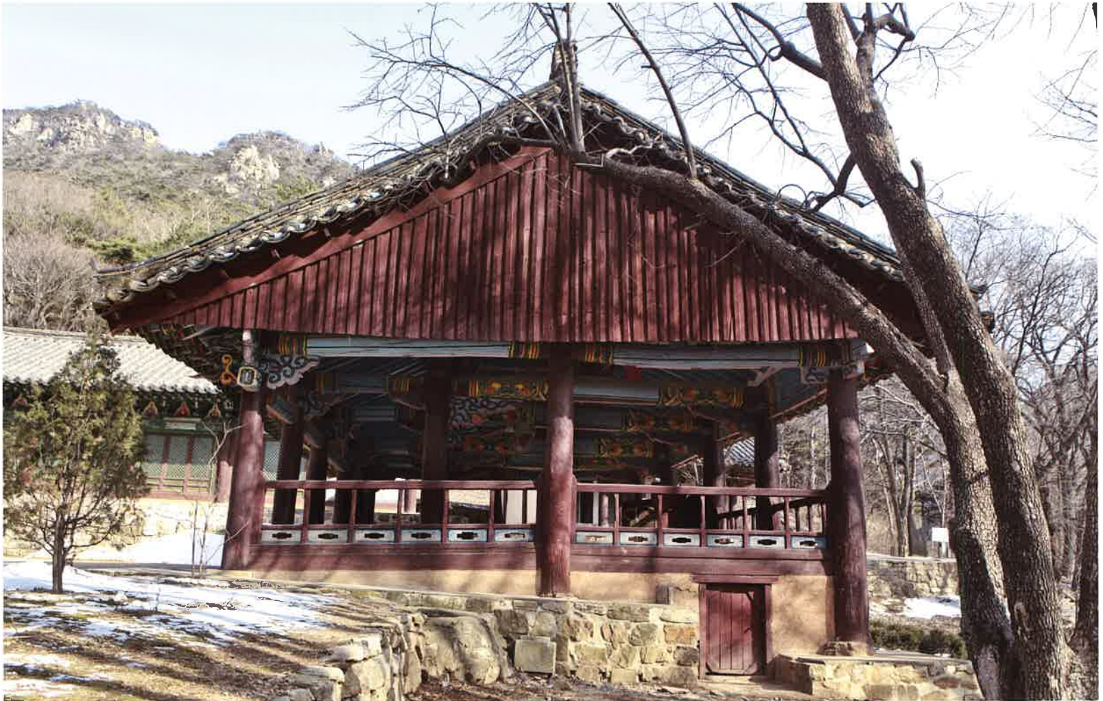
청풍루 서쪽 측면 / 淸風樓 西側面 / western side, Ch'ongp'ungnu
