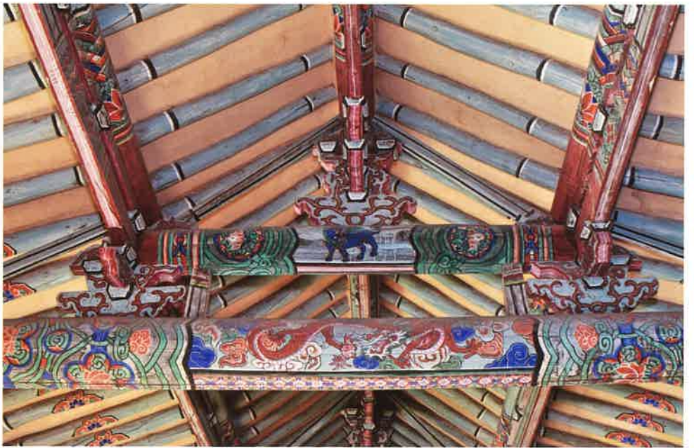
극락전 내부 대들보와 종보 / 極樂殿 內部 大樑·宗樑 main beam and collar beam, Kungnakchón hall
