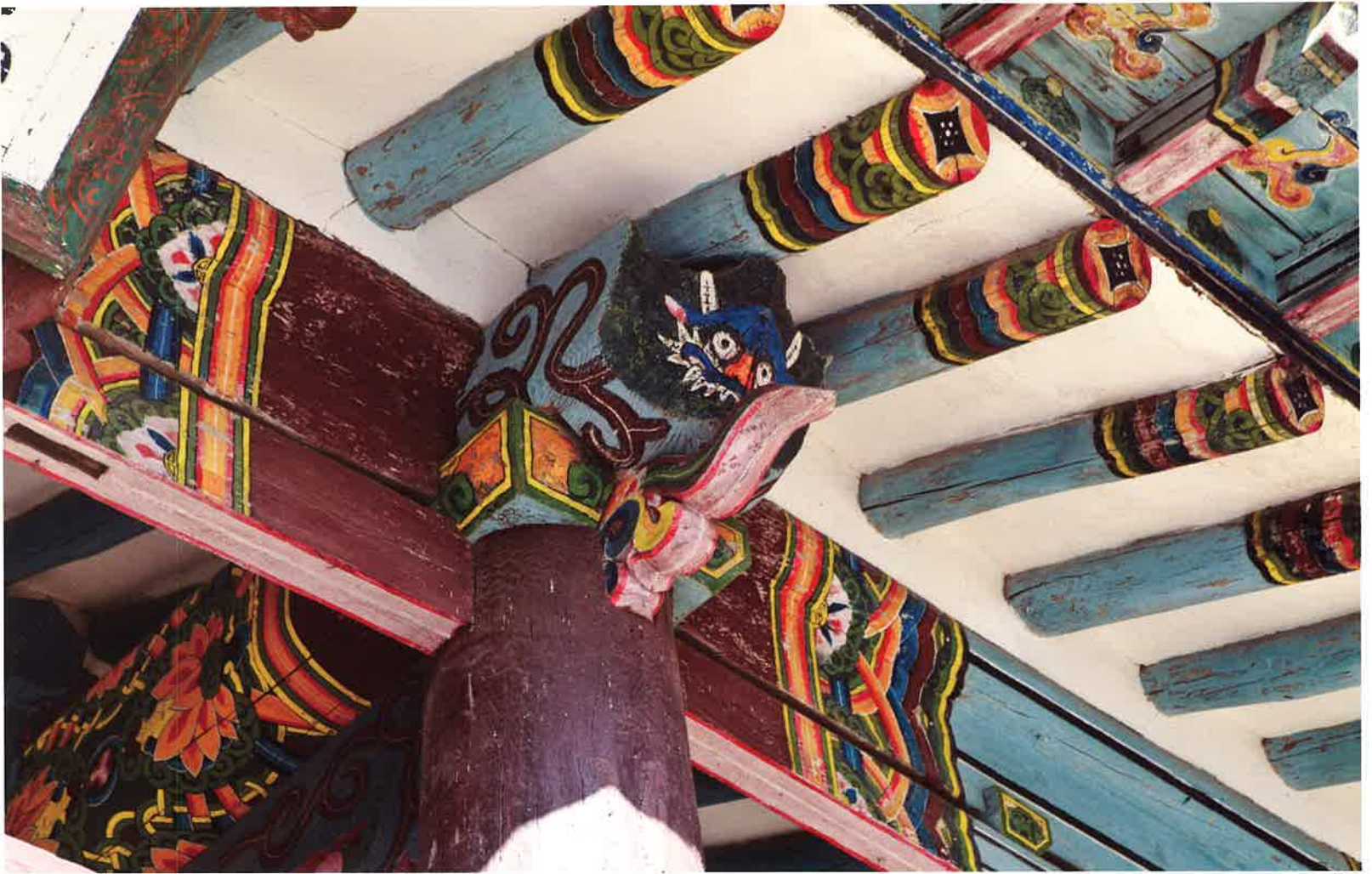
청풍루 앞면 주상포 / 淸風樓 前面 柱上包 / brackets above front columns, Ch'ongp'ungnu
