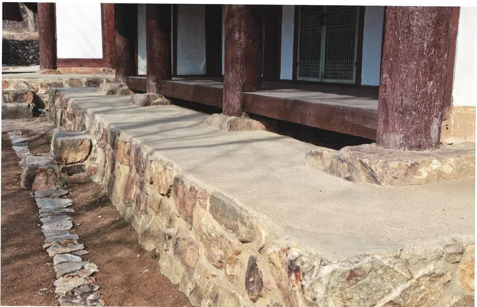
명부전 앞 기단 / 冥府殿 前面 基壇 / front stylobate, Myongbujon hall
