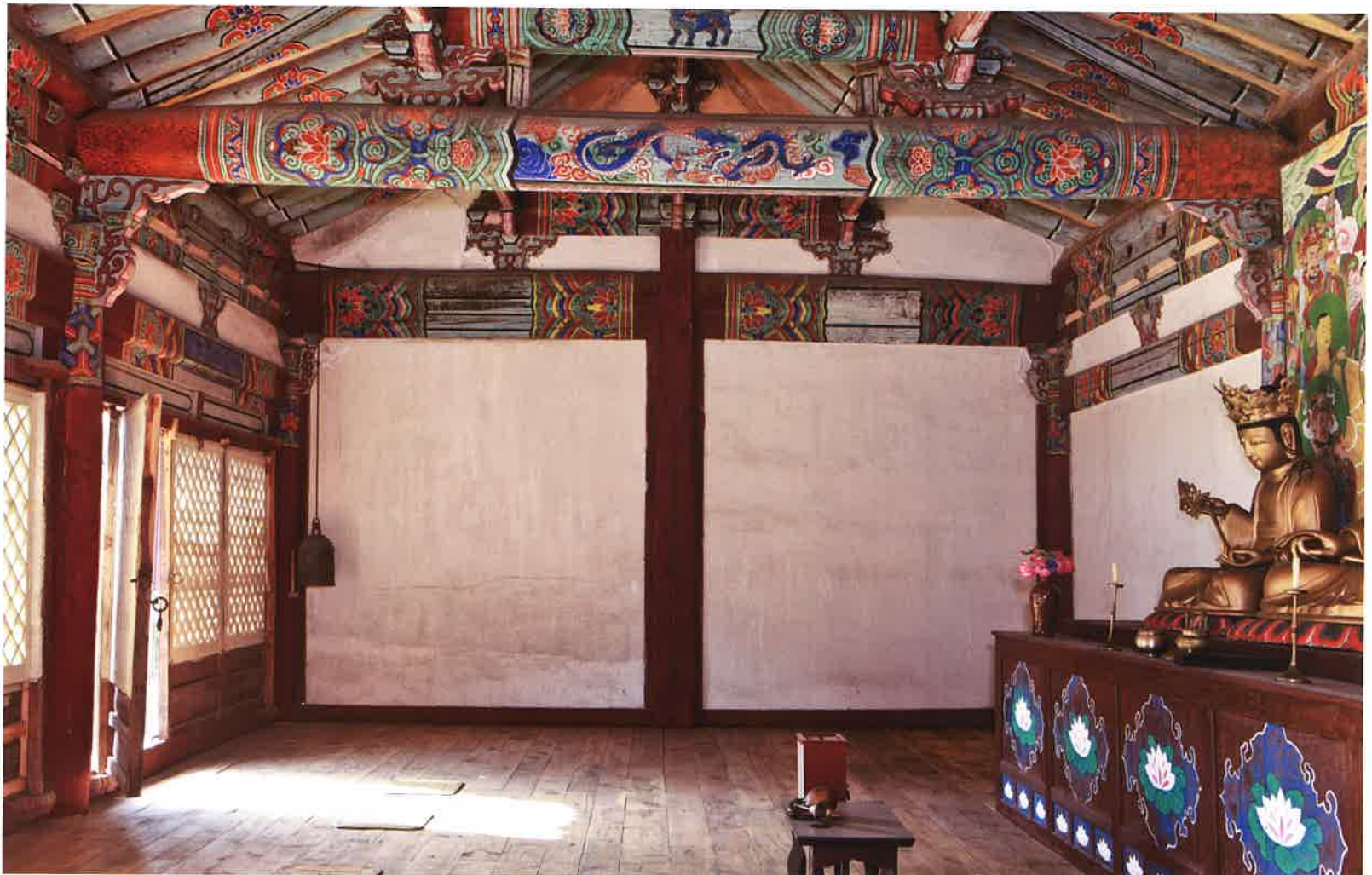
극락전 내부 서쪽 벽체 / 極樂殿 內部 西側 壁體 / western wall, Kungnakchön hall
