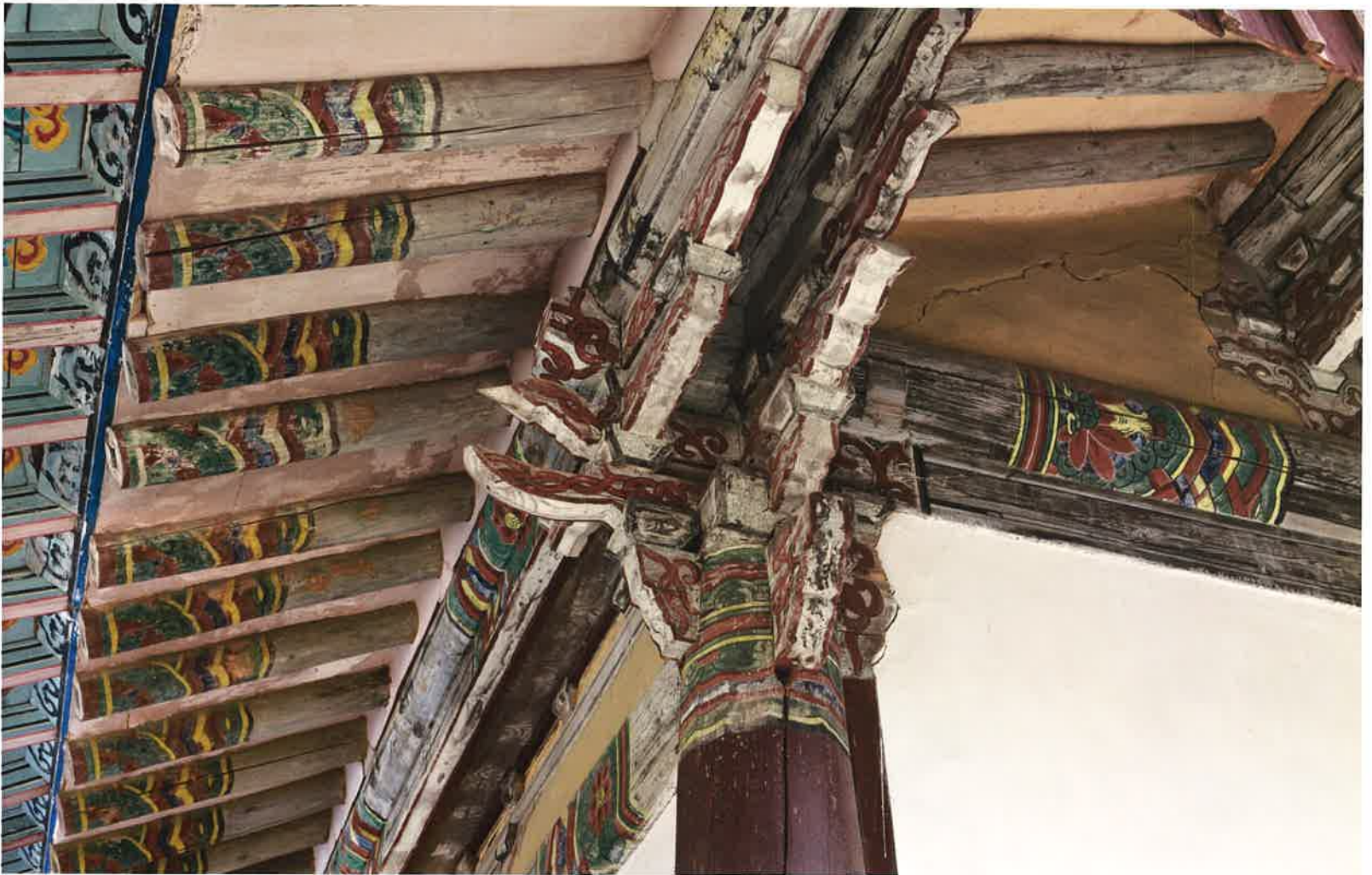
극락전 뒷면 서쪽 귀포 / 極樂殿 後面 西側 耳包 / backward western corner brackets, Kūngnakhōn hall
