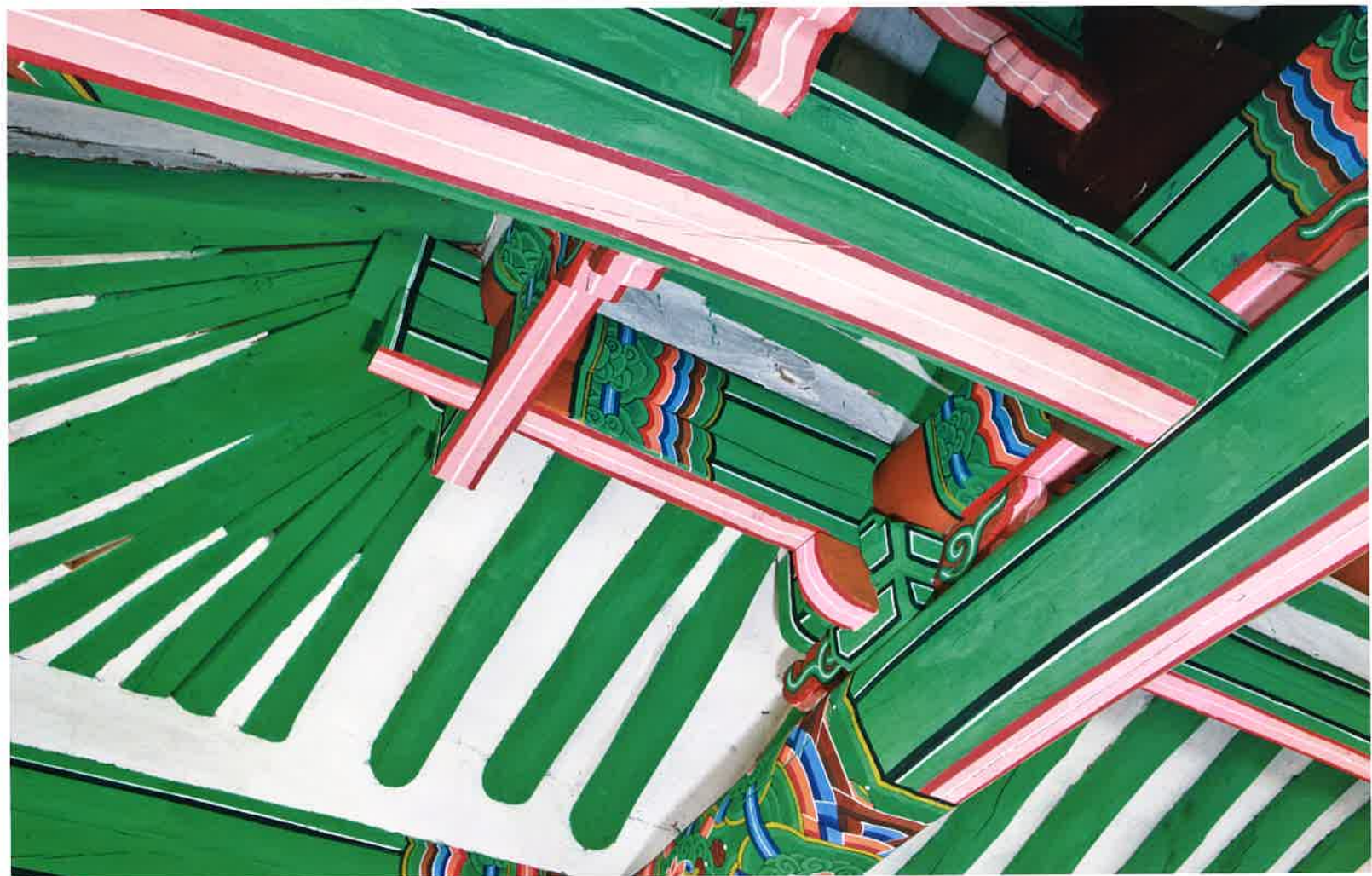
청풍루 내부 대들보와 측량 / 淸風樓 內部 大樑·衡樑 / main beam and measuring beam, Ch'ongp'ungnu
