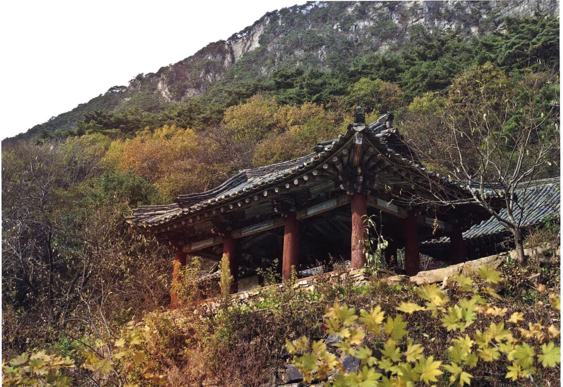
보수 전 청풍루 전경 / 補修 前 淸風樓 全景 / whole view, Ch'ongp'ungnu(before being repaired)
