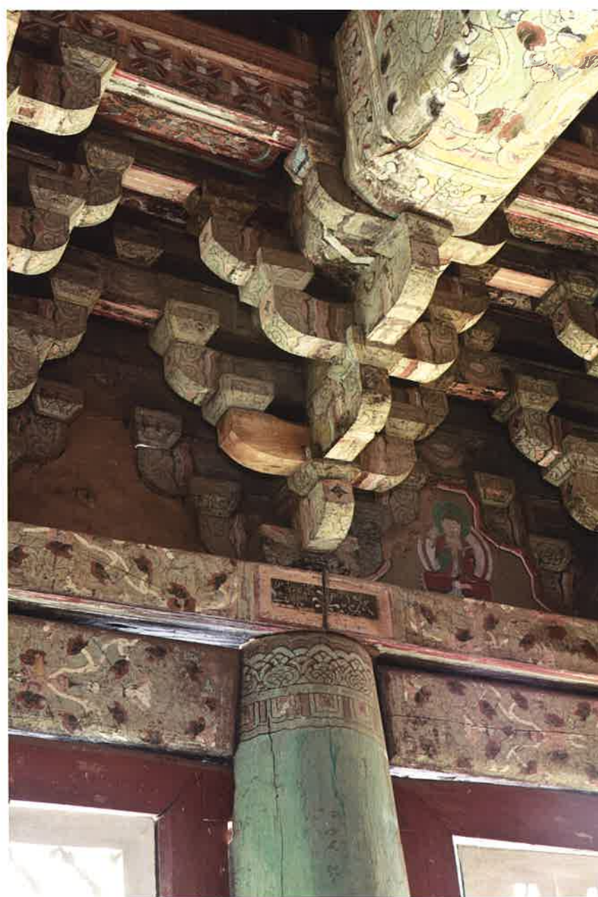
보광전 내부 앞면 주상포 / 普光殿 内部 前面 柱上包 brackets above front columns, Pogwangjon hall
