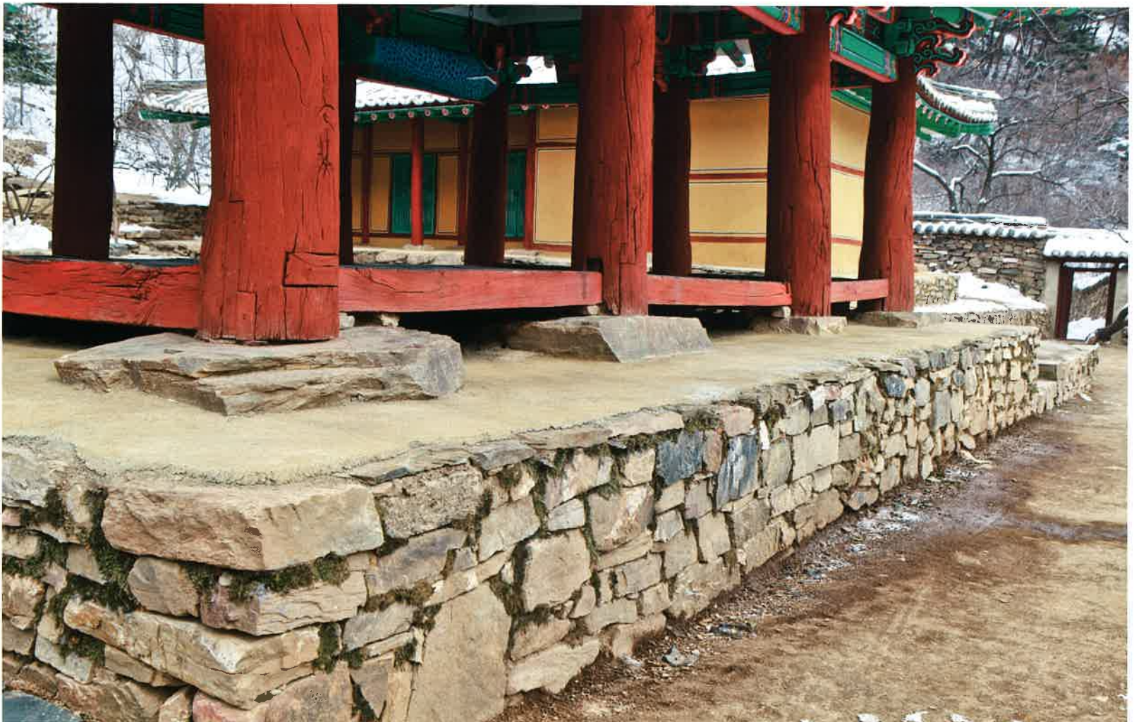
청풍루 앞 기단 / 淸風樓 前面 基壇 / front stylobate, Ch'ongp'ungnu
