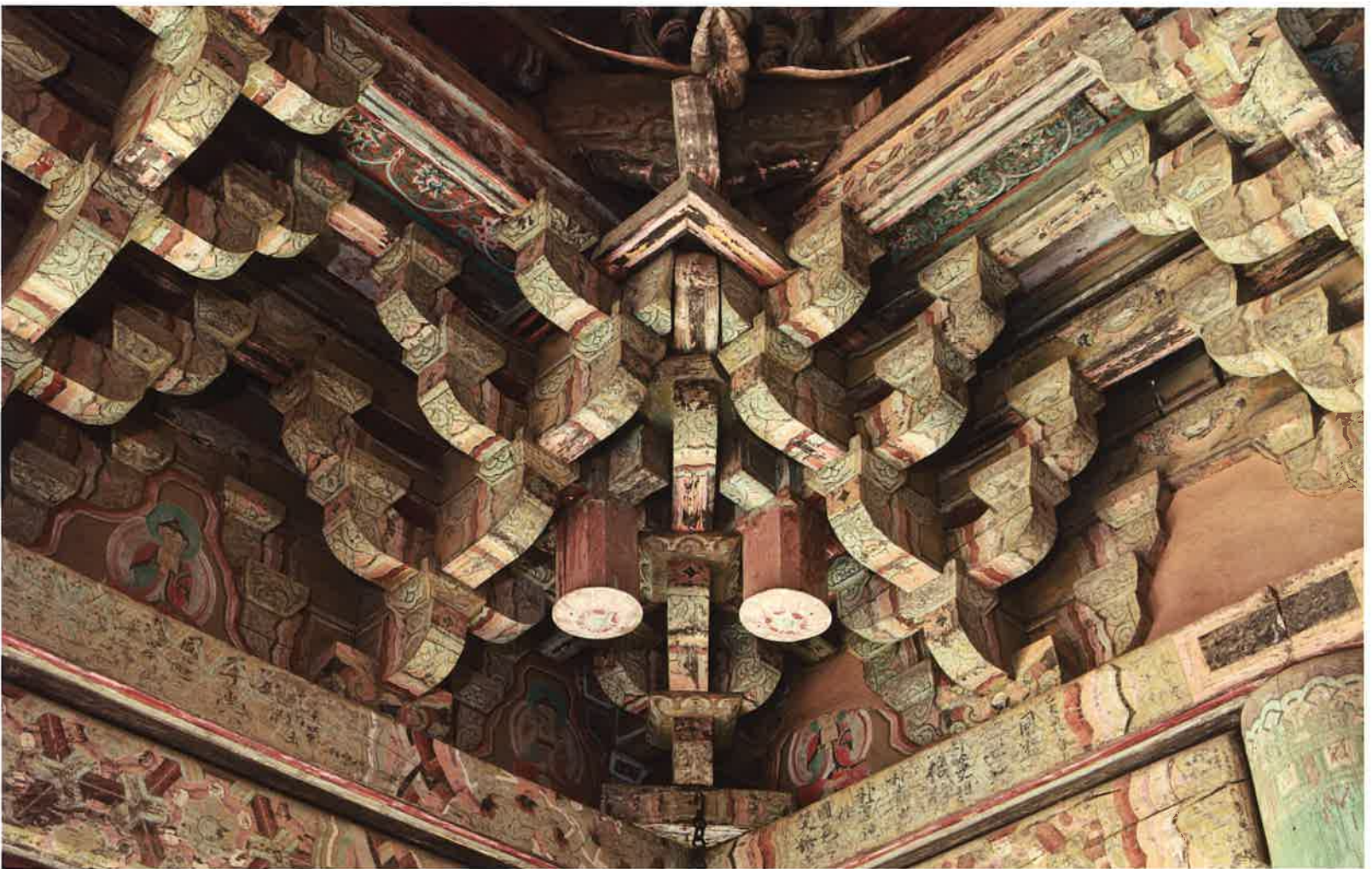
보광전 내부 앞면 서쪽 귀포 / 普光殿 內部 前而 西側 耳包 / front western corner brackets, Pogwangjon hall
