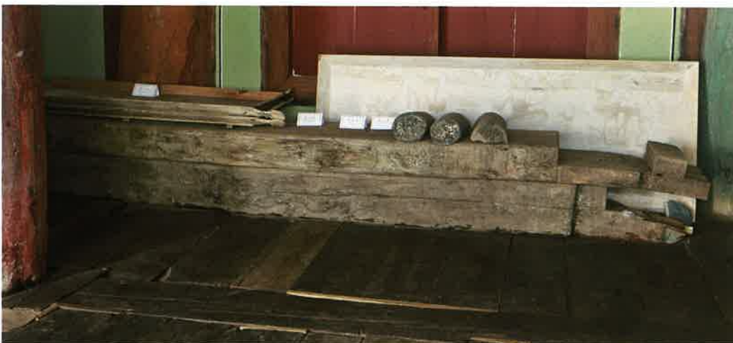
2009년 8월 보광전 보수 때 발견된 현판과 액방 / 懸板·額枋 / tablet and lintel
