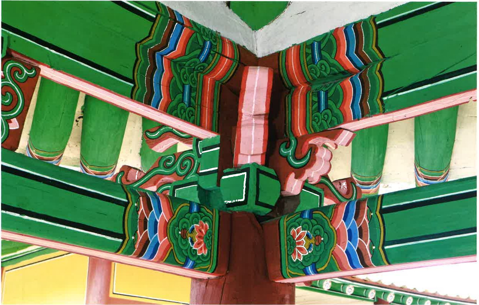
청풍루 내부 귀포 / 淸風樓 內部 耳包 / corner brackets, Ch'ongp'ungnu
