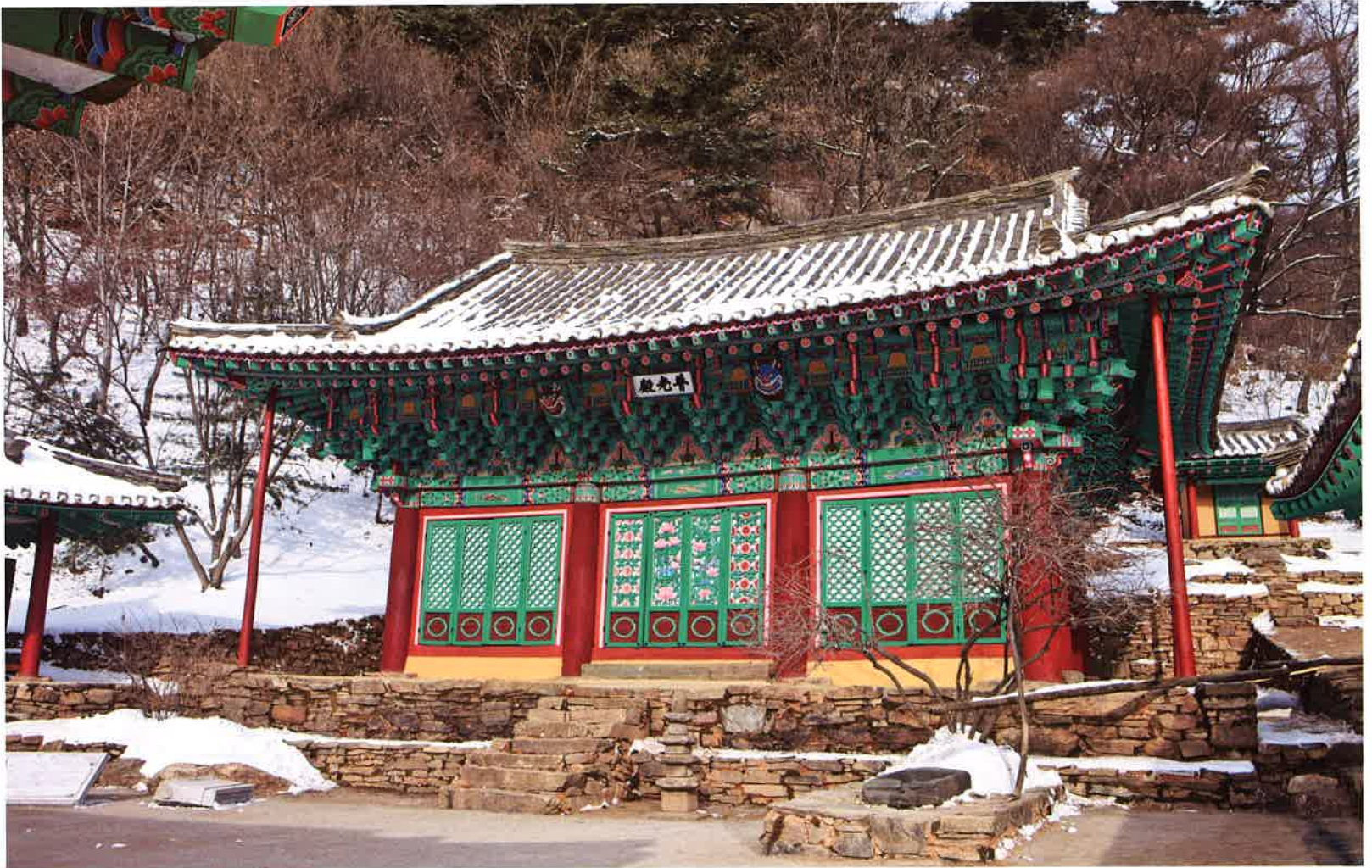
2010년 중수 후의 보광전 / 重修後 普光殿 / Pogwangjŏn hall after being repaired in 2010
