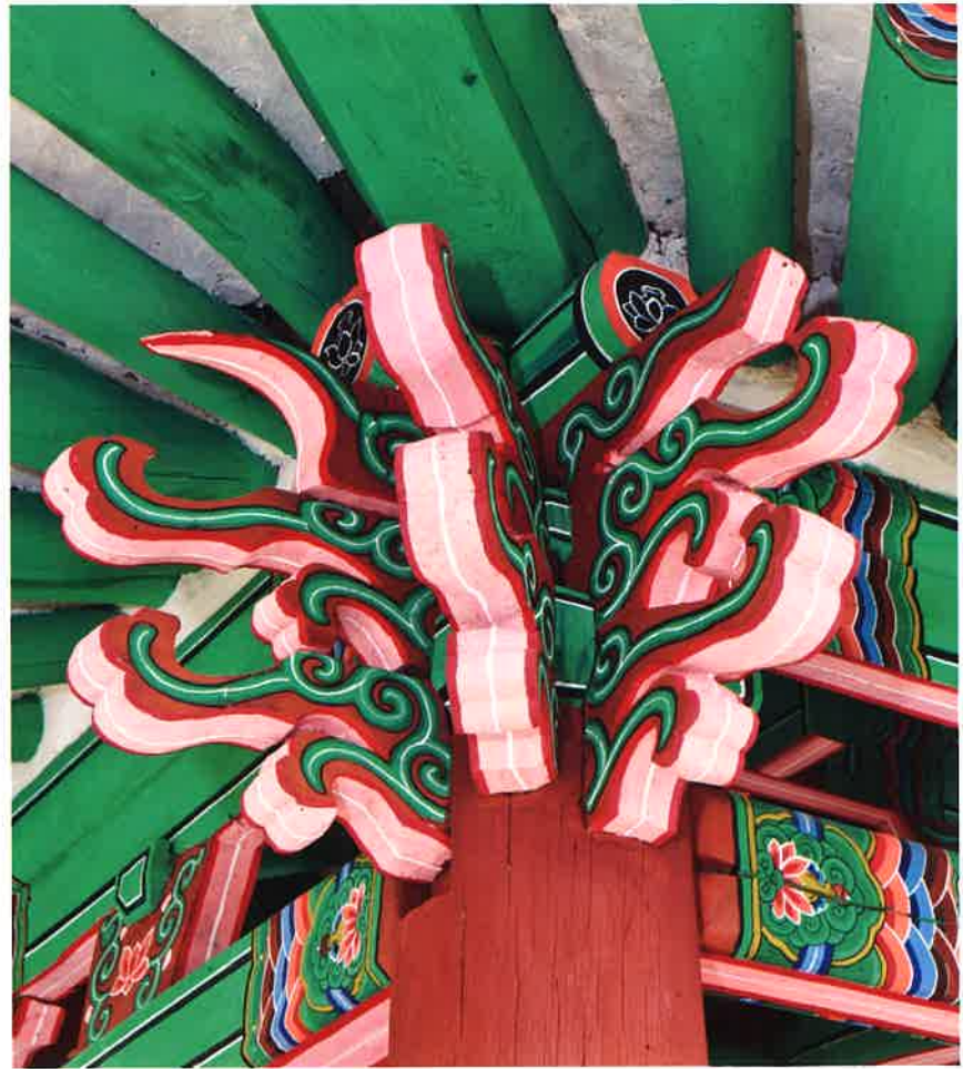
청풍루 뒷면 귀포 / 淸風樓 後面 耳包 / backward corner brackets, Ch'ongp'ungnu
