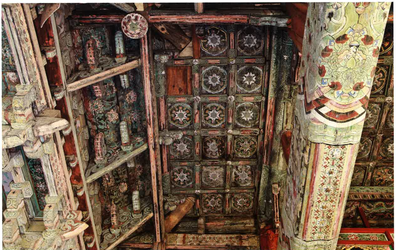
보광전 내부 소란반자 / 普光殿 內部 格子天障 / latticed ceiling, Pogwangjŏn hall
