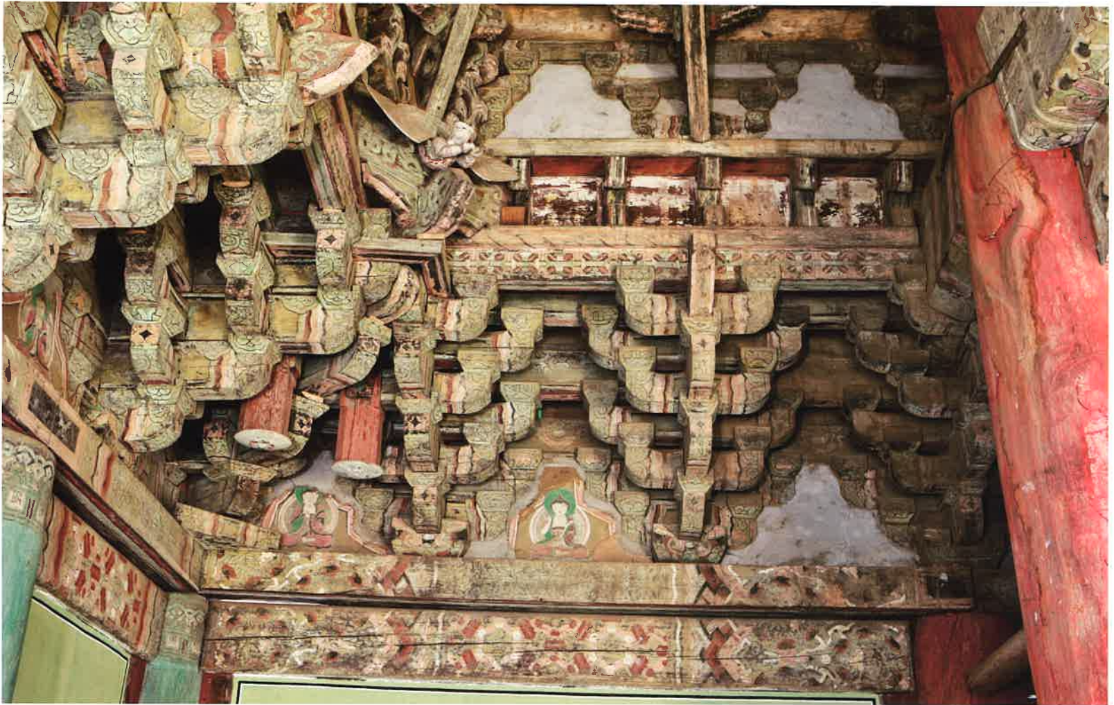
보광전 내부 서쪽 주간포 / 普光殿 內部 西側 柱間包 / brackets between western columns, Pogwangjon hall
