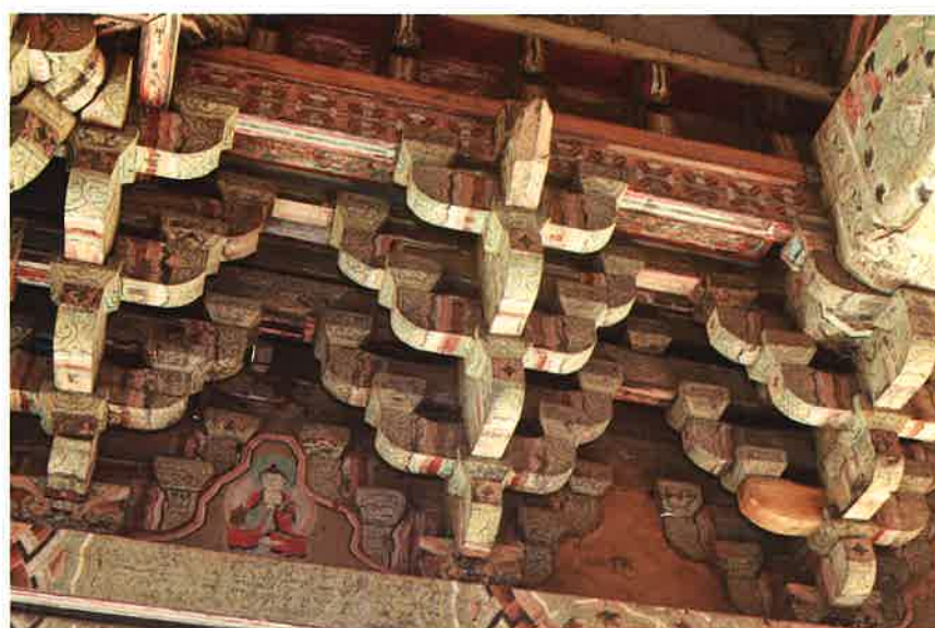
보광전 내부 앞면 주간포 / 普光殿 内部 前面 柱間包 brackets between front columns, Pogwangjon hall
