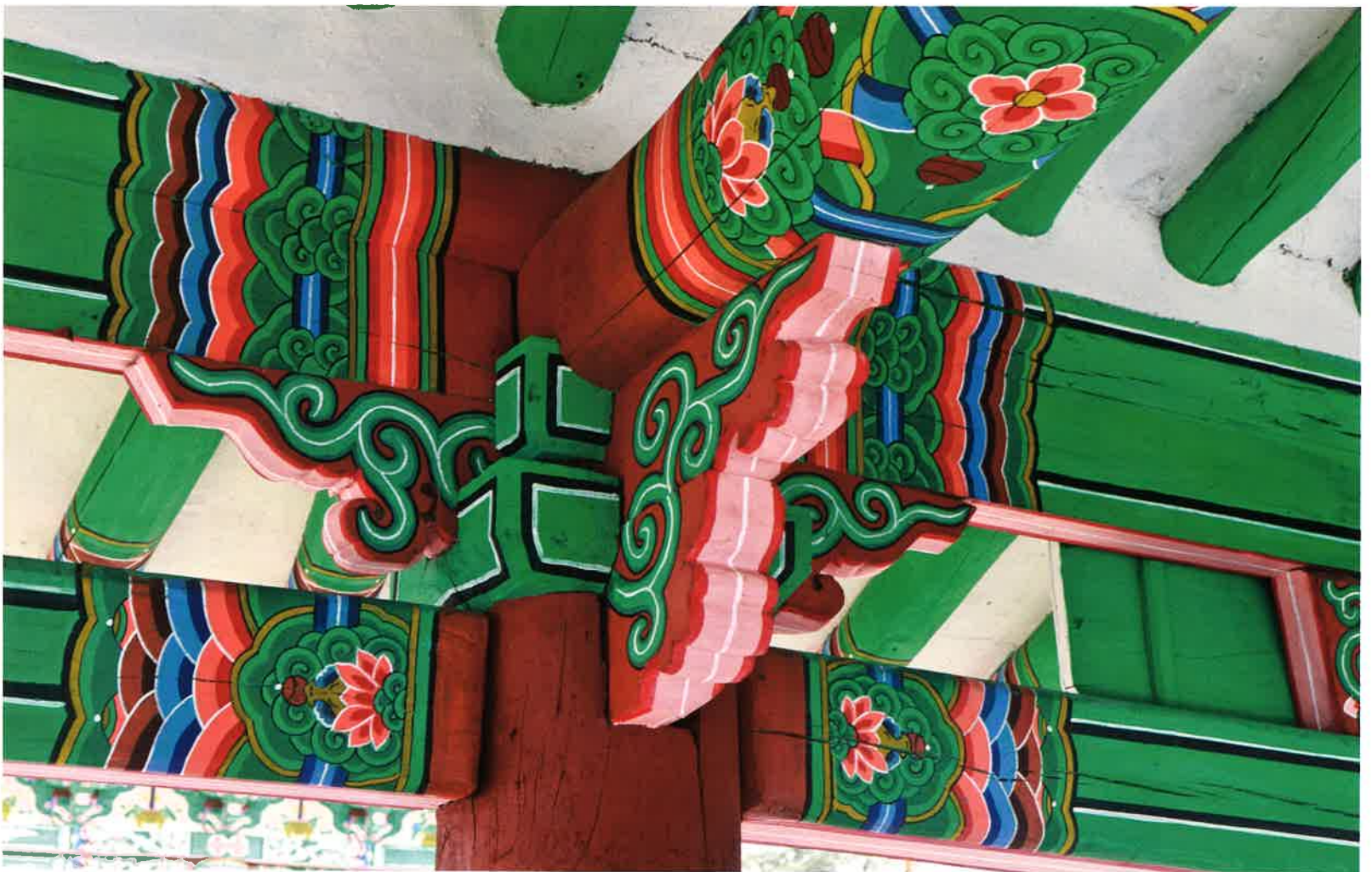
청풍루 내부 주상포 / 淸風樓 內部 柱上包 / brackets above columns, Ch'ongp'ungnu
