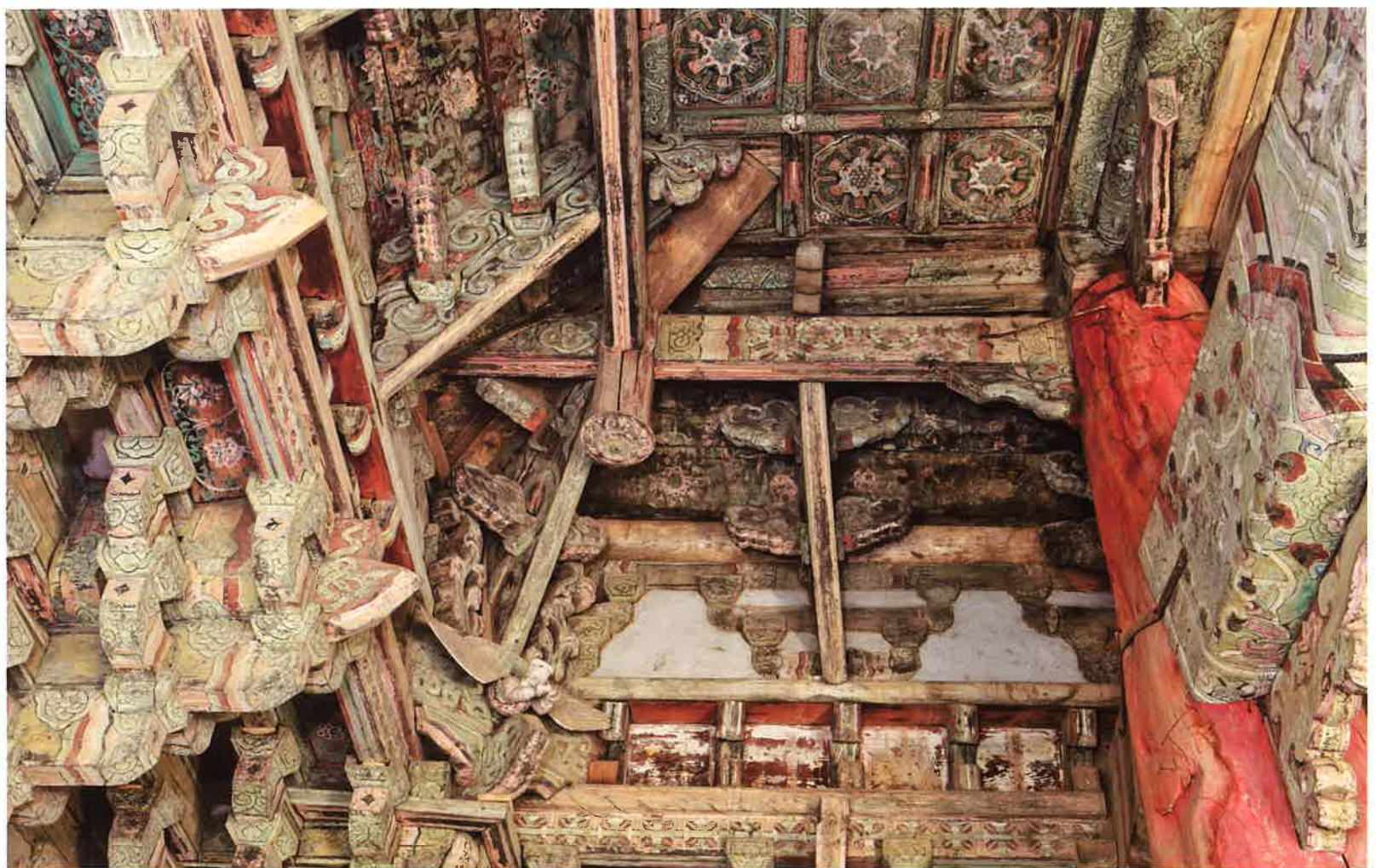
보광전 내부 서쪽 공포 / 普光殿 内部 西側 棋包 / western brackets, Pogwangjŏn hall
