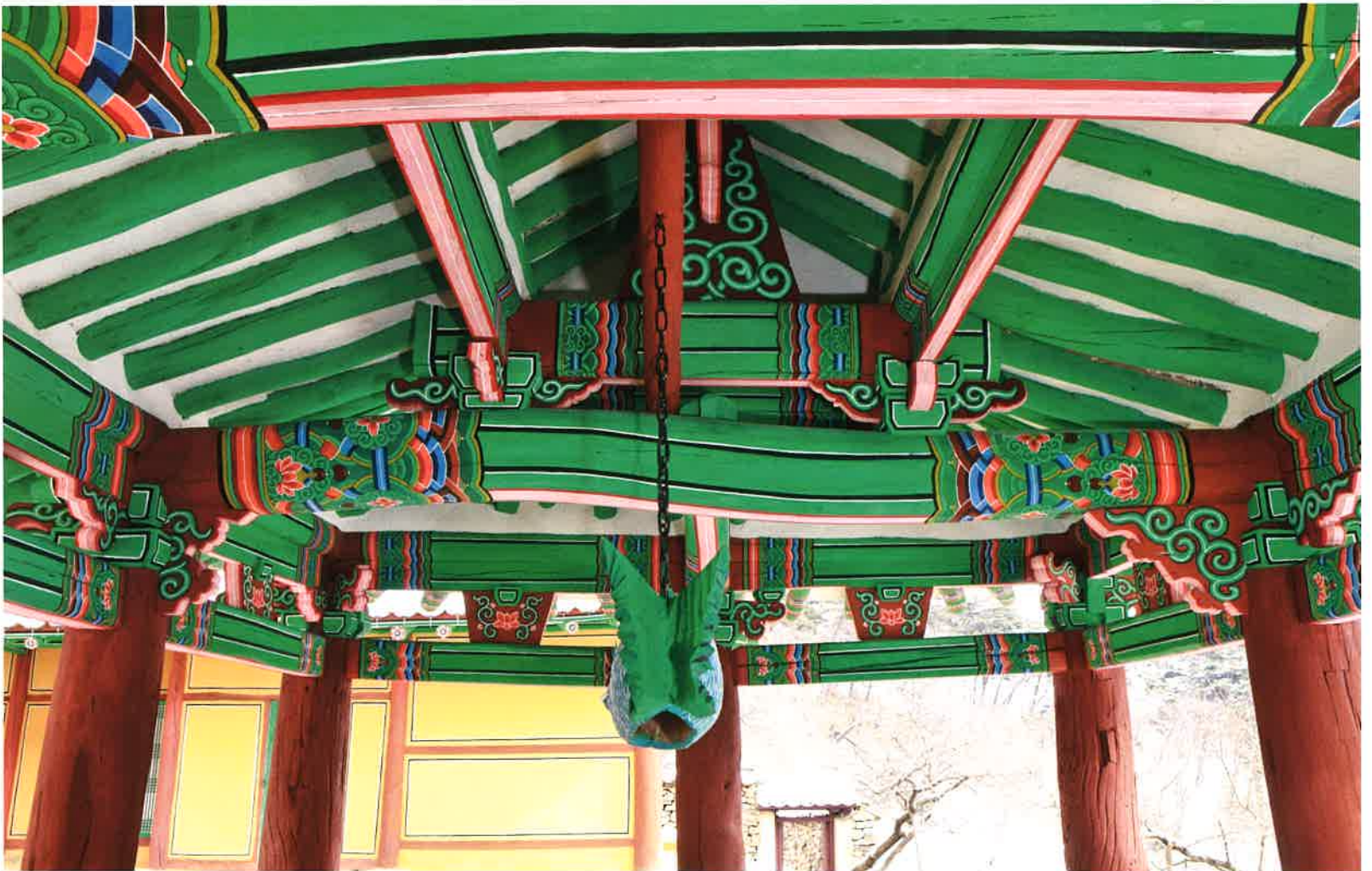
청풍루 내부 동쪽 반자 / 淸風樓 內部 東側 天障 / eastern ceiling, Ch'ongp'ungnu
