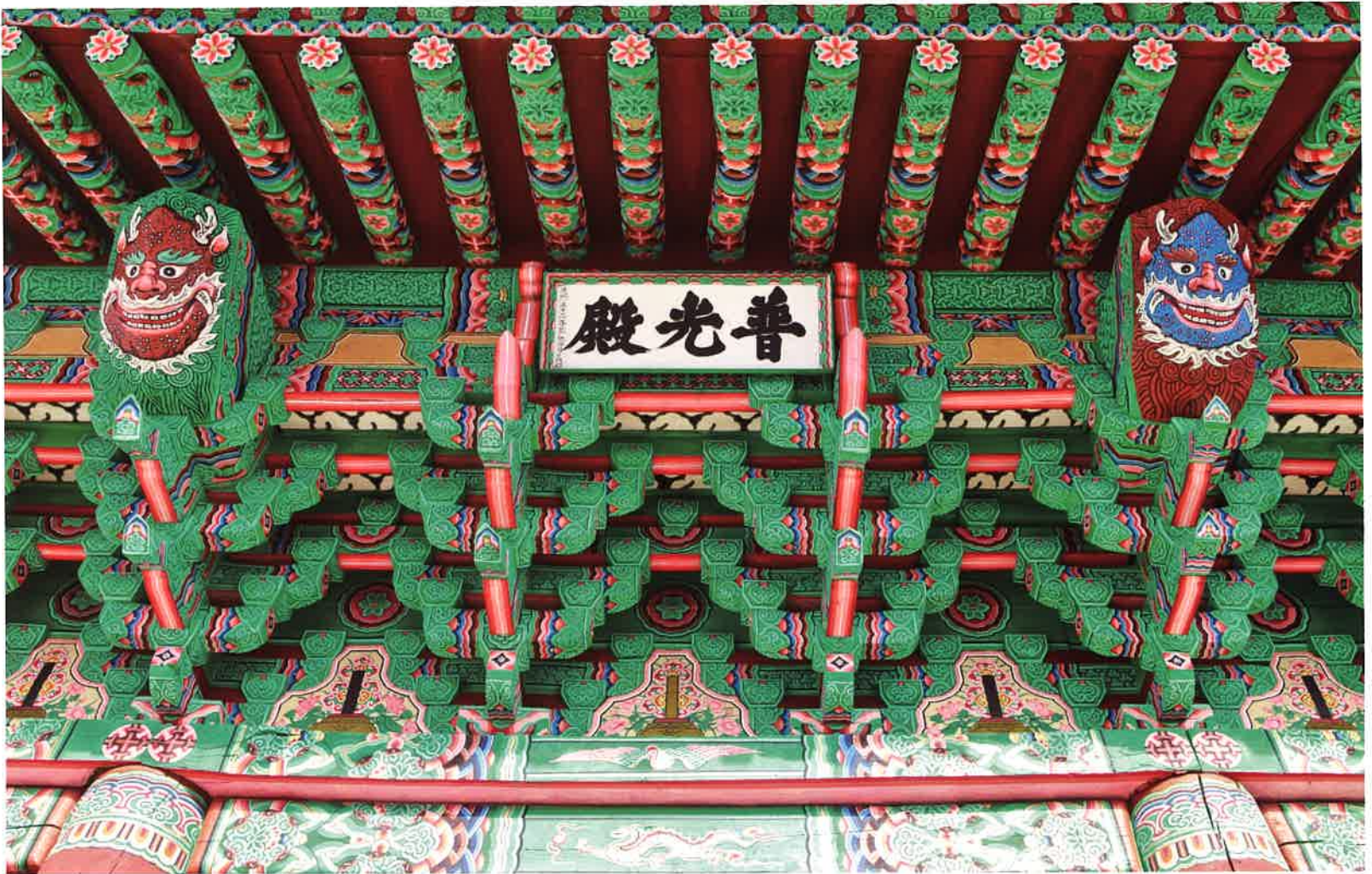
보광전 앞면 공포 / 普光殿 前面 栱包 / front brackets, Pogwangjeon hall
