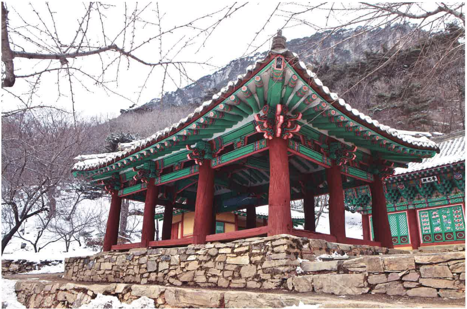
보수 후 청풍루 / 補修 後 淸風樓 / Ch'ongp'ungnu(after being repaired)
