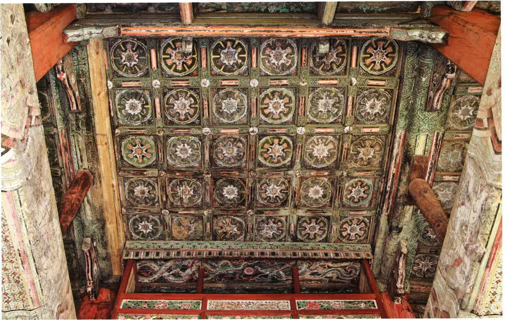
보광전 내부 소란반자 부분 / 普光殿 內部 格子天障 部分 / part of latticed ceiling, Pogwangjŏn hall
